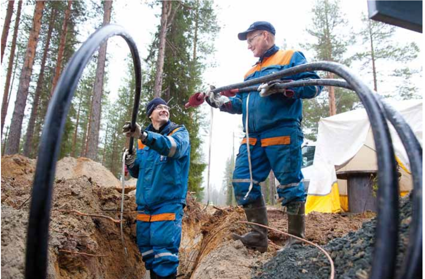
Uudet sähkölinjat rakennetaan pääosin maakaapeleilla.
