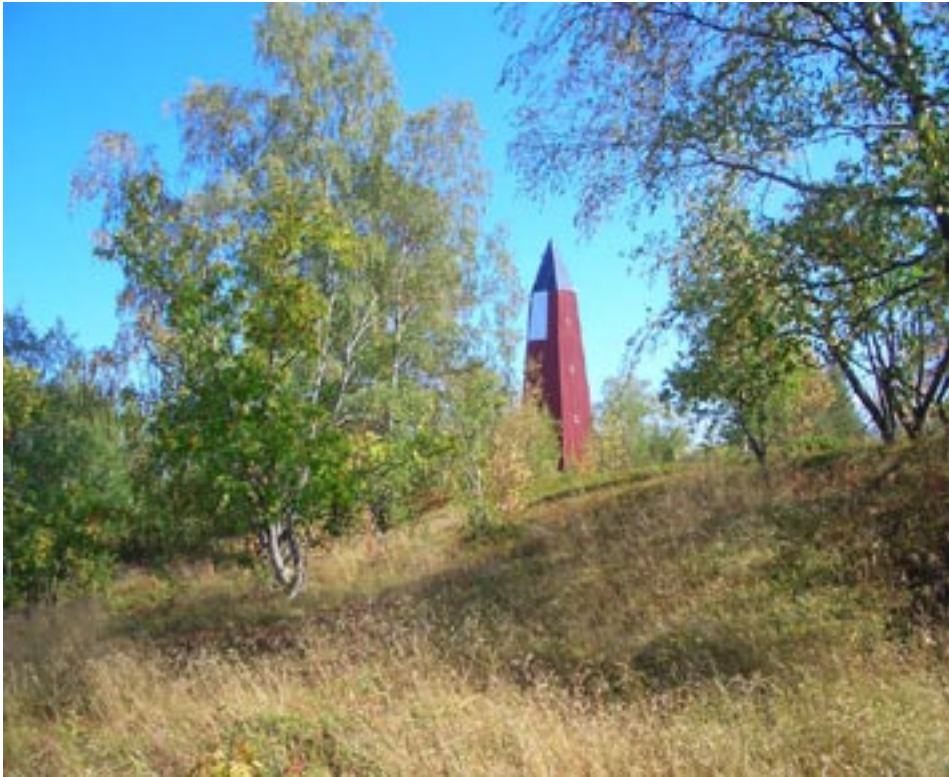
Lähellä Ulkokorunin tutkimusasemaa on 29,6 metriä korkea puupooki, joka on kauas näkyvä tunnusmajakka. Se on rakennettu 1874.
