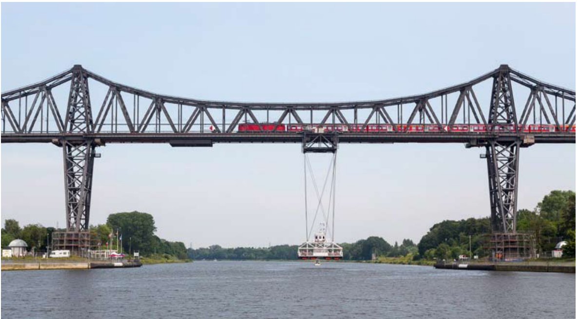
Kuva 4. Rendsburgin tunnus on Kielin kanavan ylittävä rautatiesilta, jonka alla autot siirretään kanavan yli vaijerien varassa roikkuvassa korissa.
