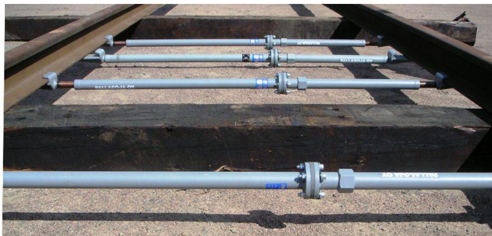
Neljän säätötangon asennus
