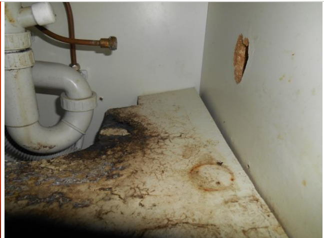
Allaskaapin hyllylevyt ovat kosteusvaurioituneet. Altaan sekoittajasta astianpesukoneelle menevän vesiputken päästä on joskus valunut vettä hyllytasolle.
