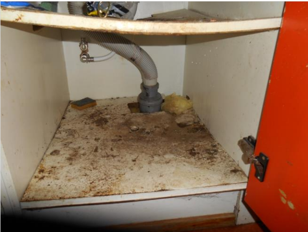
Allaskaapin hyllylevyt ovat kosteusvaurioituneet. Altaan sekoittajasta astianpesukoneelle menevän vesiputken päästä on joskus valunut vettä hyllytasolle.
