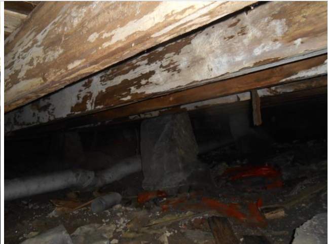
Keittiön ja pesuhuoneen kohdalla on alapohjan kantavissa palkeissa ja pohjalaudoituksessa lahottajasienen kasvustoa ja lahovauriota.
