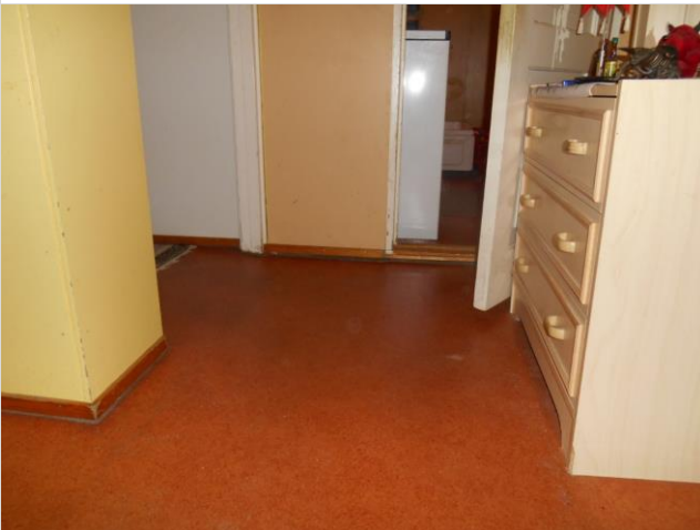
Eteisessä pesuhuoneen puoleisella seinällä on lattialistan alla noin 15-20 mm:n rako.
