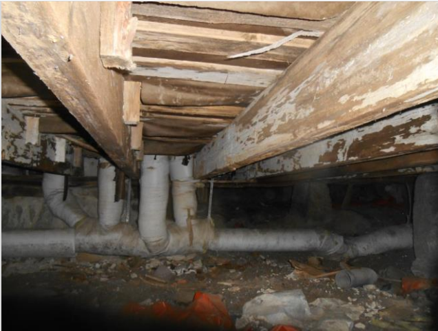
Keittiön ja pesuhuoneen kohdalla on alapohjan kantavissa palkeissa ja pohjalaudoituksessa lahottajasienen kasvustoa ja lahovauriota.
