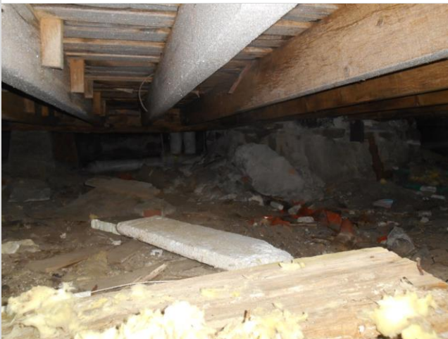
Kuvat olohuoneen kohdalta. Oikean puoleinen kuva on otettu aikaisemman tarkastuksen yhteydessä 18.8.2014. Tästä kuvasta on nähtävissä olohuoneen kohdalla heikon tuuletuksen aiheuttamaa mikrobikasvustoa.
