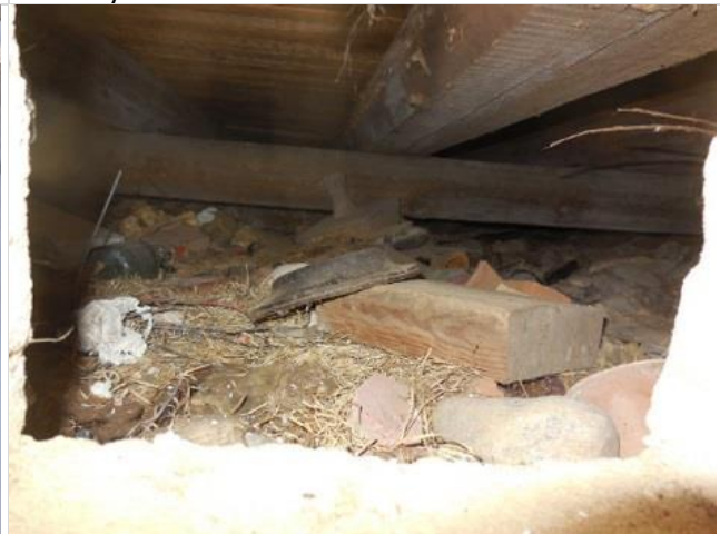
Näkymä etupihan puolelta alapohjaan.
