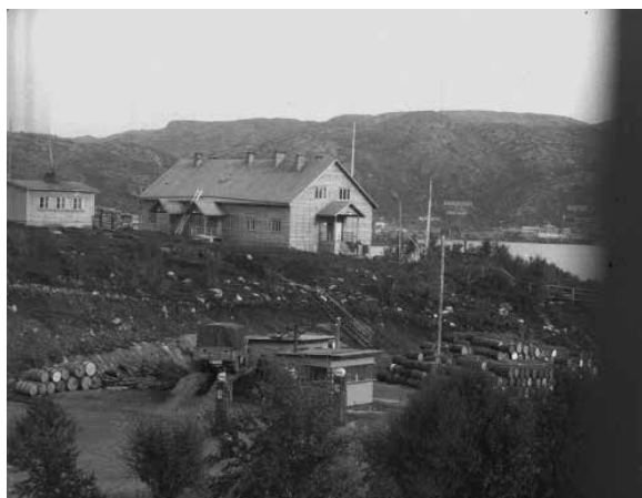
Pohjolan-Liikenteen Liinahamarin toimitalo ja polttoainejakamo
