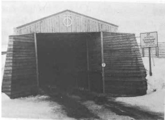
”Työjärjestö Todtin rakentama 8,3 km pitkä lumitunneli Reichsstrasse 50:llä.
