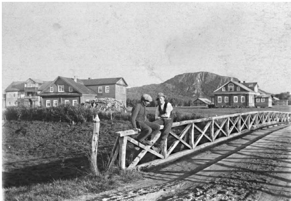
Myöhemmin rakennettiin autolla ajettavia siltoja.
