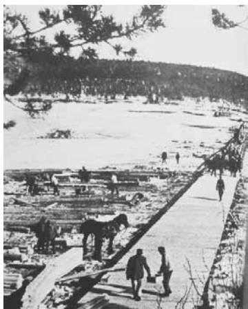
Hakkapeliitan toimittaja kuvasi Nyrudin sillan rakentamista Norjan puolelta kuorma-auton lavalta huh-tikuussa 1941.
