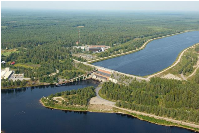
Kuva 3. Raasakan voimalaitos (Kuva: Suomen Ilmakuva Oy)[6]
