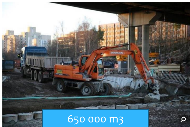
Pasilan jättimonttu on Euroopan suurimpia, ainakin liikerakennusten sarjassa. Kuva: Yle
