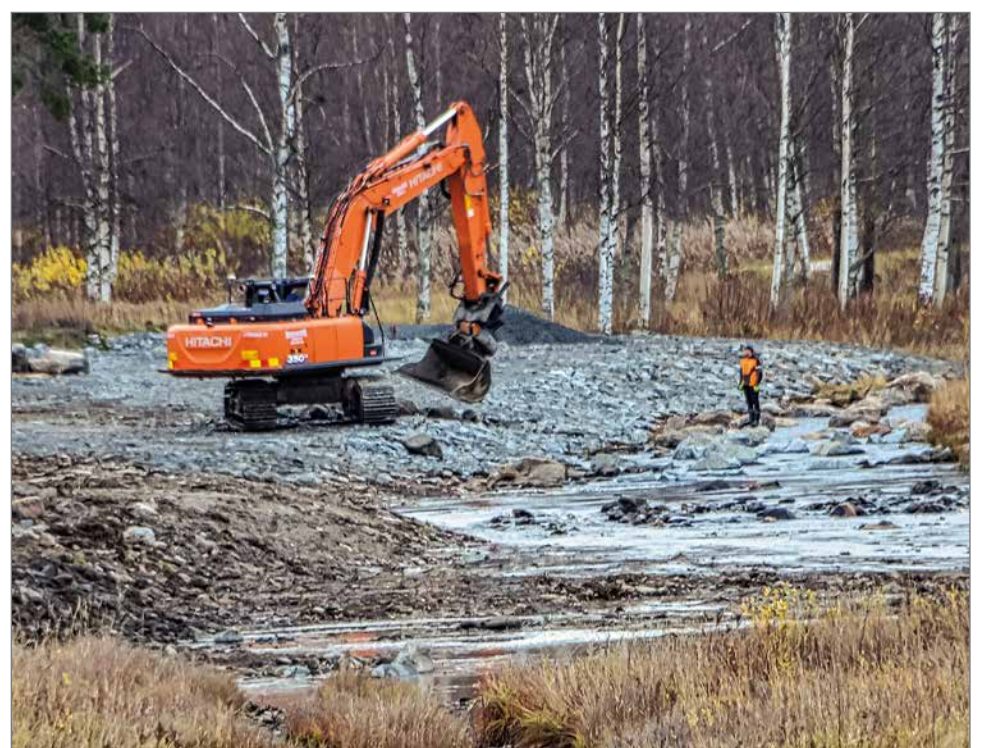
Kaivinkone työssä (sillalta otettu kuva).
