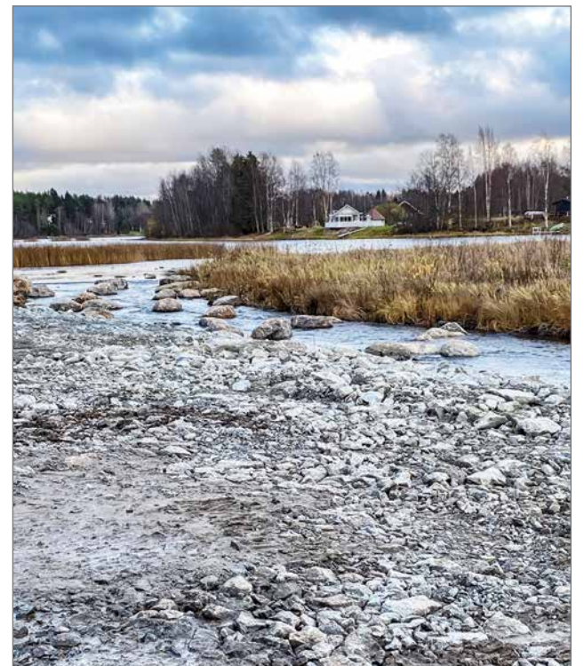
Jokiuoman luiskan maisemointia ja verhoilua, myös uomaan on asetettu kiviä kalojen nousua helpottamaan.
