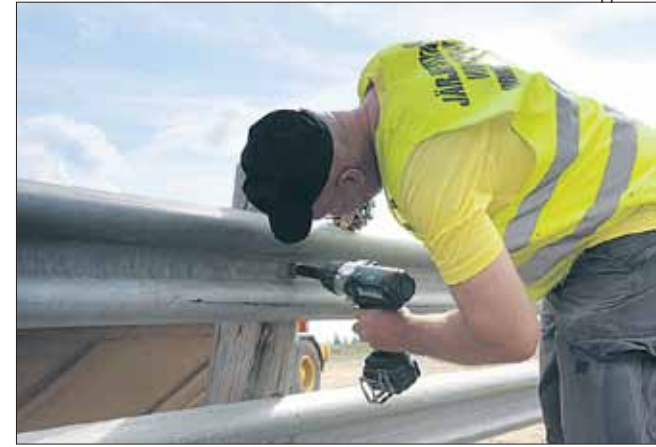
Kisan alkupuolella tapahtunut kaiteen irtoaminen keskeytti kisan vain hetkeksi, kun tolpat oioittiin ja pultattiin uudelleen kiinni kaiteeseen. Esimerkkiä näytti Kalevi Moilanen, joka oli ensimmäisenä porakoneen kanssa pulttaamassa kaidetta kiinni.
