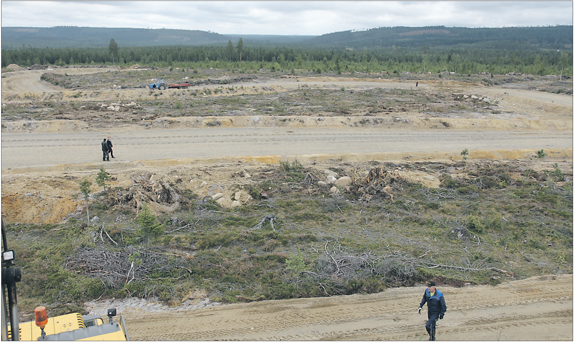
Roninkankaan jokkisrata on jo rakennettu, pohja on valmis ja radalta puuttuvat enää asfaltointi ja radan pinnoitus.
