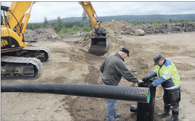
Moottorikerhon puheenjohtaja Kalevi Moilanen ja Jorma Riipi asentamassa sadevesikaivoa radalle.
