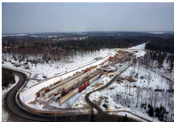
Kuvat 3 ja 4. Kivistön tunneliasema muotoutumassa ja valmis kansirakenne odottamassa päällystettä.
