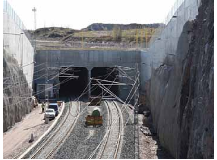
Kuva 2. Läntinen suuaukko, 600 metrin betonitunneli valmiina, pehmeikkö alkaa kallioleikkauksen jälkeen.
