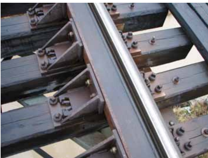
Kuva 4. Ajokiskon ja suojakiskon yhdistävä pölkkyaisa.
