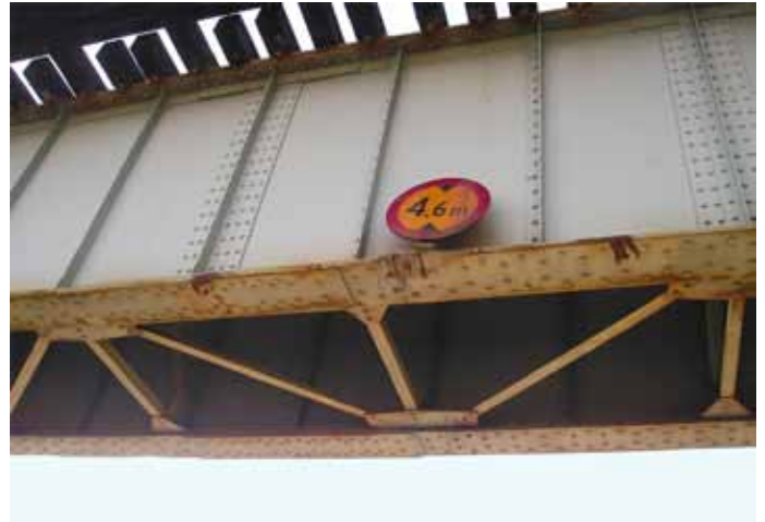
Kuva 6. Mahdollisella uudella sillalla vähennetään myös riskiä siihen, että ajoneuvoliikenteen törmäykset siltaan keskeyttäisivät rautatiekuljetuksia.
