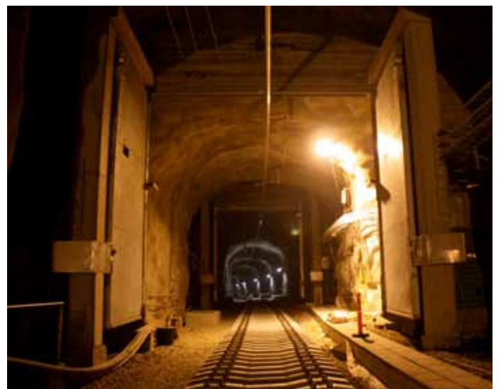
Kuva 12. Tunneliasemilla on molemmissa päissä neljä savuovea, jotka ovat turvalaiteriippuvaisia.
