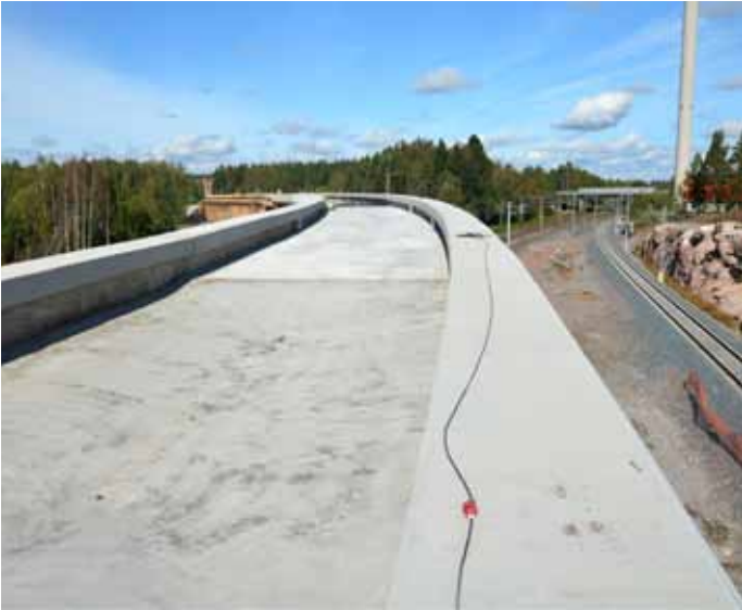
Kuva 9. Rakenteilla oleva Havukosken risteyssilta, jossa reunapalkit kantaa kuormat, silta valmistui 2013.
