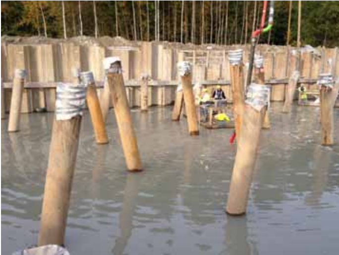
Kuva 5 ja 6. Lapinkylän vesitiivis kaukalo rakenteilla ja valmiina.
