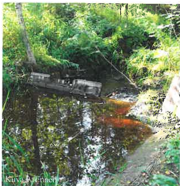
Kuva 9-10. Kohmujoella jakson 3 patopaikka ennen ja jälkeen kunnostuksen. Poistetun padon kohdalle muotoiltiin kivimateriaalista tekokoski, joka säilyttää vakiintuneen padotusvaikutuksen, mutta mahdollistaa samalla kalojen ja muiden vesieliöiden vapaan liikkumisen uomassa. Kuvaussuunta alavirtaan.
