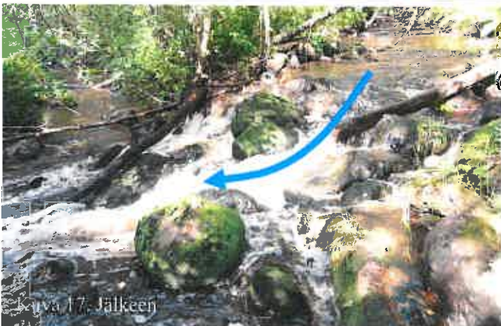
Kuva 16-17. Peltojoen Myllykosken mahdollinen nousueste ennen ja jälkeen kunnostuksen. Kivien ja puiden avulla valtaosa virtauksesta ohjattiin keskiuomaan, jota myös loivennettiin kiveämällä. Nyt kaloilla on selkeämpi liikkumisväylä ylävirtaan myös vähän veden aikaan.
