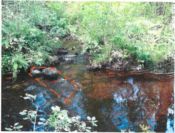
Kuva 19. Myllykosken sivu-uoman avaritettu suualue, osittain veden alla oleva suiste (katkoviiva) ja kutosoraikko oikealla.
