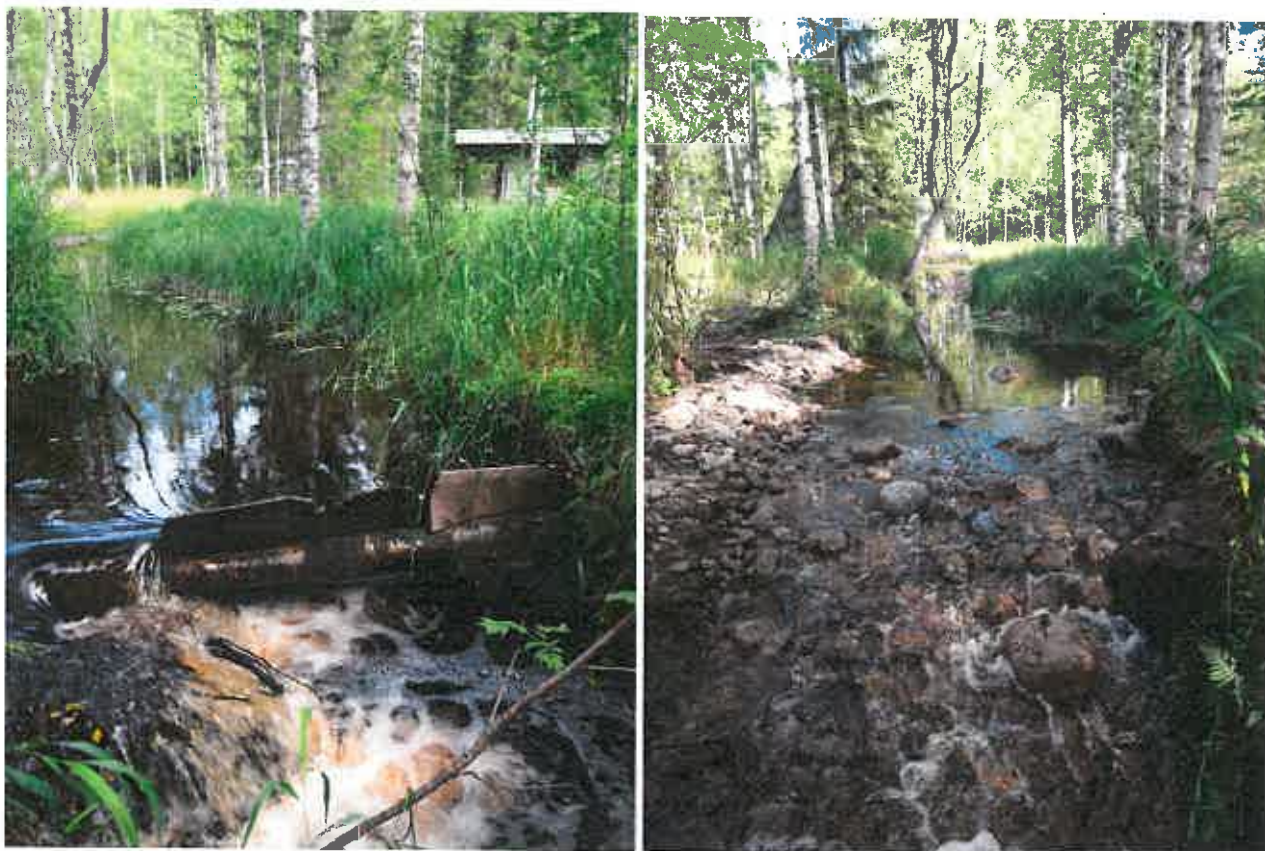
Kohmujoen patopaikka jaksolla 3 ennen ja jälkeen kunnostuksen.
