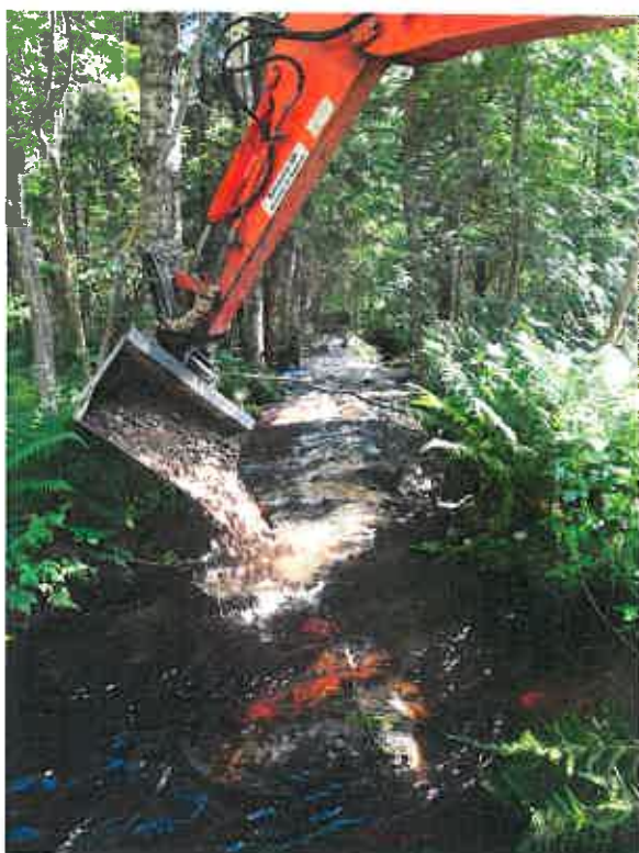
Kuva 6. Kutusoran levitystä kosken niskalle Sopukassa.
