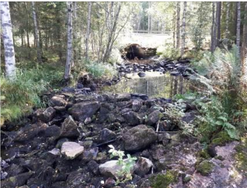
Kuva 53. Kivikynnykset Kotajoen jaksolla 28.
