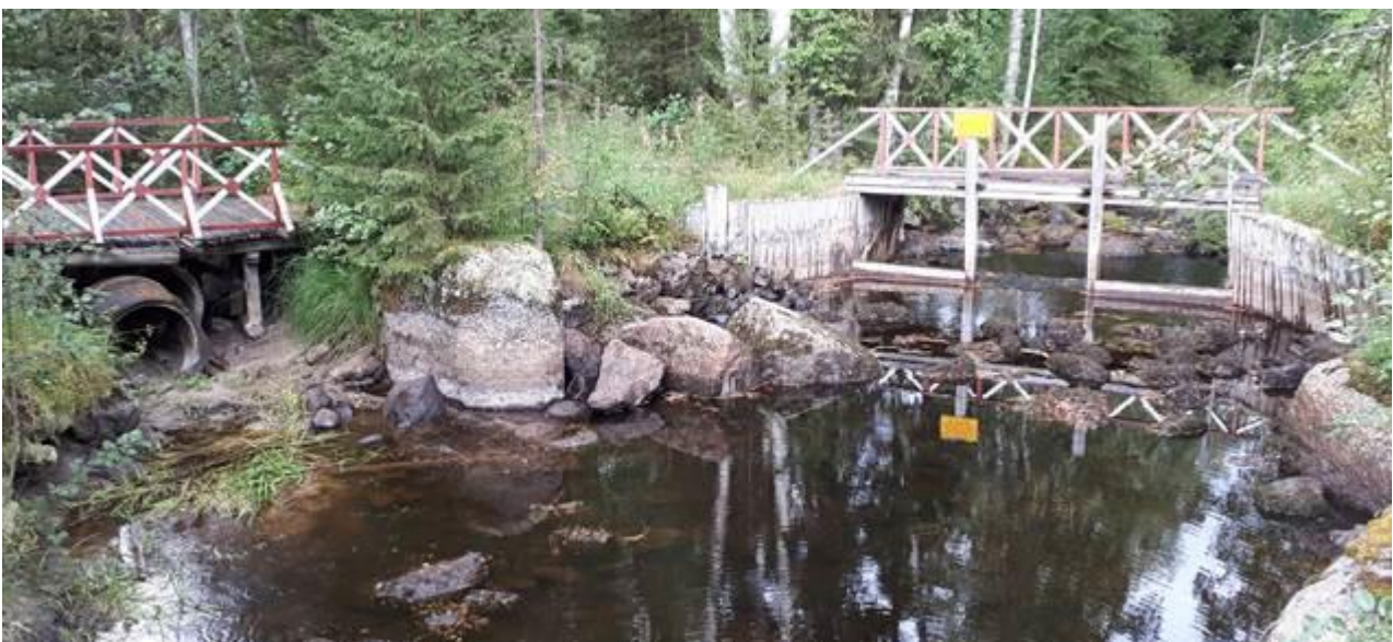
Kuva 32. Päistärkosken pato oikealla, myllylle ja sahalle vettä vievä uoma vasemmalla.
