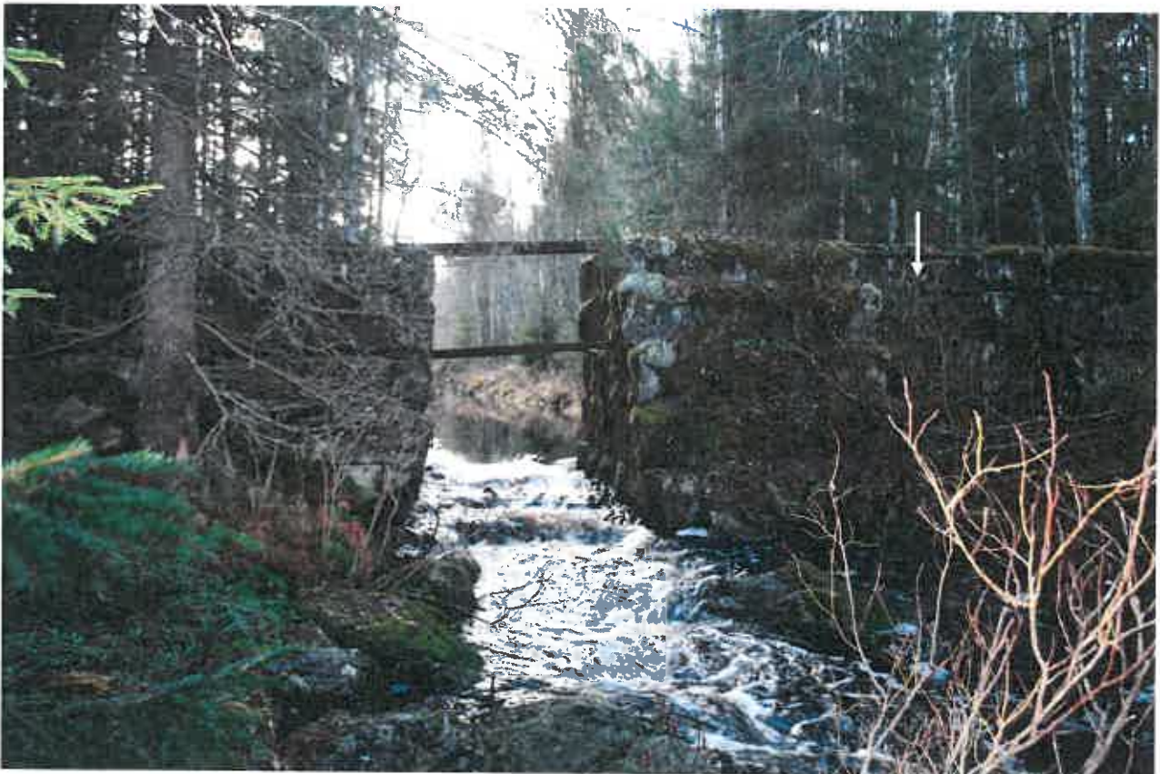
Kuva 33. Hetonjoen jyhkeä säännöstelypato jaksolla 6. Tulva-aukko oikealla (nuoli).
