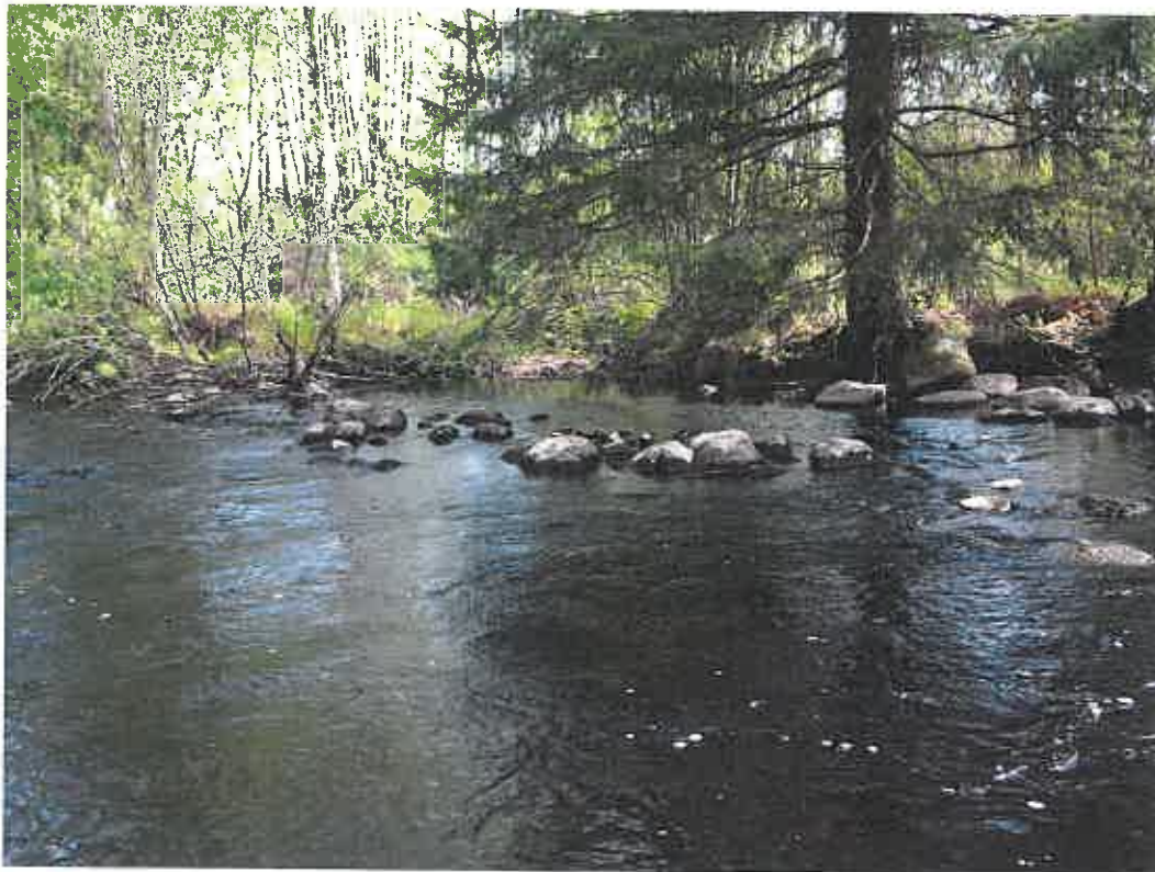
Kuva 4. Vihanninjoen virta-aluetta ja vedenohjaukseen tehty kivisuiste jaksolla 2.
