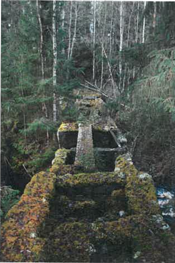
Kuva 34. Säännöstelypato päältä, virtaus vasemmalta oikealle.
