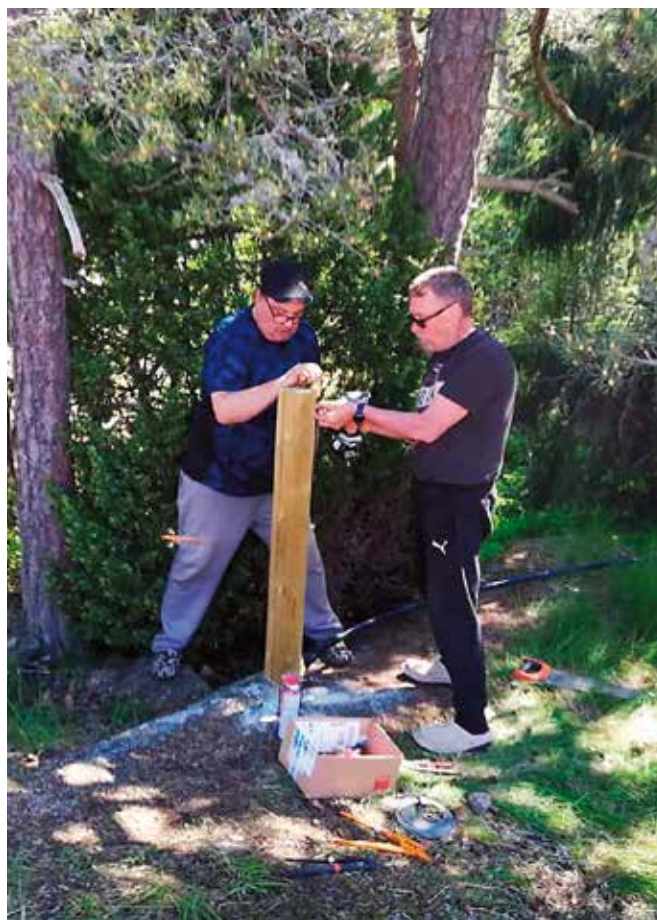
Uuden vesipisteen asennus yläkalliolle.
