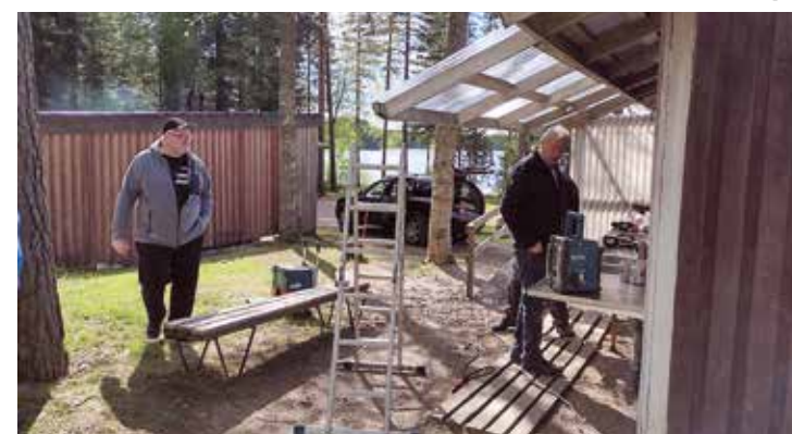
Pepe ja pari Hannua tiskipaikan katoksen saneerauksessa.
