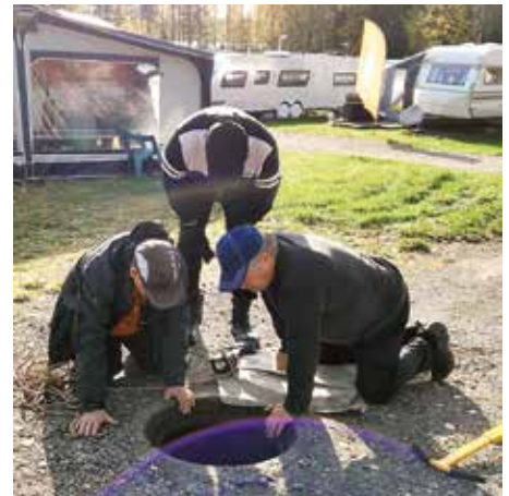
Jätevesikaivoon asennettiin ylivuotovahti.
