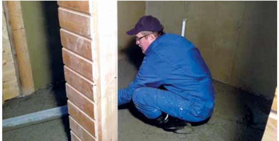
Betonit valutalkoisiin tulivat Loimaalta. Pumppuauton varressa pituutta riitti.
