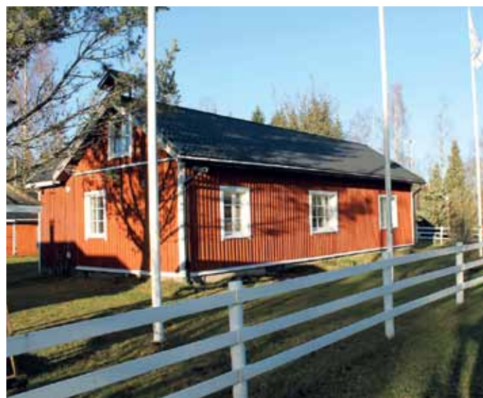
Tässä kuvassa tuvan ulkovuori lähes valmis, kuva otettu 2013. Jälkeenpäin on tapahtunut paljon muutosta ja tuvan ulkovuori on täysin valmis.
