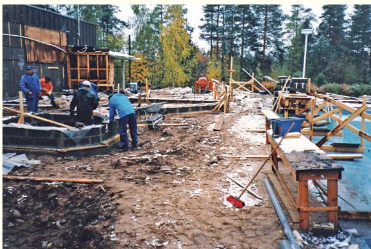
Allasalueen edusta rakenteilla, räntää ja lunta kirvesmiesryhmän harmina.
