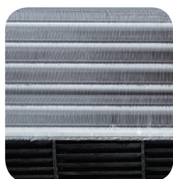
Sisäyksikön lämmönsiirrin 10 vuoden jälkeen ilman pinnoitusta.
