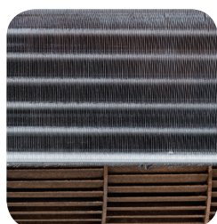
Sisäyksikön lämmönsiirrin 10 vuoden jälkeen ilman pinnoitusta.
