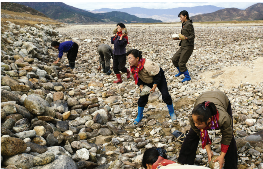
ECHO:n ja Punaisen Ristin tuella rakennetaan tulvavallia, joka estää nousevaa vettä pilaamasta viljelysmaita. (kuva: Benjamin Suomela / Suomen Punainen Risti)
