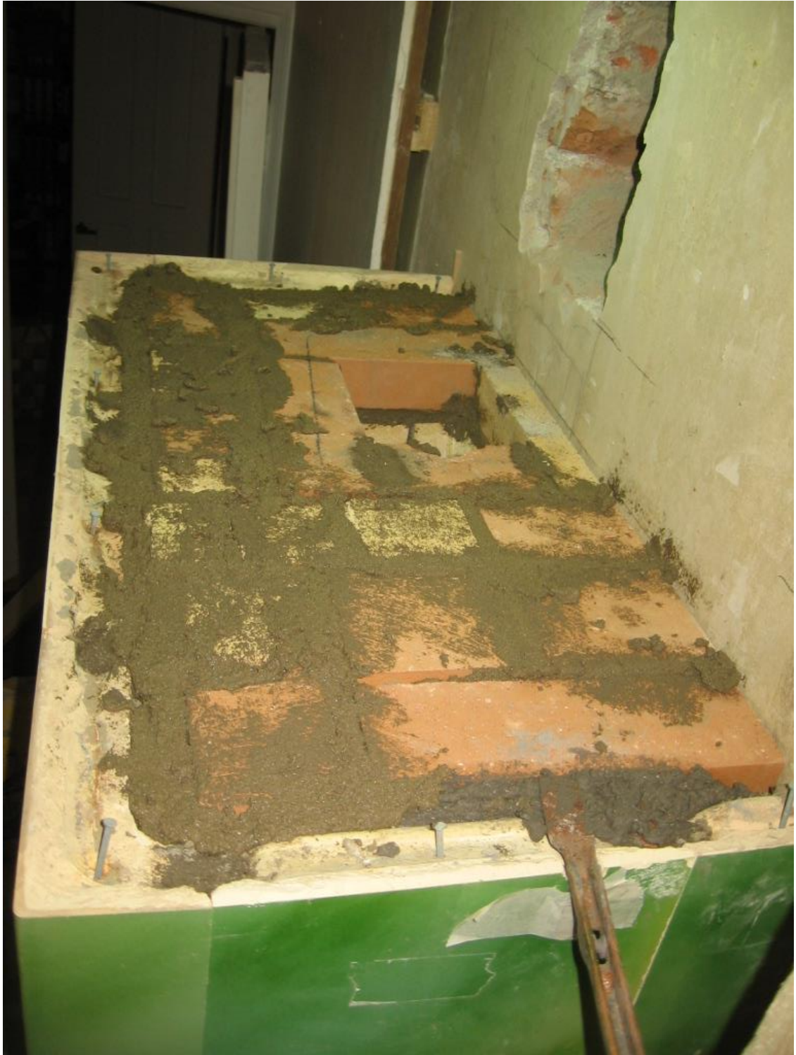
Kuva 78 Muurarin on pian nostettava hapon kestävästä teräksestä hitsattu hormiliituskappale paikoilleen. Teräksinen liittokappale varmistaa hormiliitoksen pysymisen ehjänä, kun uuni kasvaa korkeutta lämpölaajenemisen aikana.
