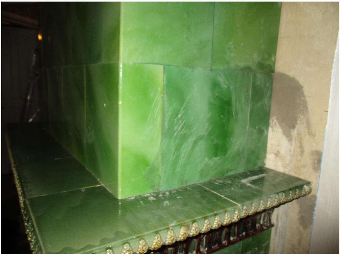
Kuva 105 Sauma-aine pestään pehmeällä sienellä pois kaakelien pinnasta.
