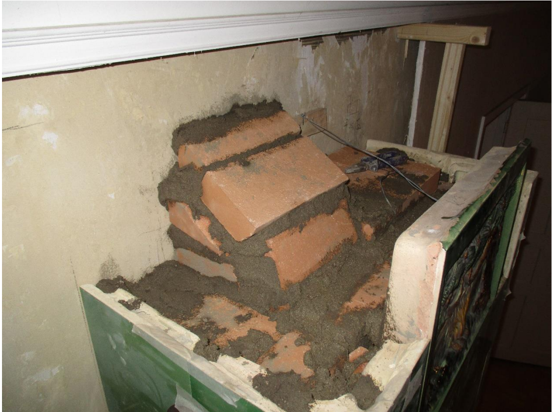
Kuva 93 Koristekaakeli kiinnitetään rautalangalla ja muurataan paikoilleen.
