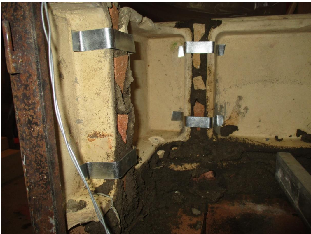
Kuva 39 Kaakelien ollessa paikoillaan voidaan jatkaa uunin sisärakenteiden muurausta.
