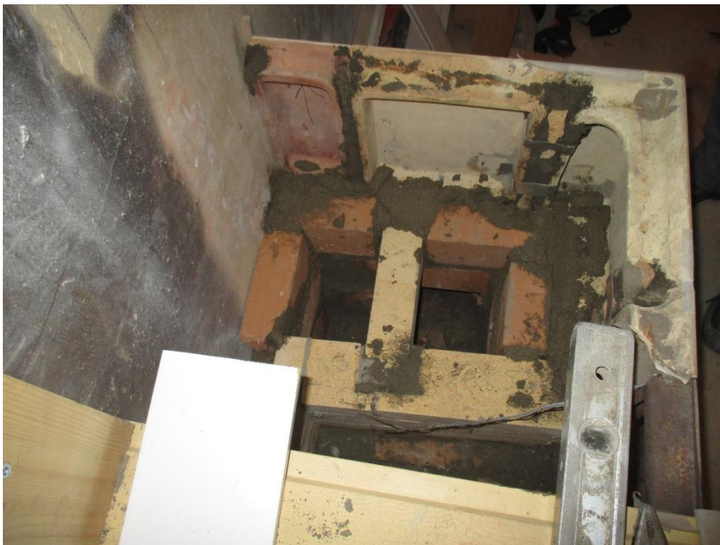
Kuva 44 Välitunkka erottaa poskikanavat toisistaan.
