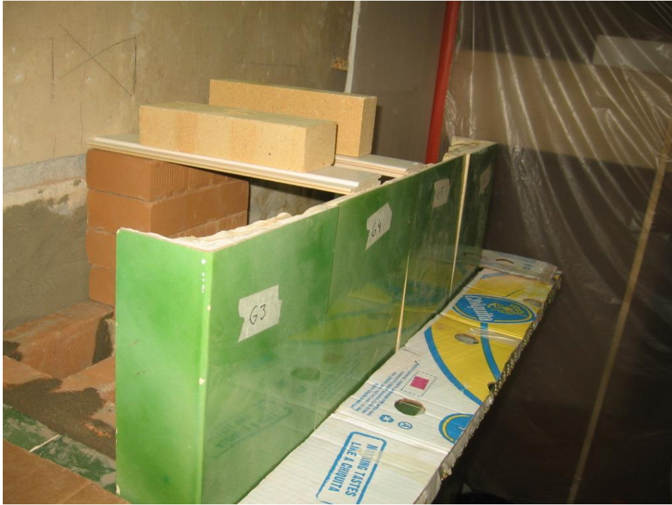
Kuva 60 Koristekaakeliä muodostama hylly suojataan pahvilla, jotta sitä ei kolhita ylhäältä putoavilla tiilen paloilla, joita syntyy muurarin työstäessä tiiliä vasaralla.
