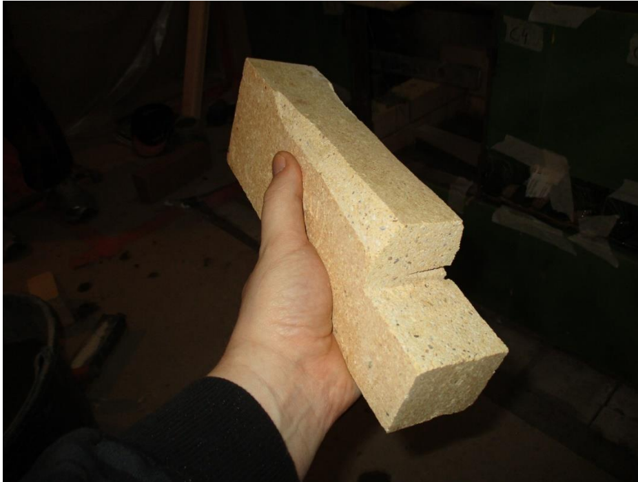
Kuva 40 Uunin sisällä aletaan erottaa etummaisista ja takimmaisista poskikanavia toisistaan. Muurari muotoilee alimmaisen välitunkan eli väliseinän tiilen niin, että saa lukittua sen paikoilleen. Välitunkan alareuna pyöristetään, jotta savukaasuihin ei muodostu pyörteitä, jotka haittaavat vetoa.
