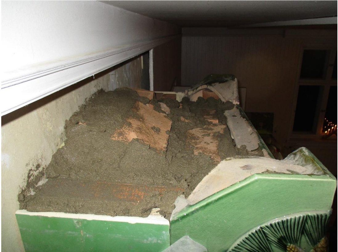
Kuva 97 Uunin yläosa on muurattu umpeen.
