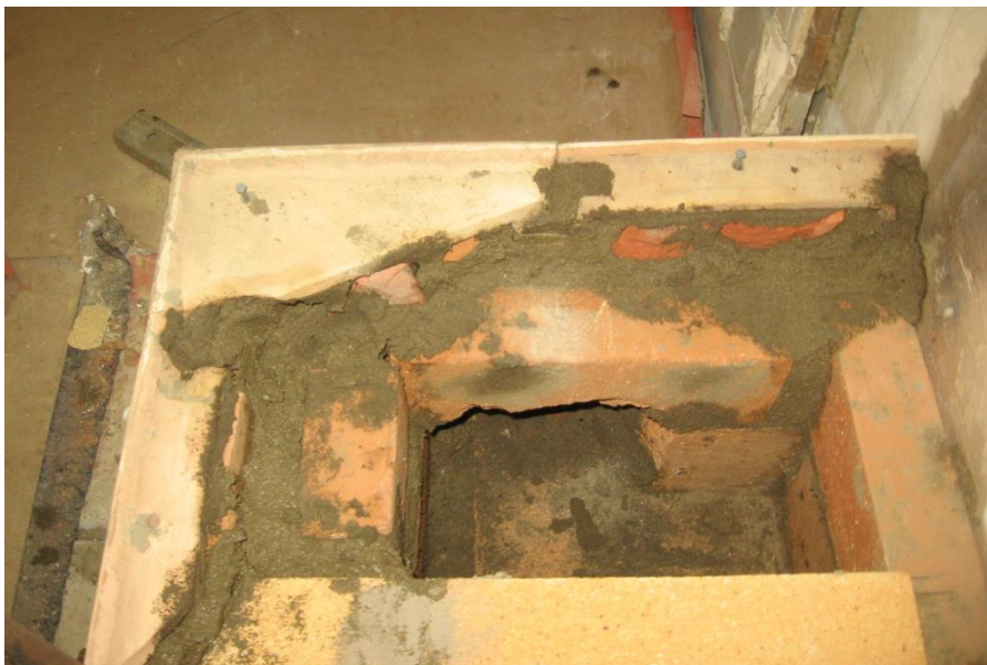
Kuva 32 Kuppien ollessa täytetyt paksunnetaan uunin seinämiä muuraamalla syrjätiilikkerros kaakeleiden taakse. Toisin kuin moderneissa varaavissa tulisijoissa, ei kaakeliuunissa ole erillistä kuori- ja runkorakennetta. Runko ja kuori ovat yhtä.
