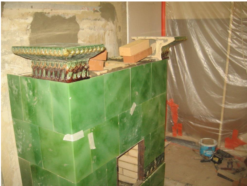
Kuva 55 Isojen, painavien ja ulkonevien koristekaakelien muuraaminen vaatii suurta ammattitaitoa.
