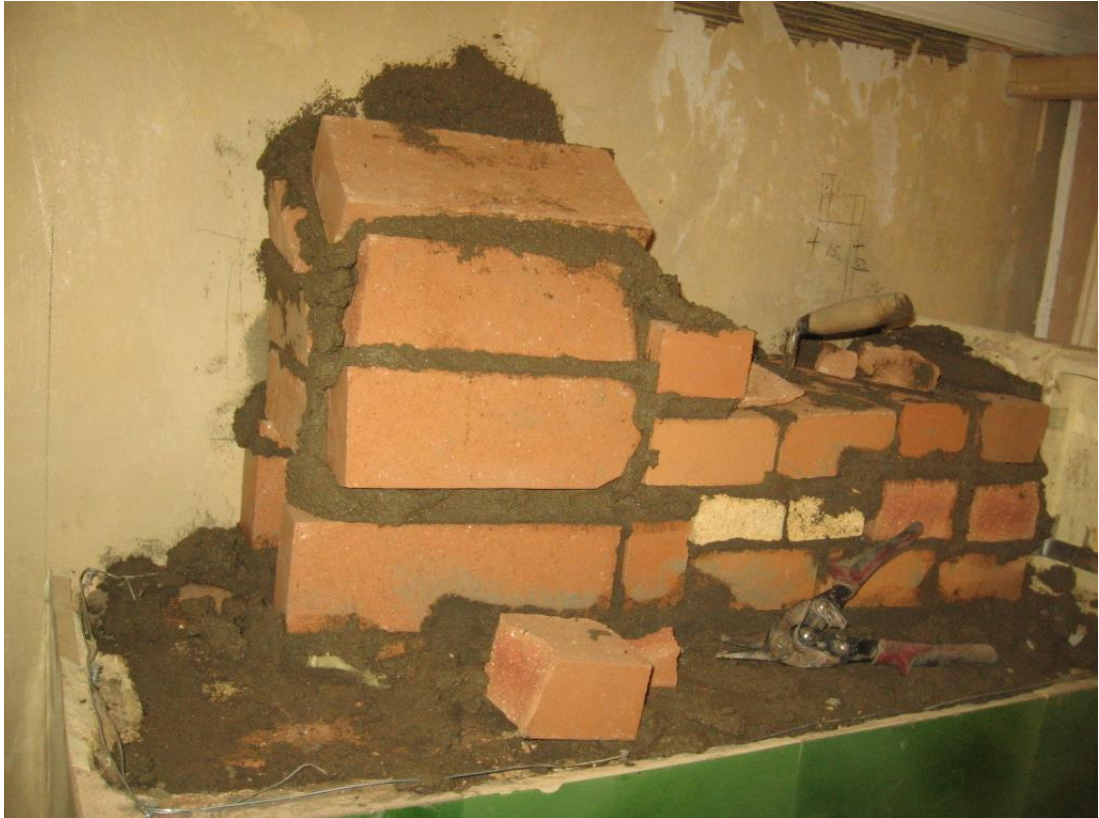
Kuva 87 Hormiliitos sekä ylempi savupelti muurataan piiloon.
