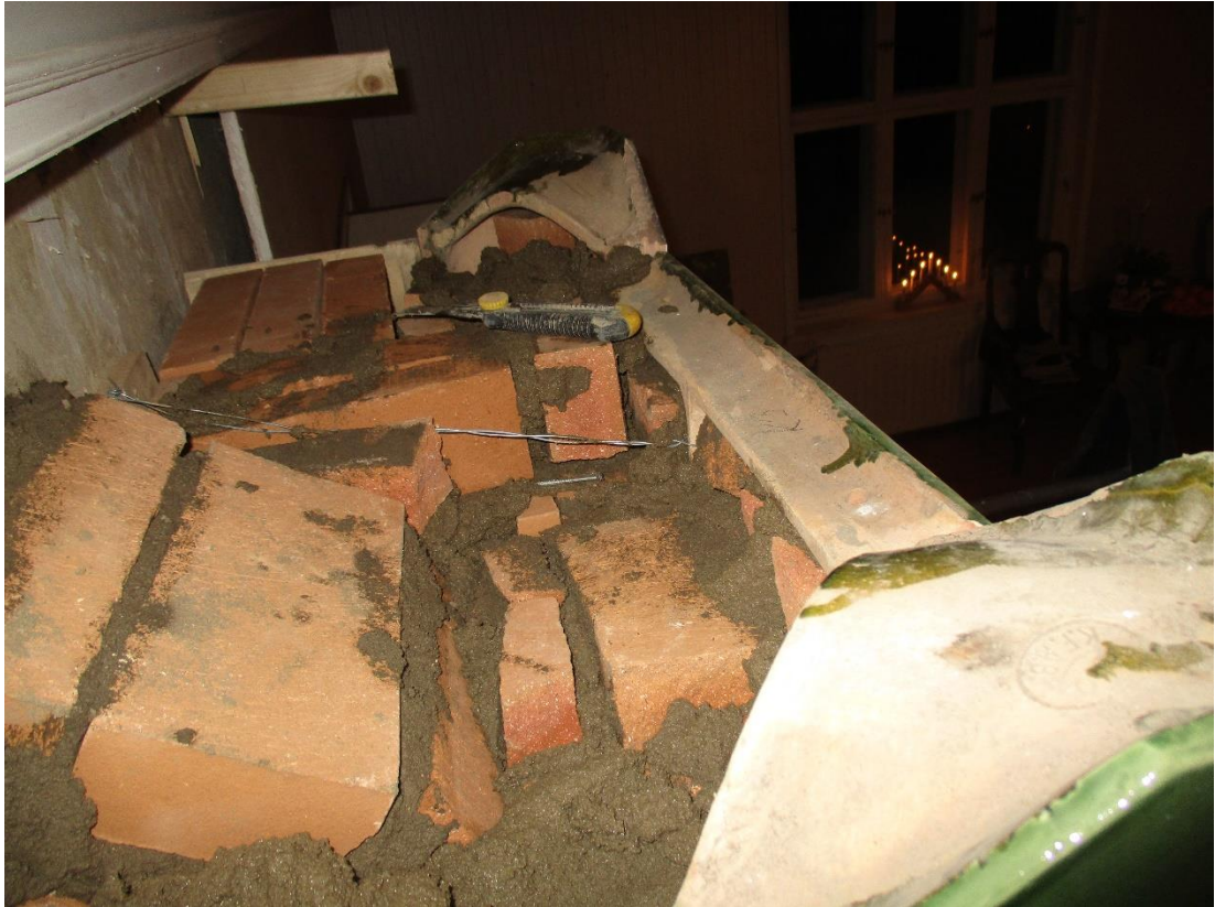
Kuva 95 Kun kaikki kaakelit ovat paikoillaan, on muurattava uunin yläosa umpeen.
