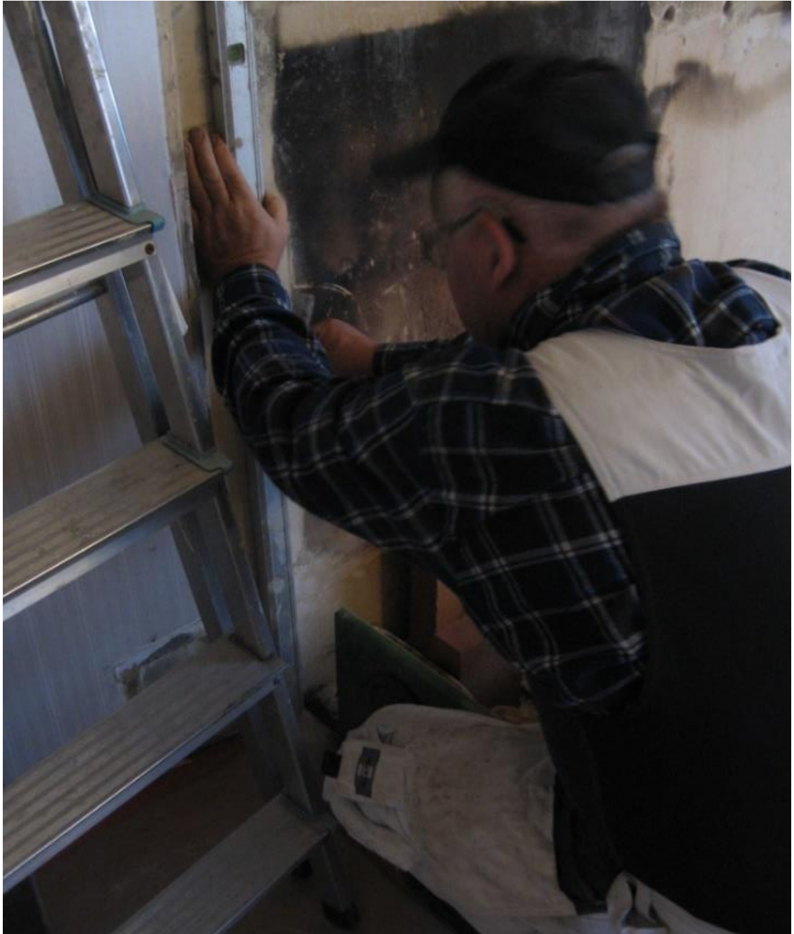
Kuva 3 Kun alin kaakelivarvi on ladottu paikoilleen ja uunin sijainti on tarkistettu, muurari piirtää palomuurin eli tulevan uunin takana olevaan seinään pystysuorat viivat muuraamisen helpottamiseksi. Palomuurin pystysuoruus tarkistetaan, jotta tiedetään, että joudutaanko uunia syvyyttä ylempänä muuttamaan.
