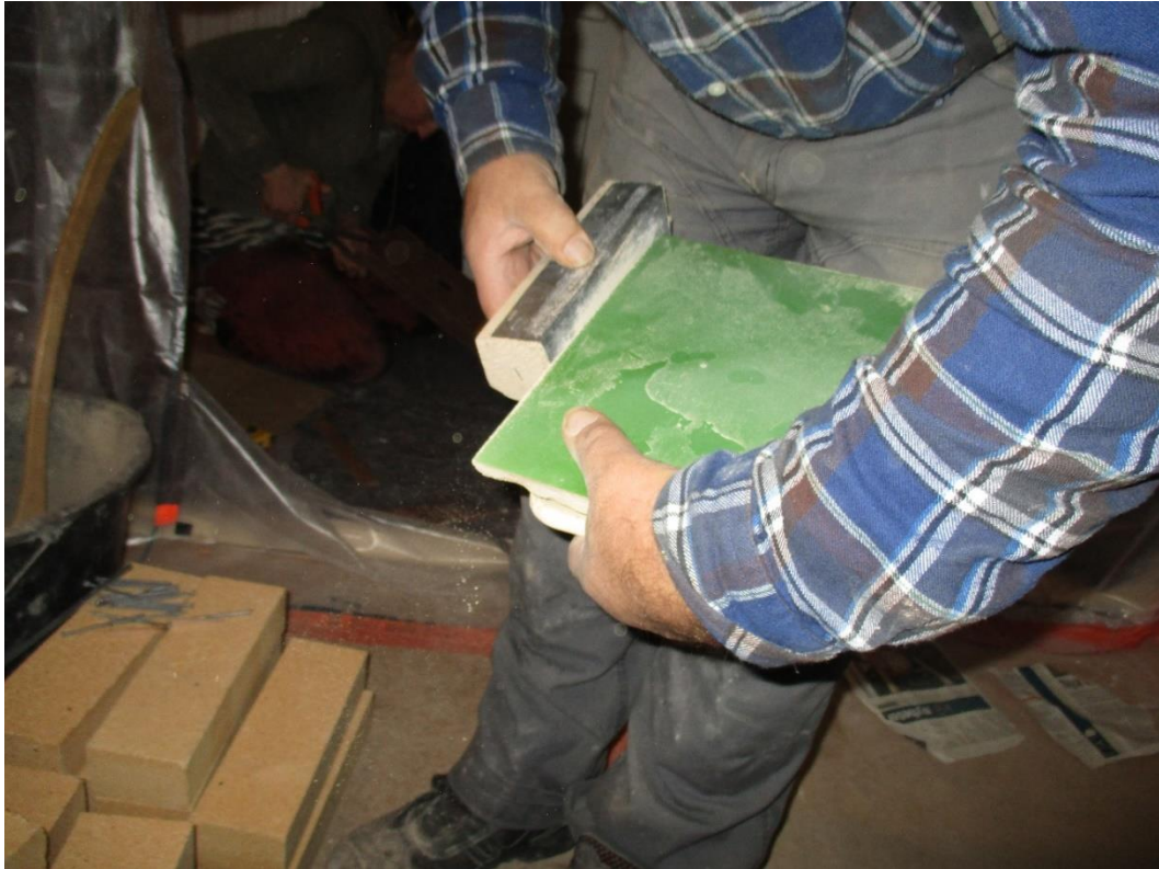
Kuva 21 Pienimmät työstöt ja viimeistelyt tehdään käsin hiomapaperilla.
