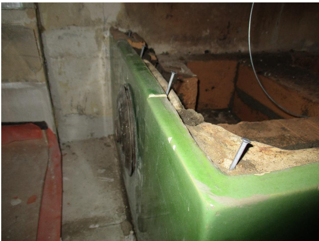
Kuva 11 Lämpölaajenemisen vuoksi uunin takaseinän sekä palomuurin välissä ei käytetä laastia. Lämmitessään uuni kasvaa korkeutta ja vastaavasti jäähtyessään kutistuu.
