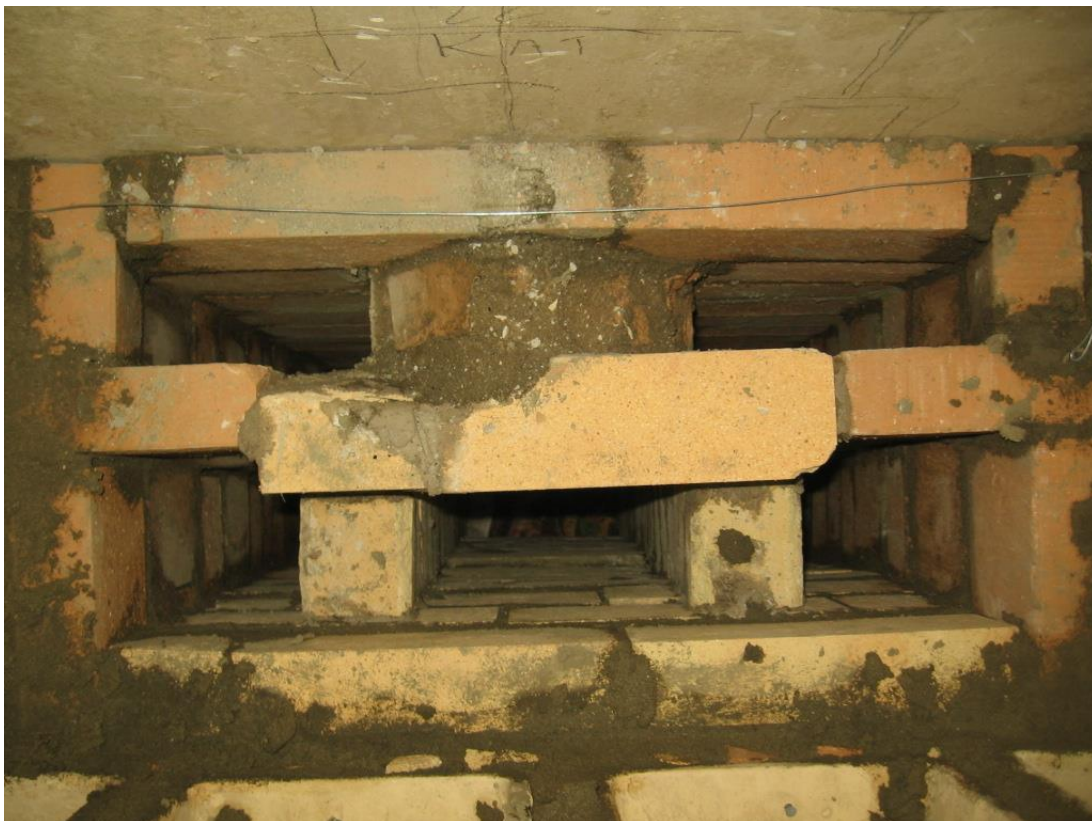
Kuva 69 Taaempia kanavia aletaan siirtää keskemälle uunia.
