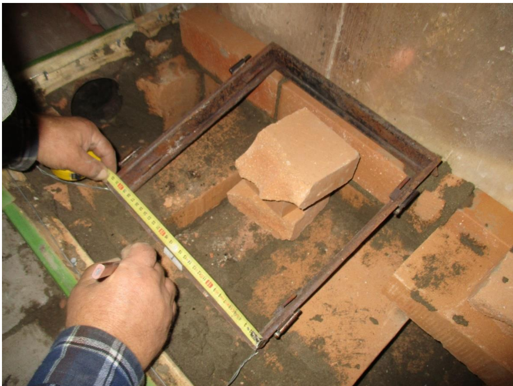
Kuva 16 Jotta uunista tulisi mahdollisimman symmetrinen, niin luukut mitoitetaan keskelle uunin etuseinää. Tämä on mahdollista, sillä uunia päätettiin kaventaa noin sentin alkuperäisestä leveydestä, jolloin kaakeleihin saatiin hieman työstövaraa.
