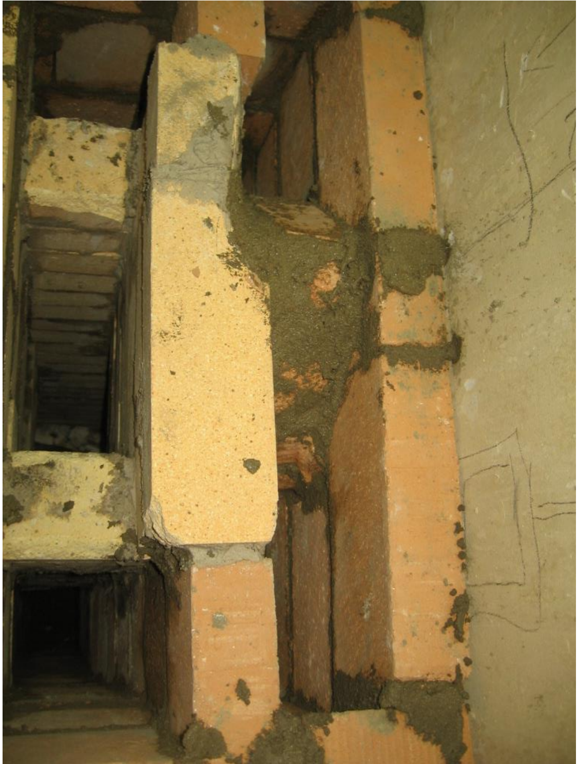
Kuva 67 Teräviä kulmia ei saa olla, jotta savukaasut pääsevät liikkumaan jouheasti. Mitä pyöreämpiä ja sileämpiä savukanavien muodot ovat, sitä parempi veto tulisijassa on.
