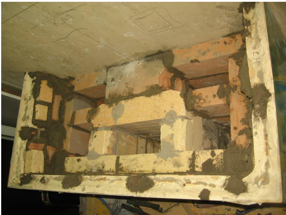
Kuva 61 Uunin noustua on tullut aika jakaa tuliputki kahteen etummaiseen poskikanavaan. Tätä varten välitunkkien ylimpien tiilien reunat pyöristetään, jotta savukaasuihin ei muodostu epätoivottuja pyörteitä.
