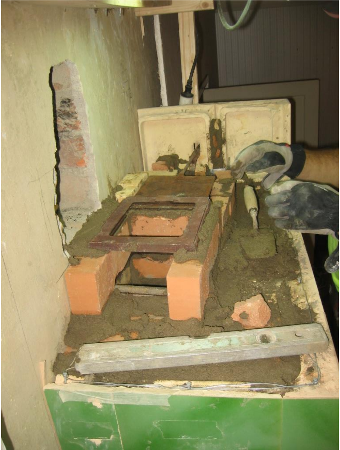
Kuva 83 Ylemmän pellin kehikko on muurattu paikoilleen. Myös ylemmän pellin ympärille muurataan pieni korotus, jotta pelti mahtuu liikkumaan umpimuurauksen alapuolella edestakaisin.
