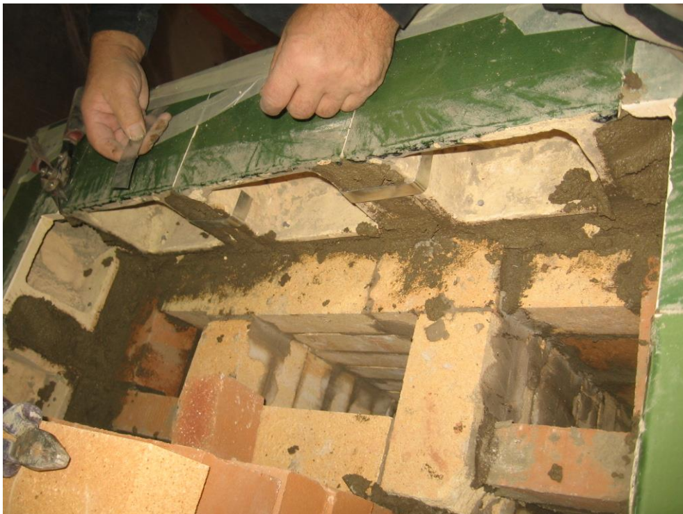
Kuva 58 Koristekaakelit on muurattu paikoilleen, joten seuraavaksi täytetään niiden kupit ja jatketaan sisärakenteiden muuraamista.
