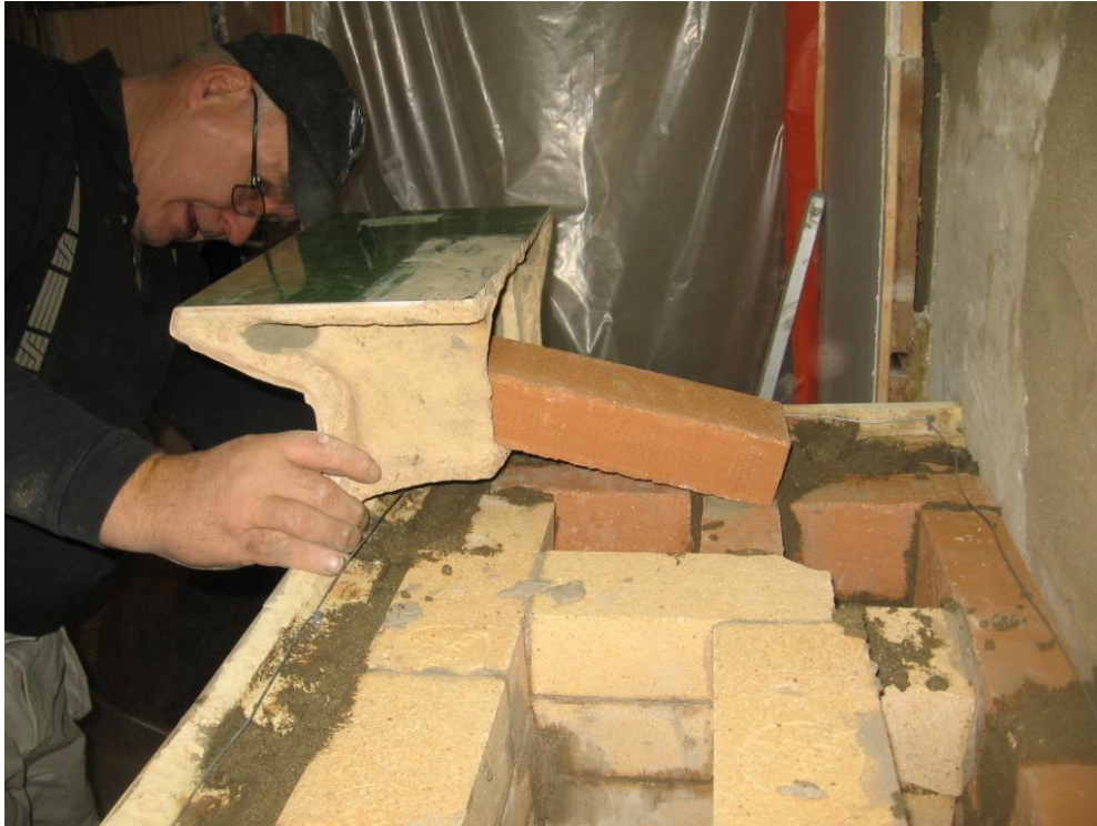
Kuva 54 Seuraavassa varvissa on hyllymäiset koristekaakelit, jotka muurari mitoittaa ja tukee paikoilleen.
