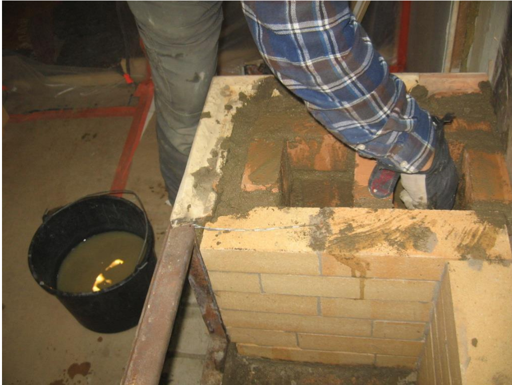
Kuva 50 Säännöllisesti muurari harjaa märällä harjalla poskikanavat, jotta kanavien seiniin ei jää laastipurskeita, jotka vaikuttaisivat haitallisesti vetoon.
