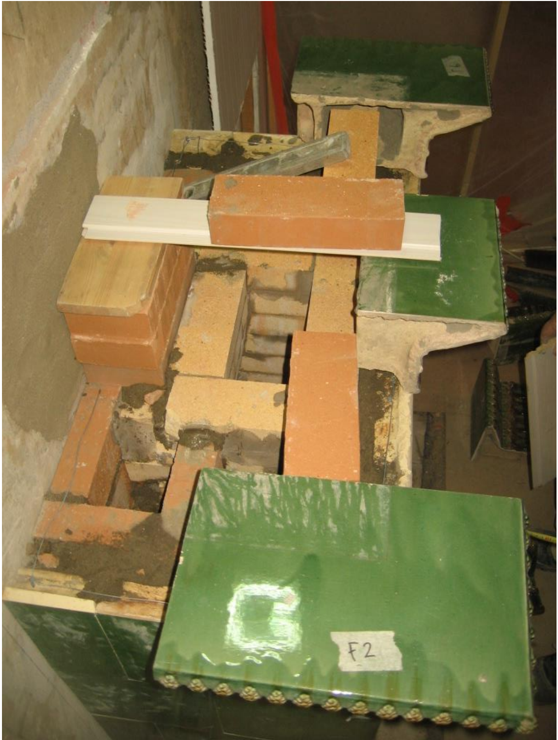
Kuva 56 Ulkonevat koristekaakelit on tuettava huolellisesti, jotta ne eivät pääse kaatumaan.
