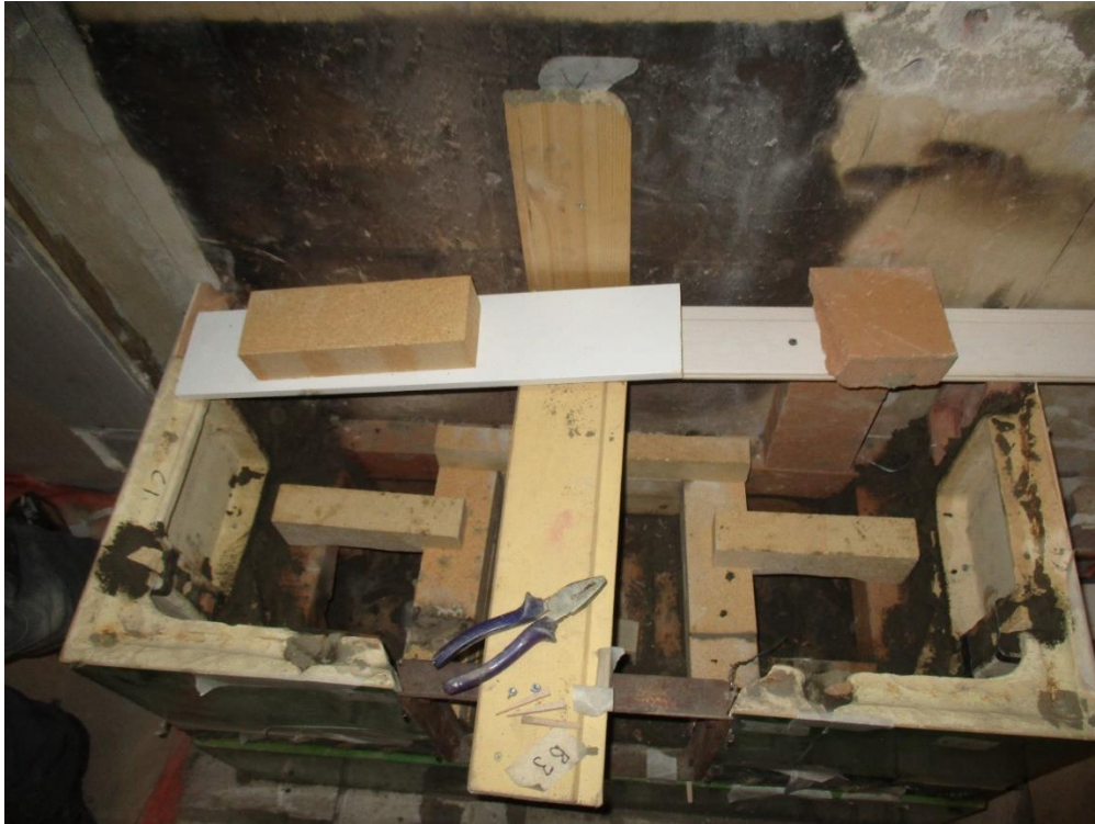
Kuva 43 Uunin rakenne alkaa hahmottua. Tässä uunissa on yhteensä neljä poskikanavaa sekä tulipesän jatkona oleva tuliputki.
