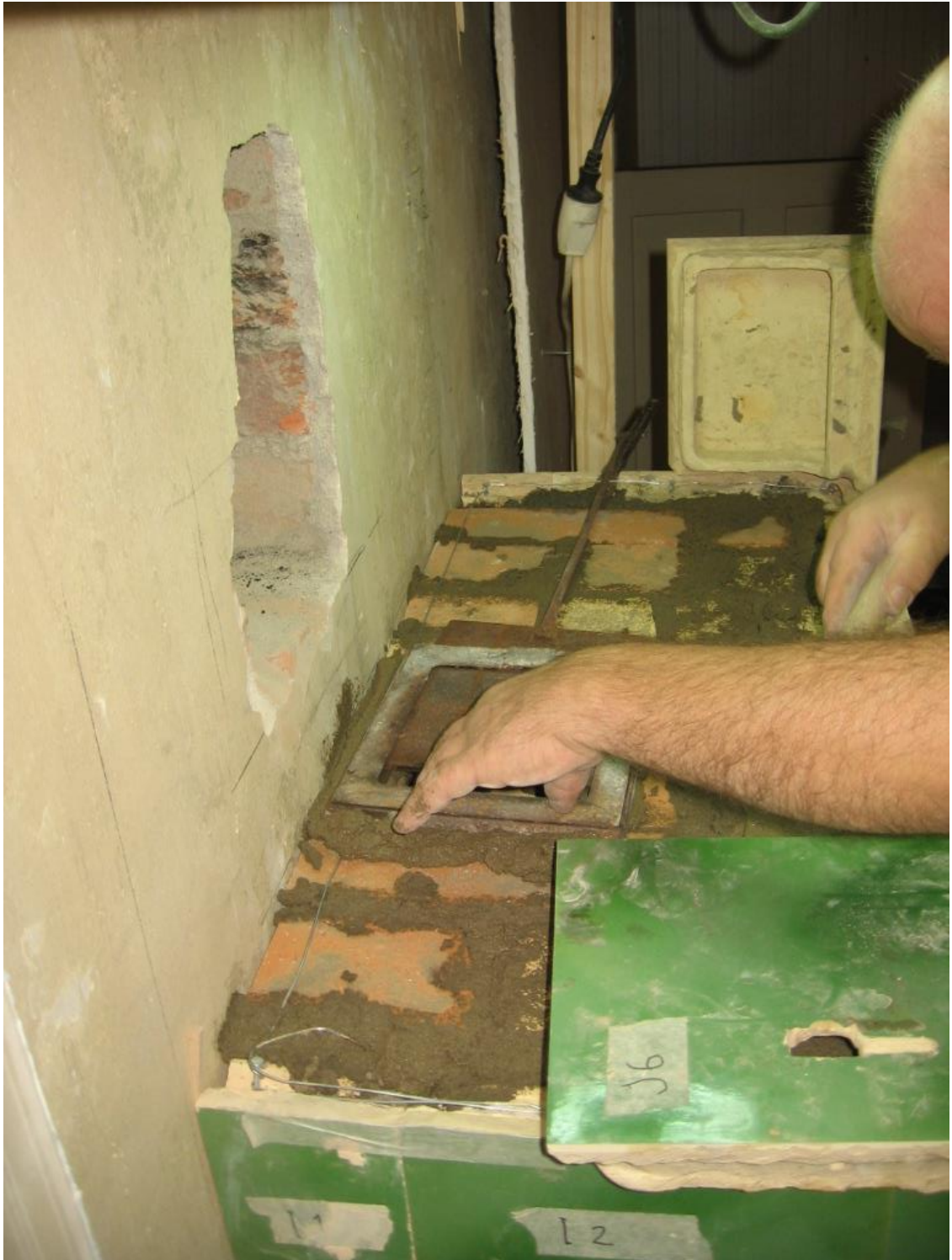
Kuva 79 Alemman savupellin kehikko muurataan paikoilleen.
