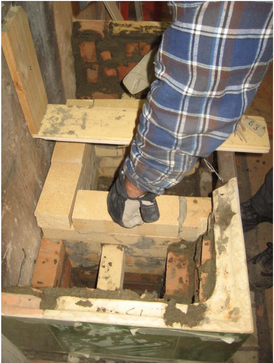
Kuva 47 Myös tulipesän yläreunan korkeus muurataan samalle tasolle kaakelivarvin yläreunan kanssa. Kun kaakeliuunin sisärakenteet ovat kaakelien yläreunan tasolla, aletaan mitoittamaan uutta kaakelivarvia entisen päälle.
