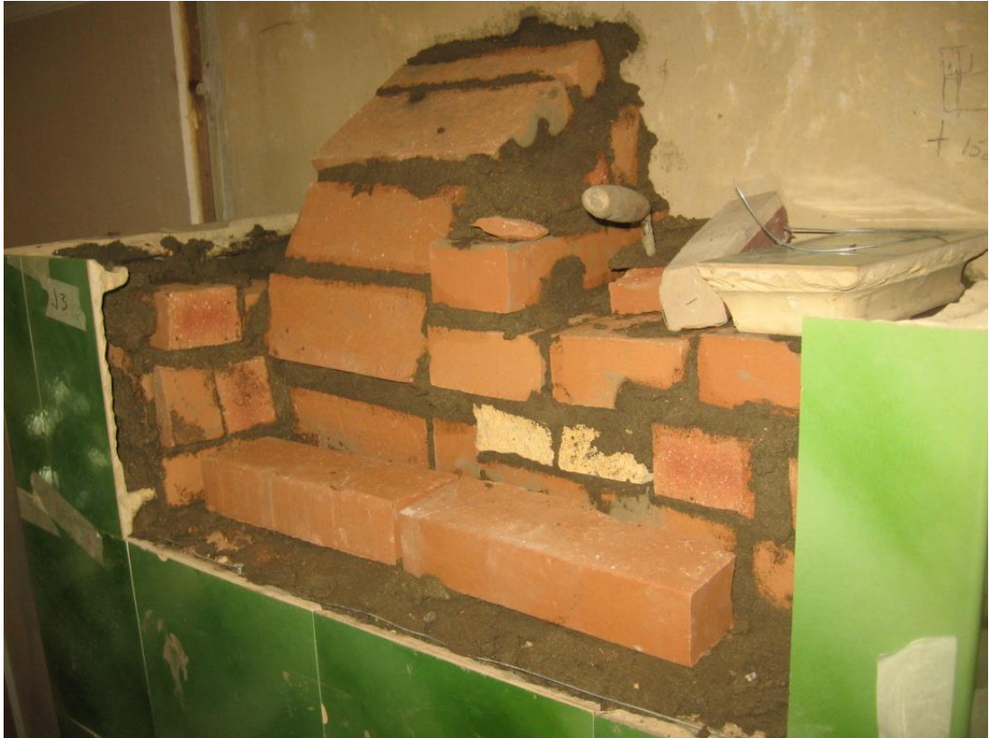
Kuva 91 Uunin yläosa muurataan umpeen sekä mitoitetaan koristeosaa varten.
