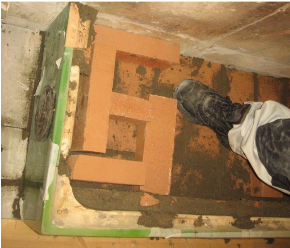
Kuva 9 Muurari tarkistaa poskikanavien koon sekä sijoittumisen, jonka jälkeen tulipesä on mitoitettavissa paikoilleen. Tulipesän sijaintia sekä kokoa määrittävät myös uunin alkuperäisten suuluukkujen koko.
