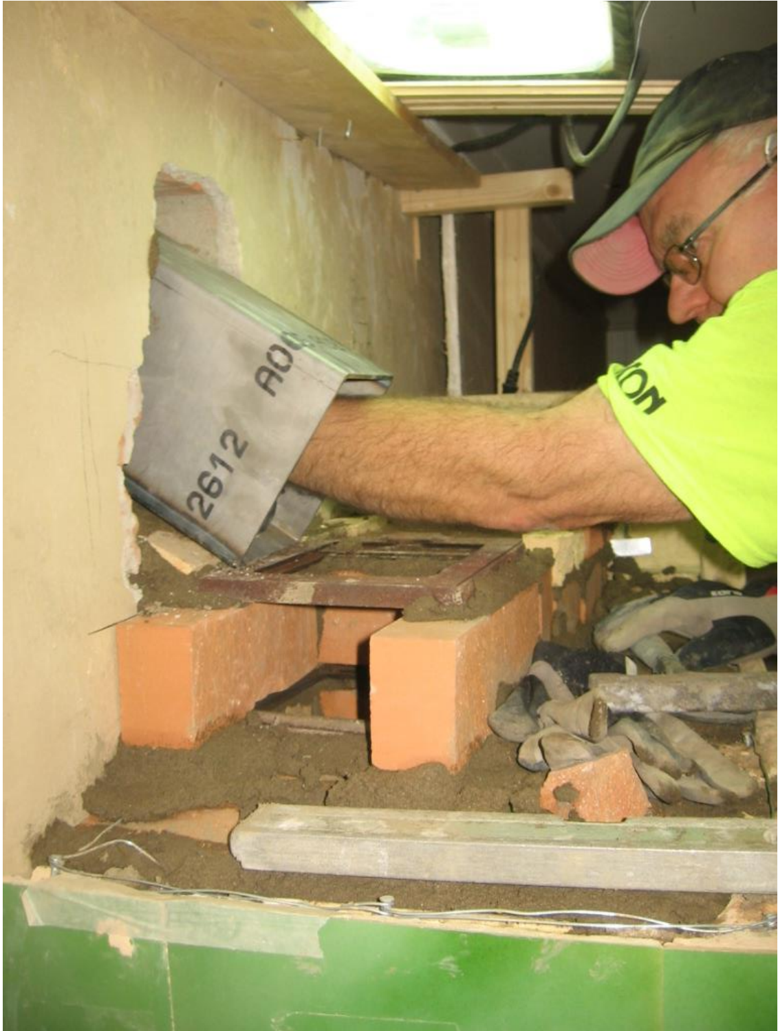
Kuva 85 Muurari nostaa hapon kestävästä teräksestä valmistetun hormiliitoskappaleen paikoilleen. Mitoitus on osunut hyvin kohdilleen ja kaikki eri elementit ovat oikealla korkeudella. Uunin sisäiset rakenteet sekä hormiliitos on mitoitettava kaakeleiden sekä niissä olevien alkuperäisten työstöjen mukaisesti.
