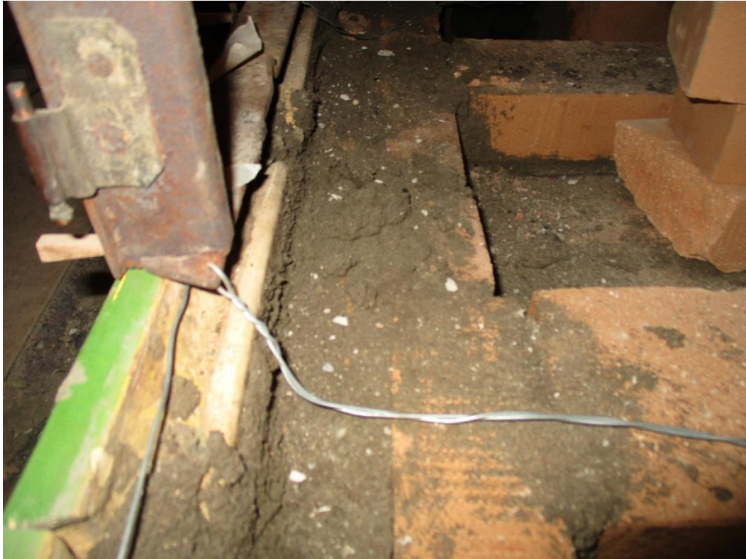
Kuva 23 Luukku kiinnitetään ala- ja yläreunastaan rautalangalla uunin sisärakenteisiin.
