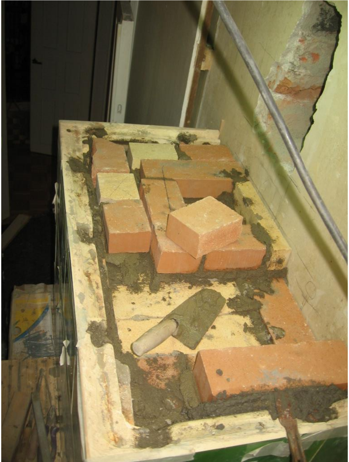
Kuva 77 Savupellin paikka on merkitty ja pellinohjuri muurattu sekä tuettu paikoilleen, joten uunin yläosaa voidaan täyttää umpimuurauksella. Seuraavaksi sovitetaan uusi varvi kaakeleita paikoilleen ja tehdään tähti-ilmaventtiilin kanava ylemmän ja alemman sulkupellin väliin.
