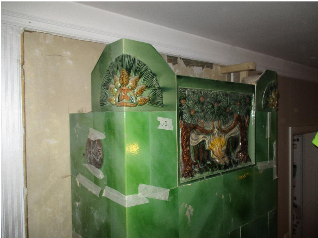
Kuva 94 Viimeiset koristekaakelit muurataan paikoilleen.
