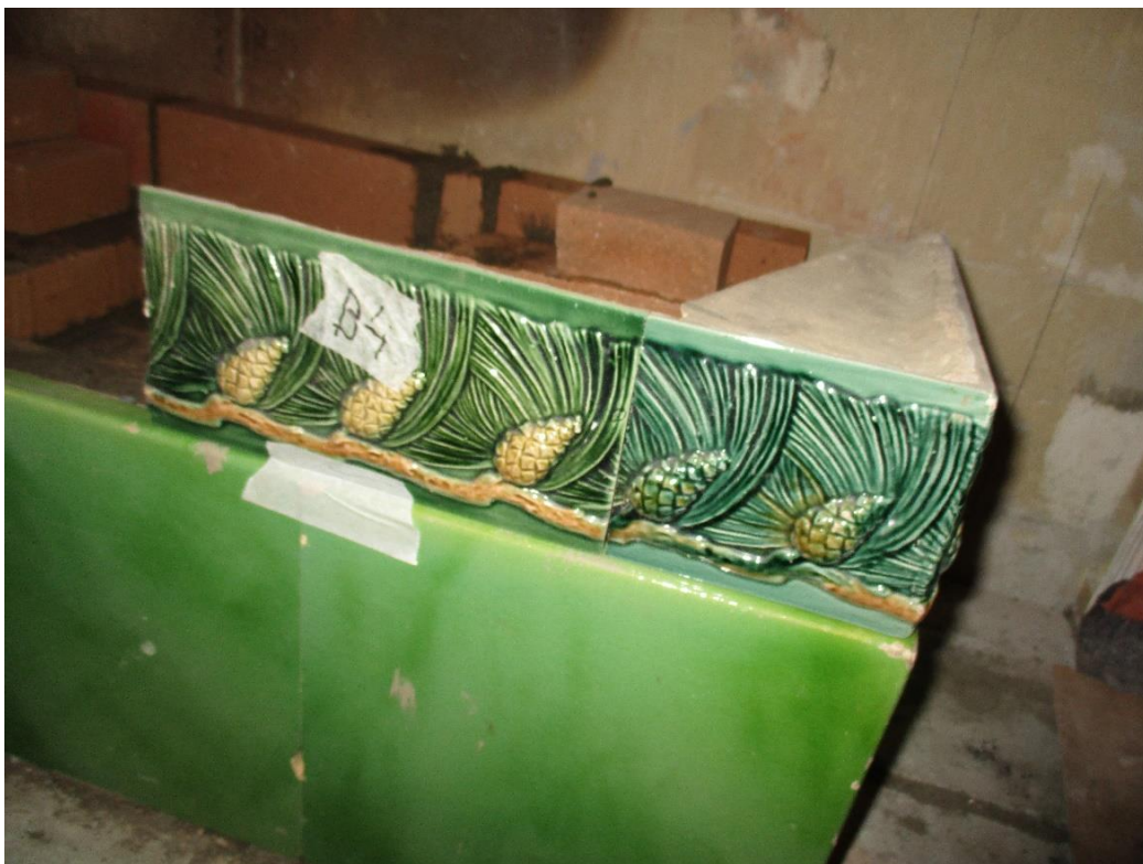
Kuva 14 Kun alin kaakelivarvi on paikoillaan ja tuettu sekä täytetty, niin aletaan mitoittaa seuraavaa kaakelivarvia. Mitoitus aloitetaan asentamalla nurkkakaakelit paikoilleen.
