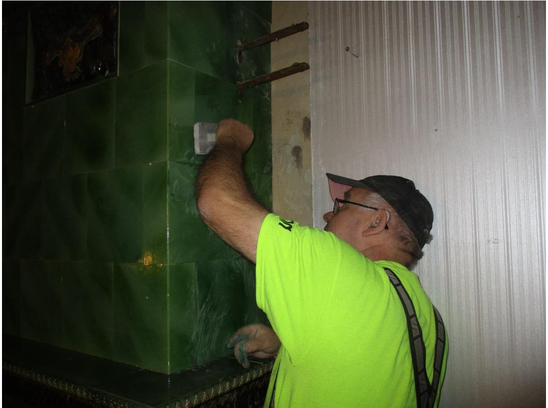
Kuva 104 Saumalaasti tunkeutuu pieniin rakoihin ja täyttää naarmut sekä kolhut.
