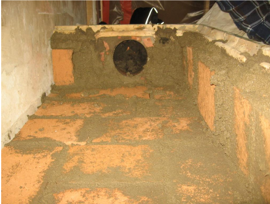
Kuva 8 Kaakeleiden kupit täytetään muuraamalla niihin tiiliä sekä tiilen paloja.
