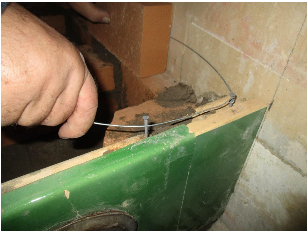
Kuva 13 Naulojen ympärille kierretään 1,5mm vahva hehkutettu rautalanka. Lanka kiertää koko kaakelivarvin ympäri sitoen kaakelit yhtenäiseksi kehäksi.
