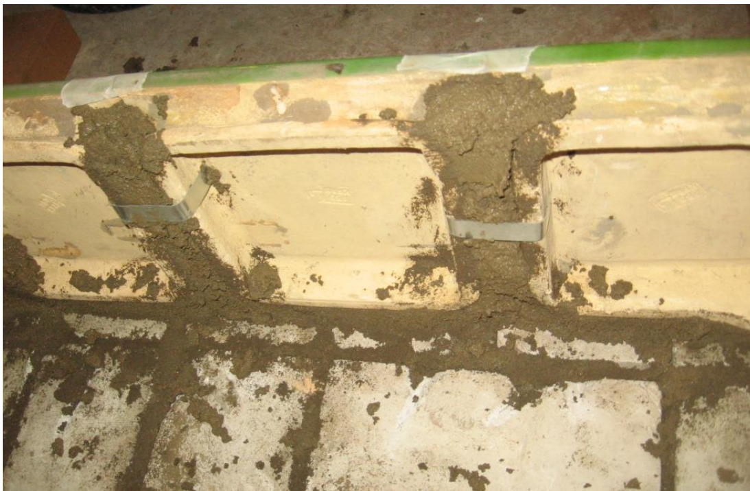
Kuva 5 Alareunan lisäksi kupprien väliset saumat täytetään laastilla ja kaakelien paikallaan pysyminen varmistetaan klemmareilla. Laastin kuivumisen ajan kaakelien saumassa on maalarinteippiä.
