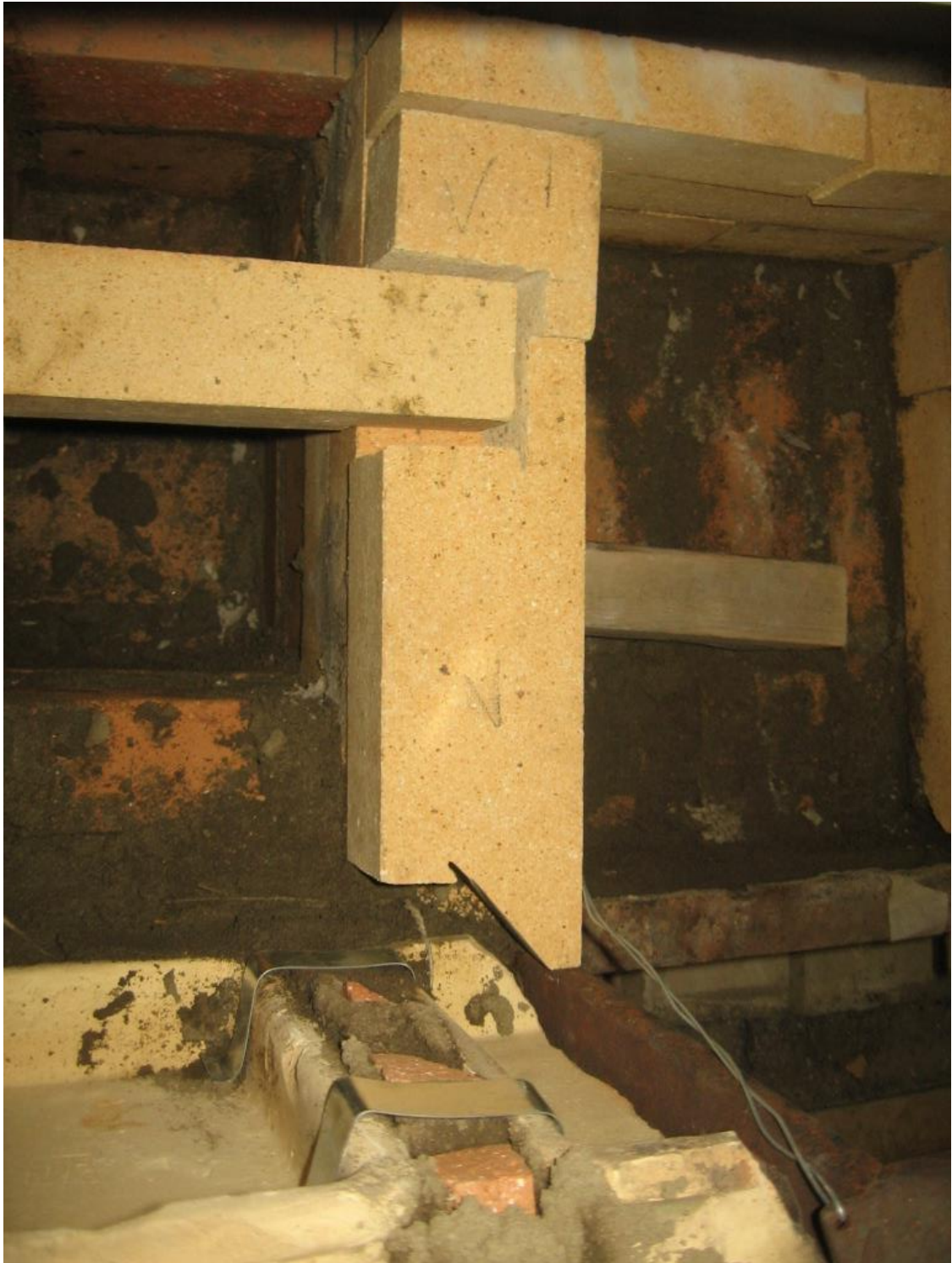
Kuva 42 Savilaastilla täytetään tulitiilen sekä suuluukun ja välitunkan sekä tulipesän väliset saumat. Savilaasti mahdollistaa rakenteiden lämpölaajenemisen, sillä se on heikkoa. Savilaastia kutsutaan myös joustavaksi, mutta termi on harhaan johtava, sillä savilaasti ei ole elastista. Joustavuudella tarkoitetaan nimenomaan heikkoutta.
