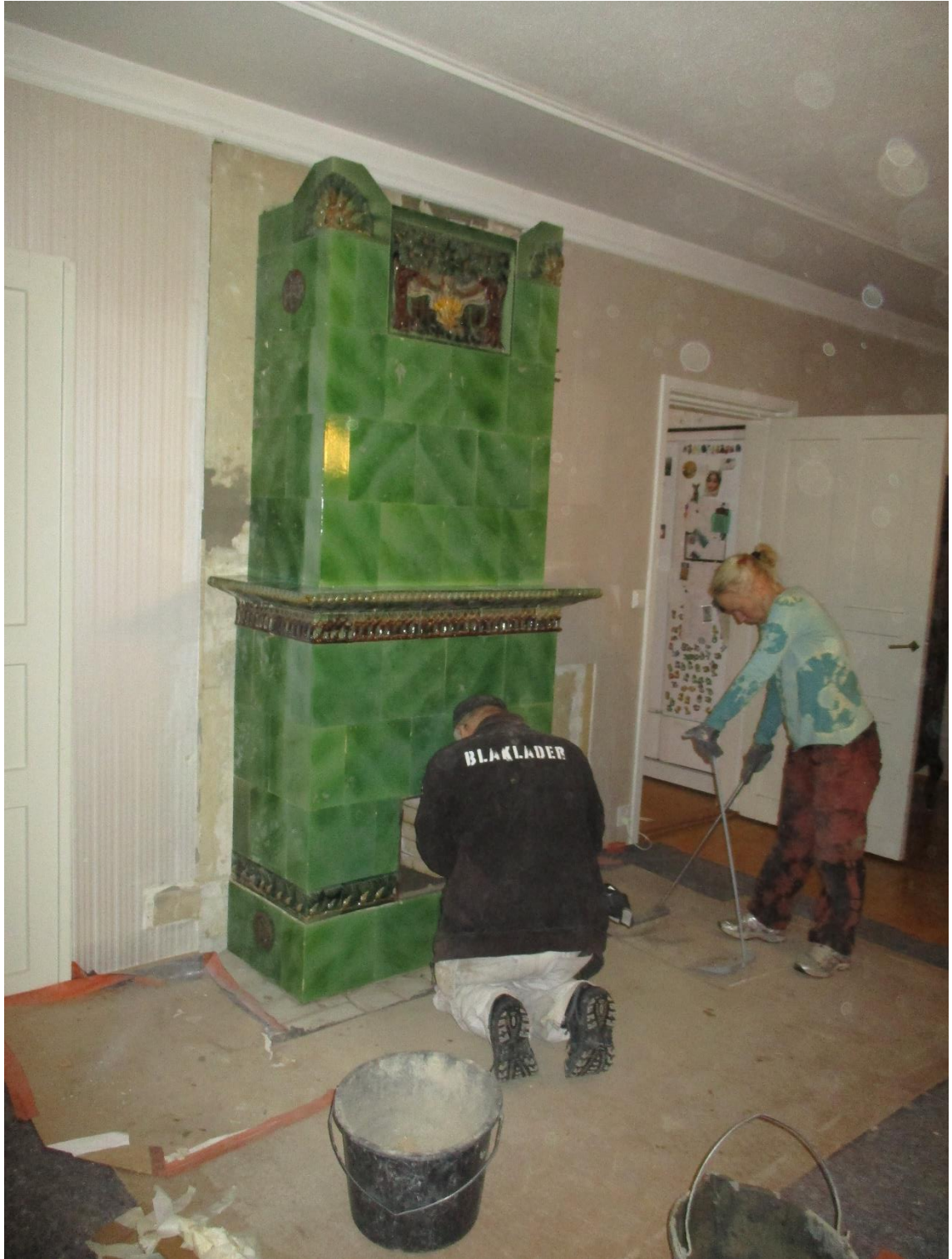
Kuva 99 Uuni on muurattu, mutta se pitää vielä viimeistellä saumaamalla.
