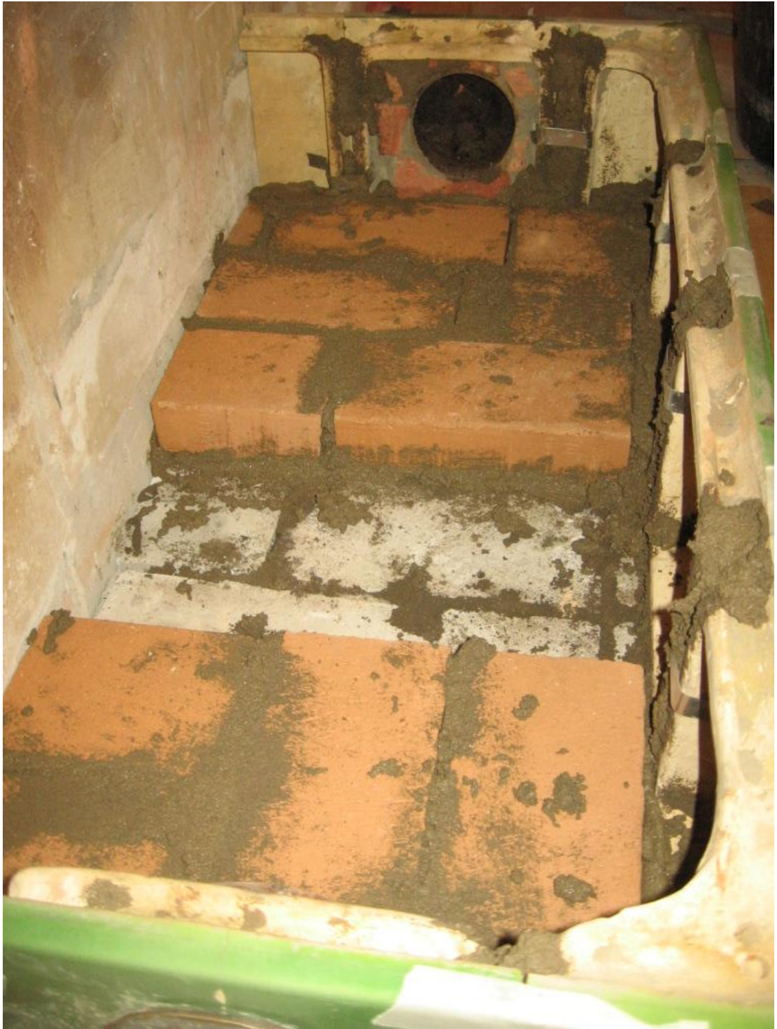
Kuva 7 Kun kaakeleiden saumat on muurattu, muurataan uunin pohjakerros umpeen.
