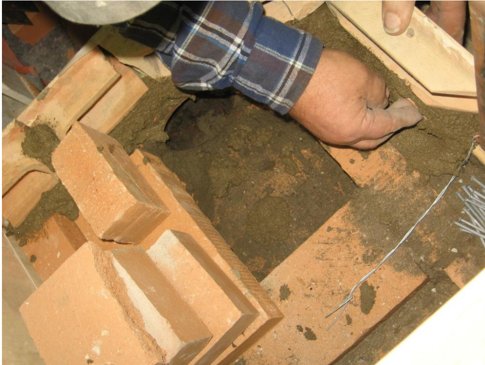
Kuva 27 Muurari sulloo laastin paikoilleen. Sullomisen yhteydessä voidaan käyttää myös pieniä tiilen kappaleita täytteenä.
