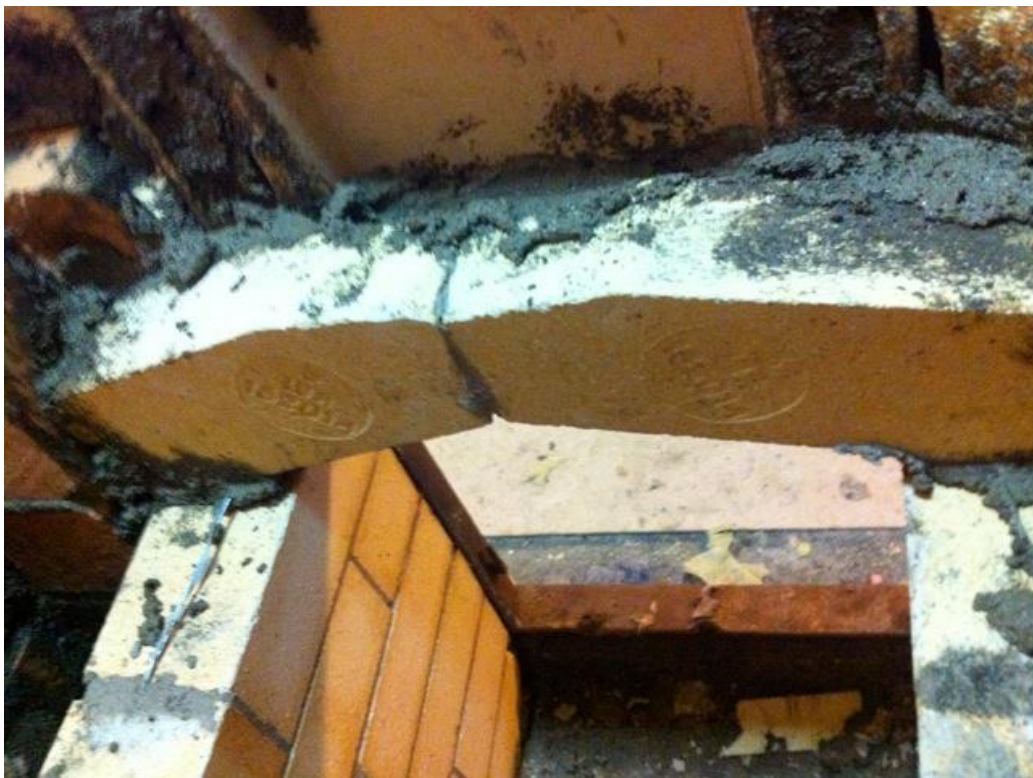
Kuva 51 Suuluukun ylitys tehdään kahdesta tulitiilestä holvaamalla.
