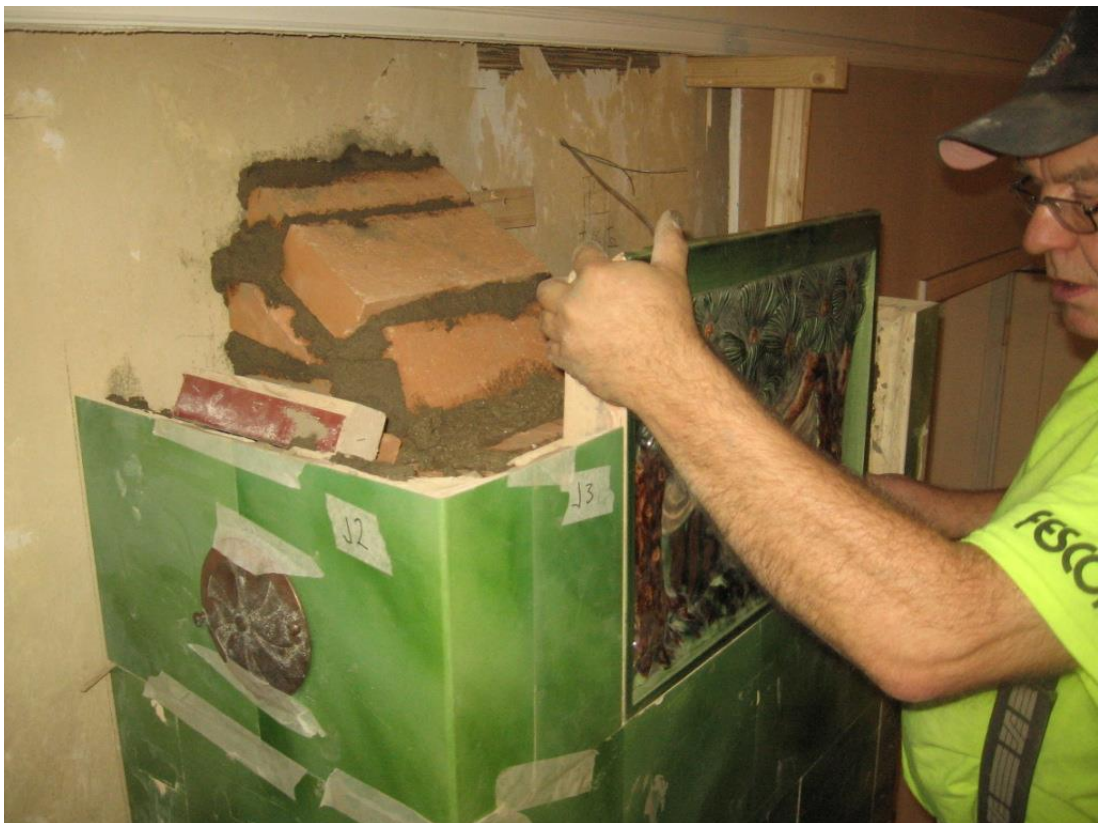
Kuva 92 Koristeosa muurataan paikoilleen tavallisten kaakeleiden tapaan.
