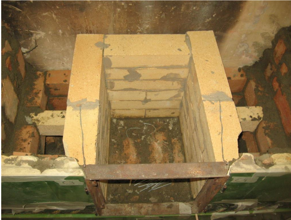
Kuva 48 Suuluukun yläreunassa on rautalangat, jotka muurataan tulipesän seinätiilien väliseen saumaan. Näin suuluukun yläreunakin lukittuu paikoilleen.
