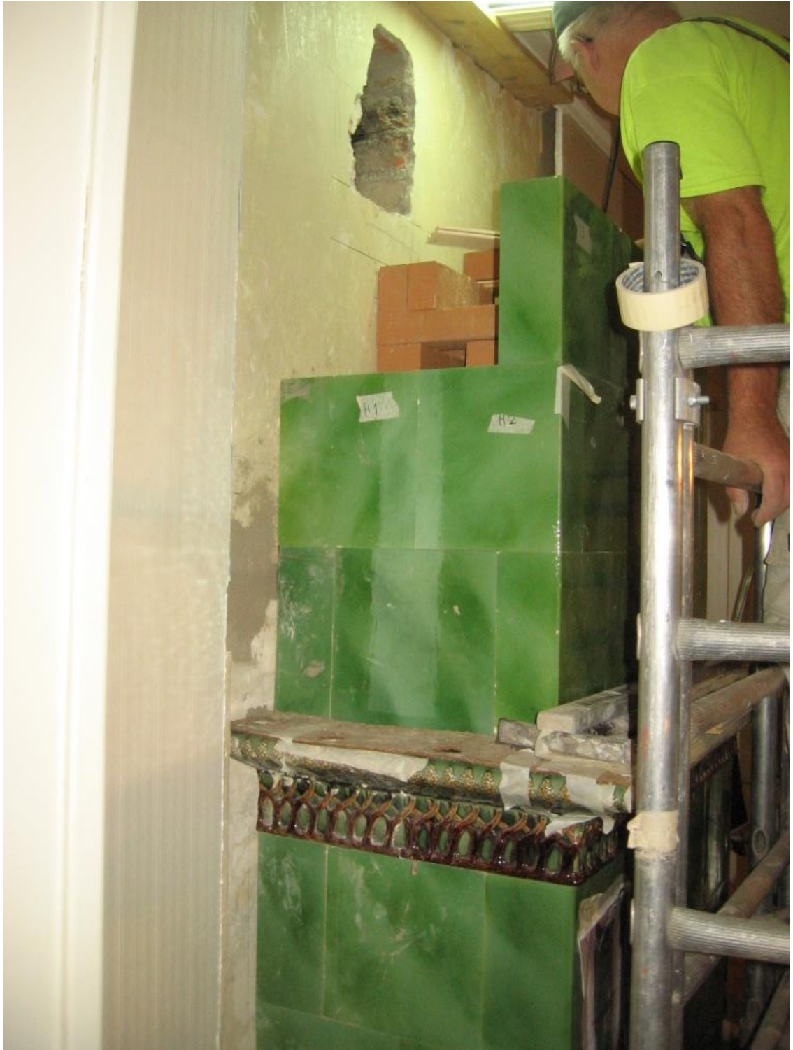
Kuva 68 Tuttuun tapaan uusi kaakelivarvi sovitetaan paikoilleen ja uuni jatkaa nousuaan.
