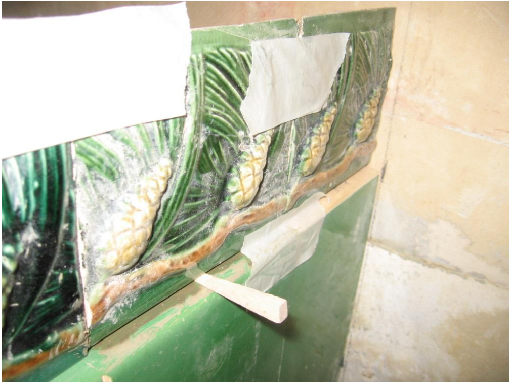
Kuva 25 Pienet korkeussuuntaiset säädöt tehdään puisilla kiiloilla.
