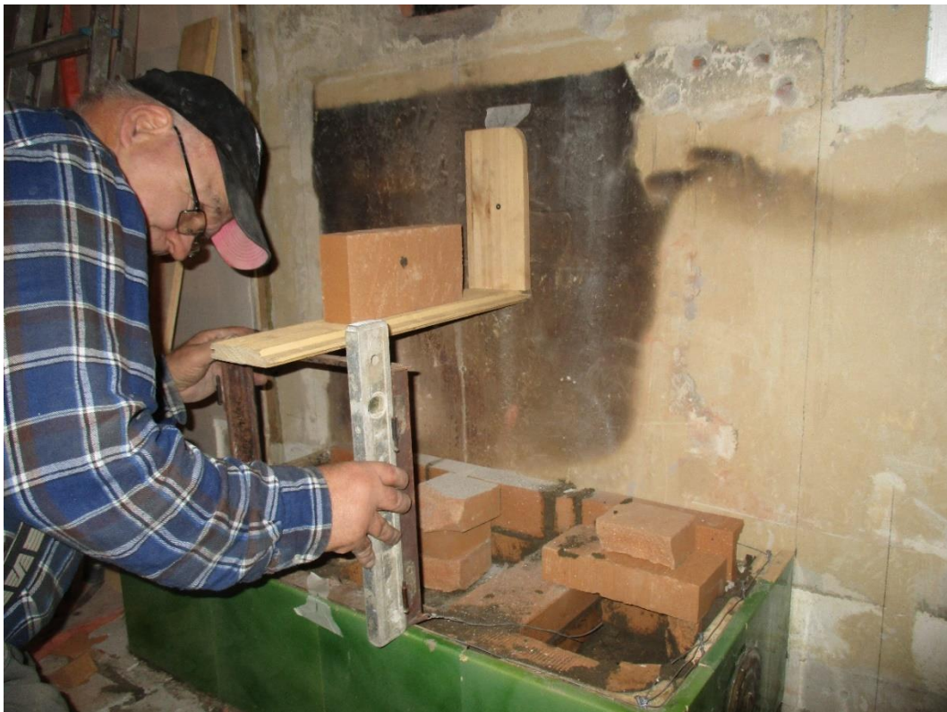
Kuva 22 Kun kaakelivarvi on työstetty oikeaan kokoon, jatkuu muuraaminen. Muurari tekee uunin suuluukkua varten väliaikaisen tuen laudoista ja asentaa luukun paikoilleen.
