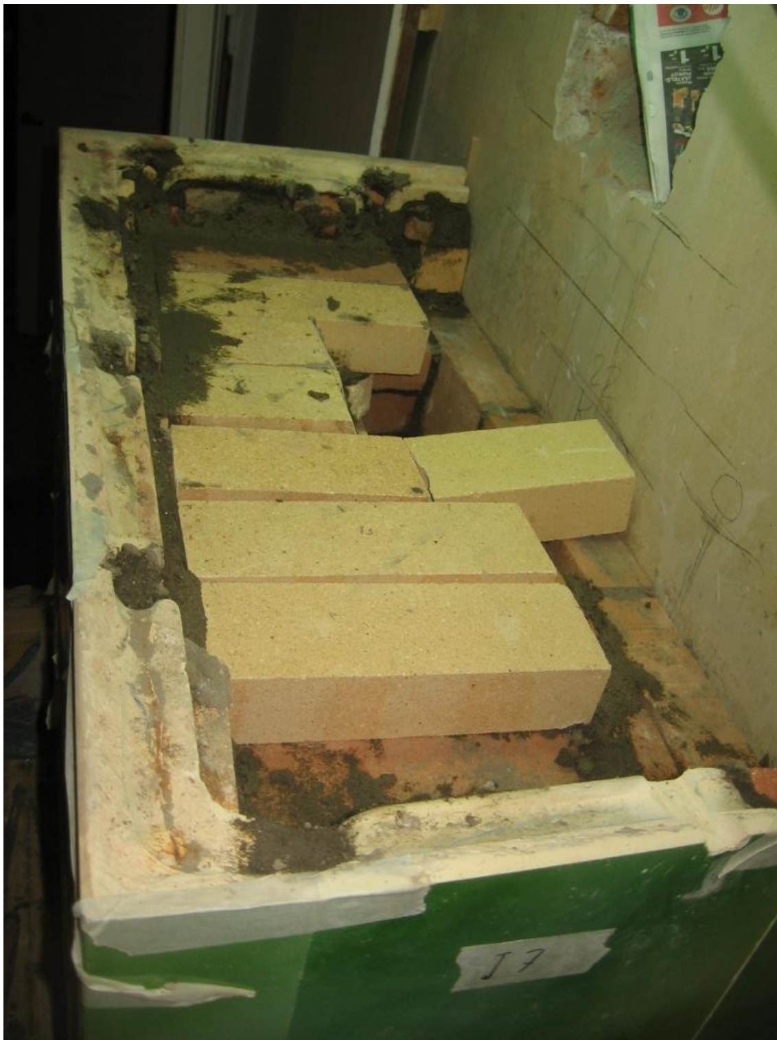
Kuva 73 Osa laen tiilistä on muurattu paikoilleen ja osaa vasta mitoitetaan.
