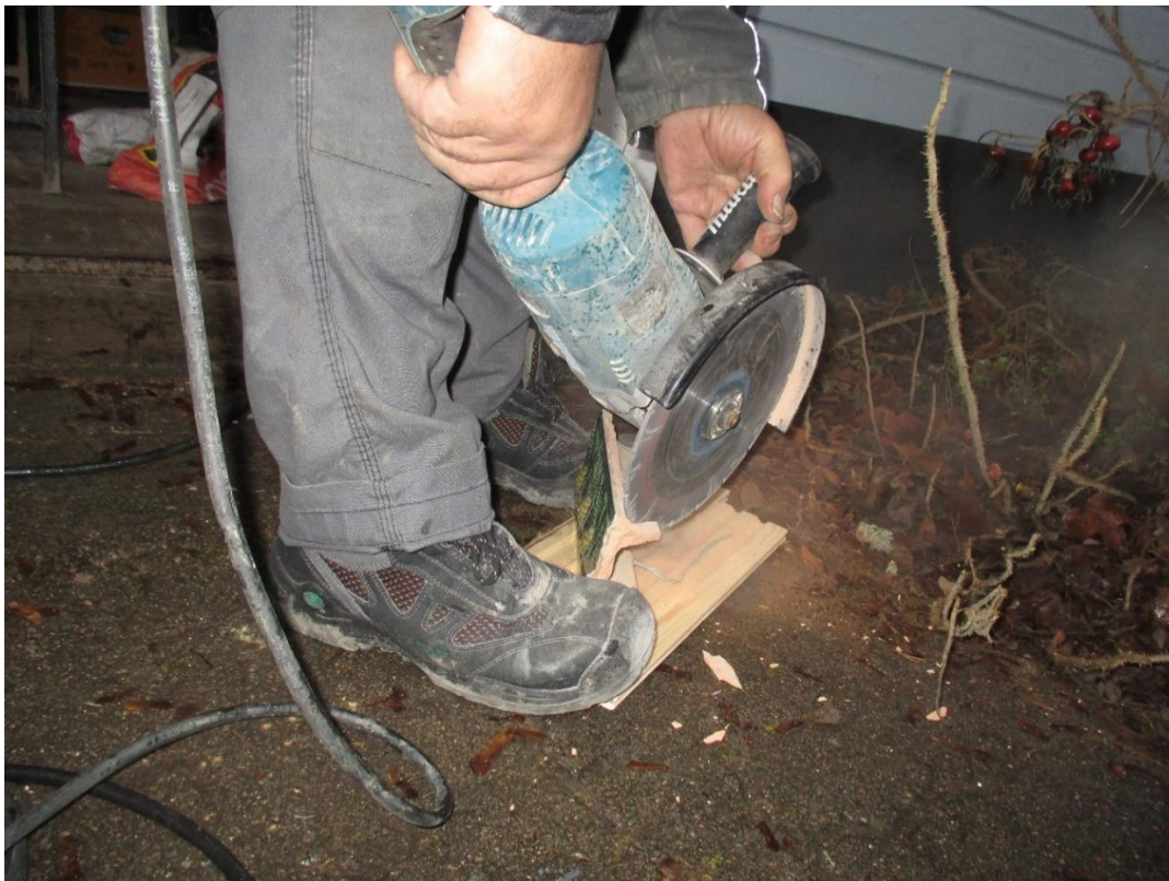
Kuva 20 Raakatyöstöt tehdään kulmahiomakoneella, jossa on timanttilaikka.
