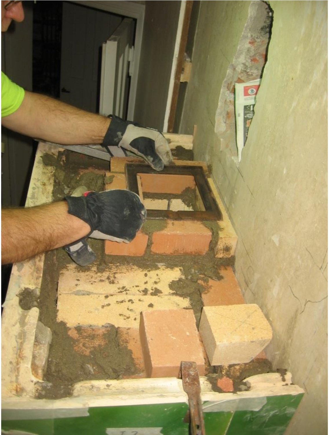
Kuva 75 Pellinohjuri on kuvassa etualalla. Muurari on muurannut pellin kehikolle korotuksen, jotta sulkupelti on oikealla korolla pellinohjuriin nähden.
