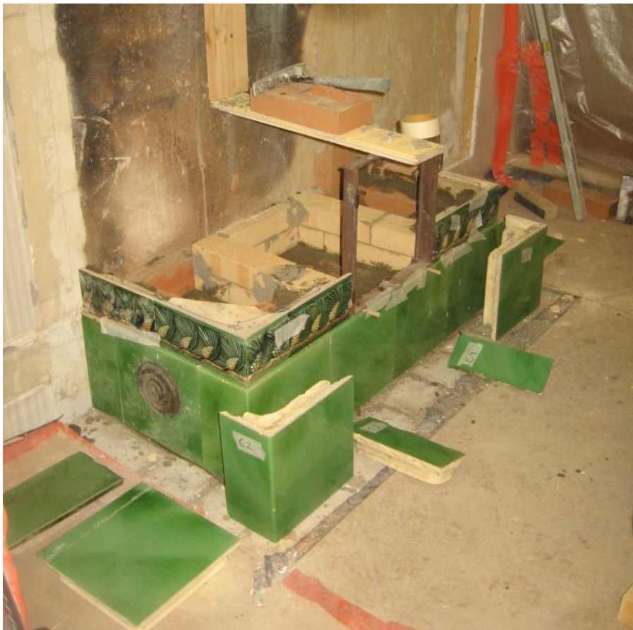
Kuva 34 Uusi varvi aloitetaan kaakeleiden mitoituksella sekä työstöllä.
