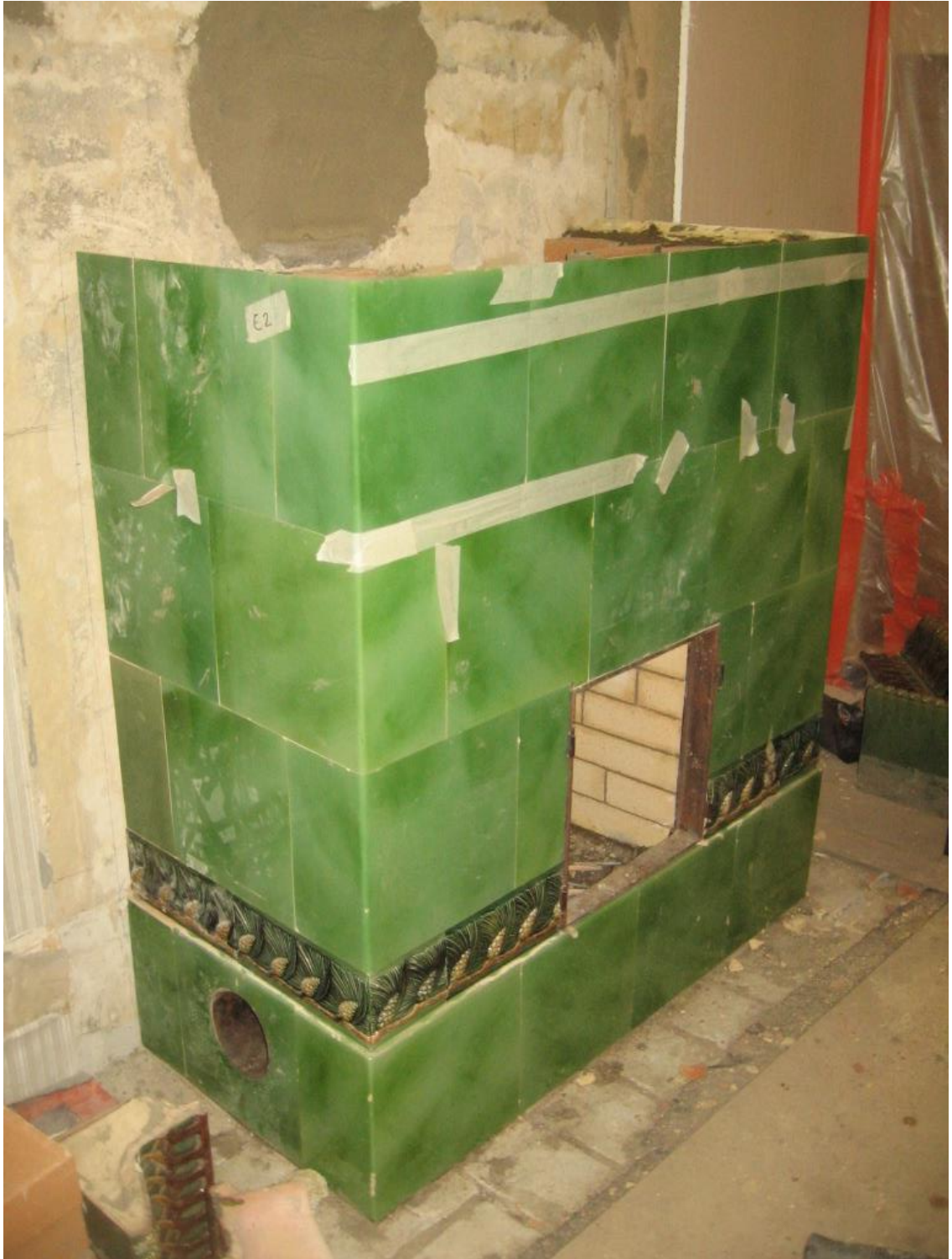
Kuva 52 Uusi varvi on sovitettu paikoilleen, jonka jälkeen kaakeliuunin sisärakenteiden muuraaminen jatkuu.
