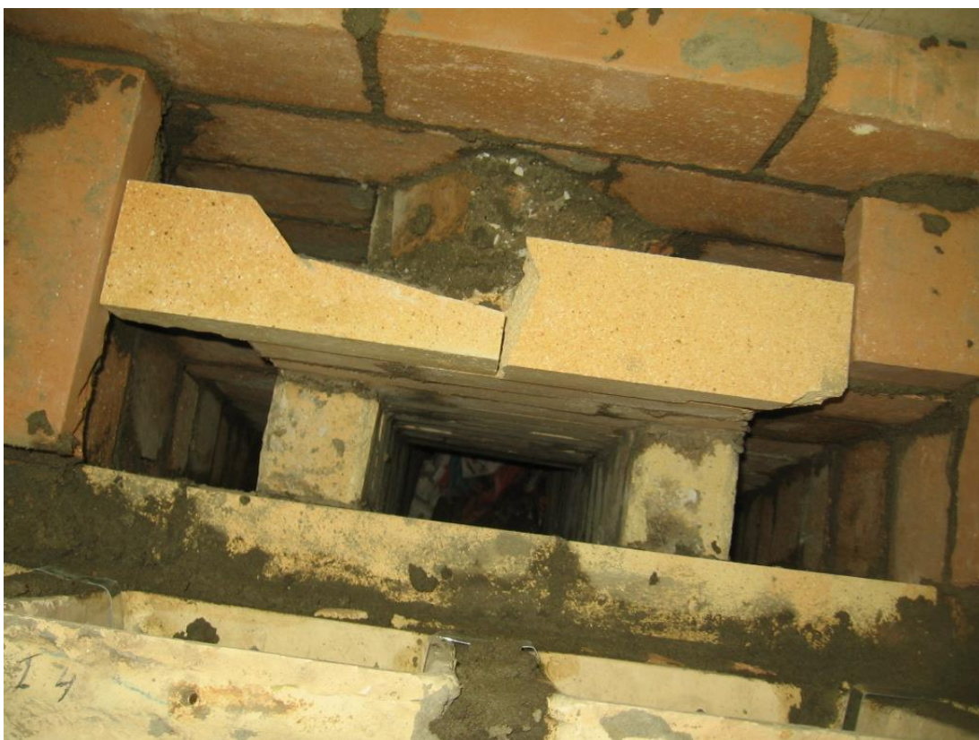
Kuva 70 Siirto tehdään, jotta savupelleille saadaan paremmin tilaa.
