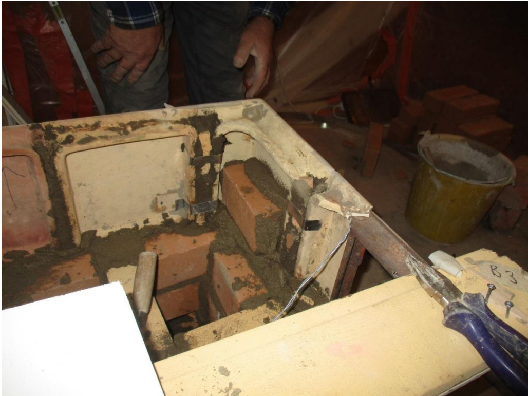
Kuva 45 Kaakeliuunin ulkoseinä koostuu täytetystä kuppikaakelistä sekä syrjätiilimuurauksesta.
