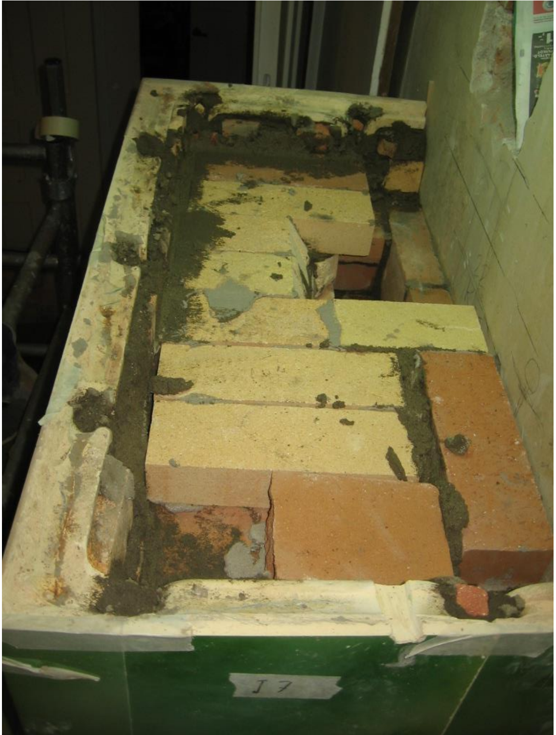
Kuva 74 Laki on ummessa ja seuraavaksi muurari sovittaa pellinohjurin paikoilleen.
