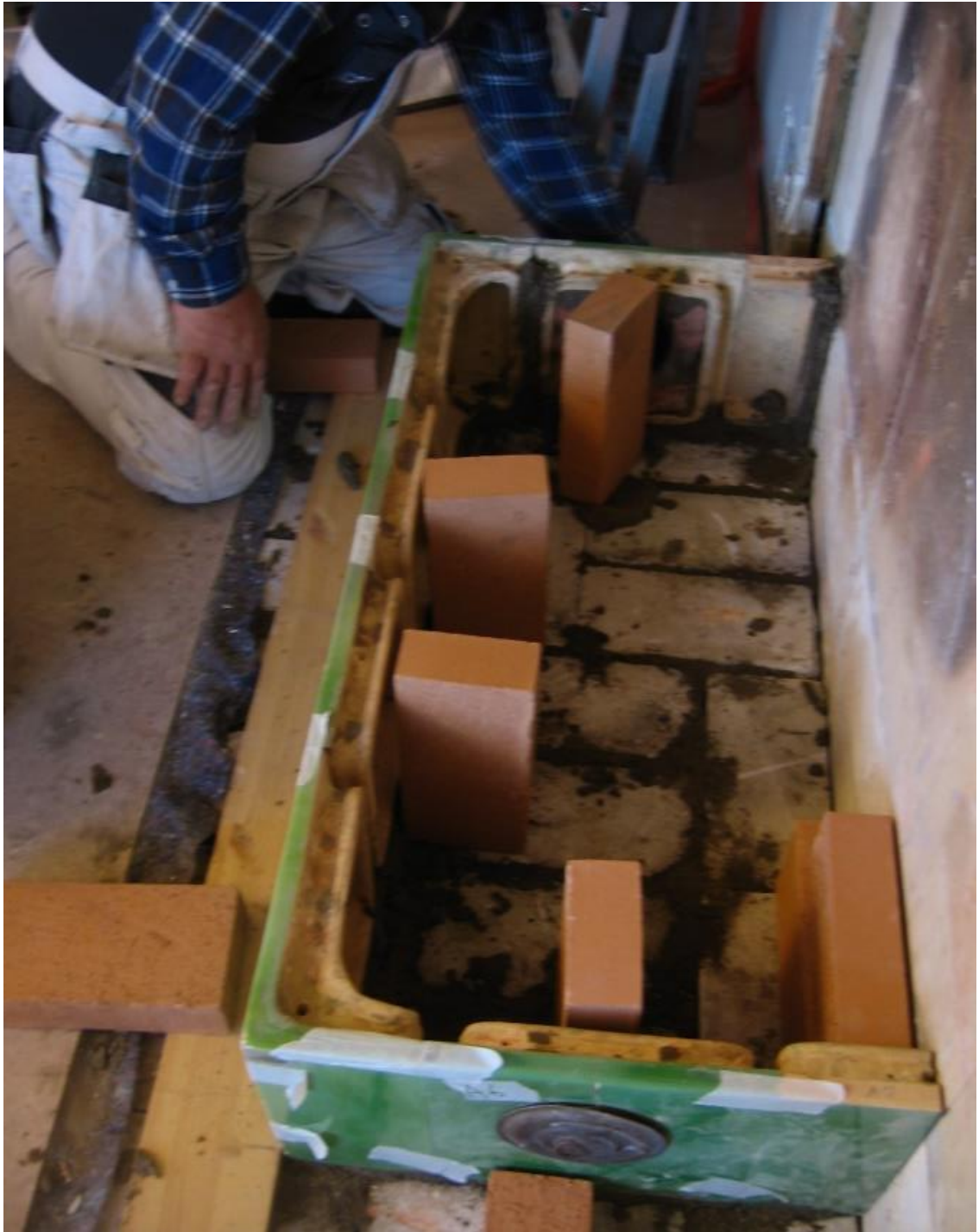
Kuva 4 Muurari tukee kaakelit paikoilleen irtotiilillä sekä maalarinteipillä, jonka jälkeen kaakelit muurataan savilaastilla kuppien alapuolelta muurin perustaan kiinni.
