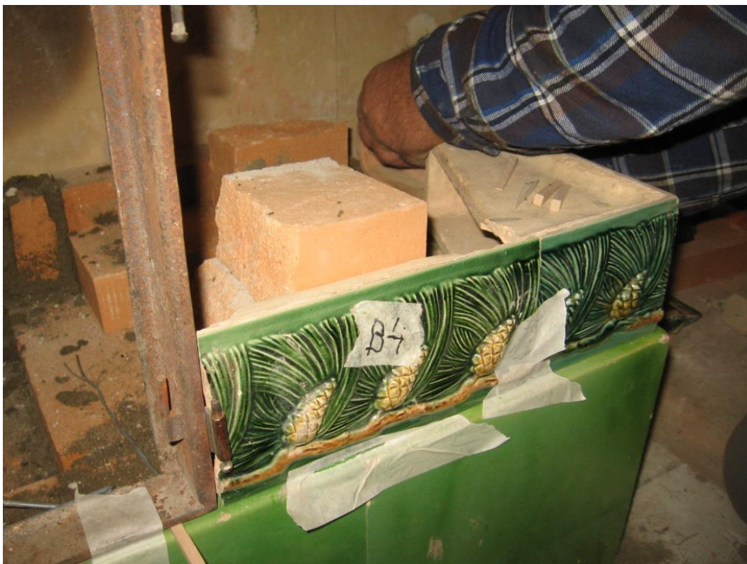
Kuva 24 Luukun jälkeen asennetaan loput varvin kaakeleista paikoilleen. Väliaikainen tuenta tehdään maalarinteipillä.
