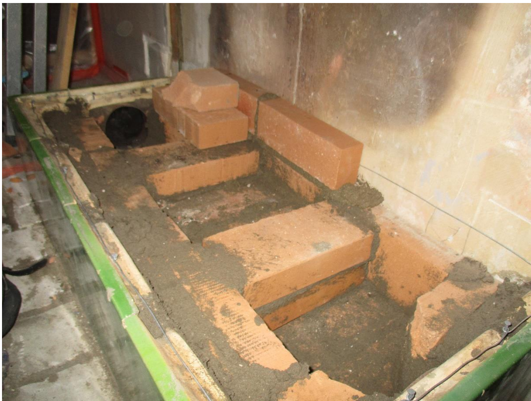
Kuva 11 Lämpölaajenemisen vuoksi uunin takaseinän sekä palomuurin välissä ei käytetä laastia. Lämmitessään uuni kasvaa korkeutta ja vastaavasti jäähtyessään kutistuu.
