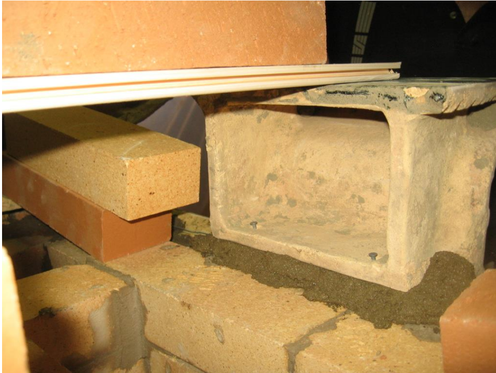
Kuva 57 Myös koristekaakeliin kuppien alareunassa olevaan reikään työnnetään naula, joka lukitsee kaakelin alareunan paikoilleen. Naula työntyy alemman kaakelin ja syrjätiilimuurauksen väliseen saumaan.
