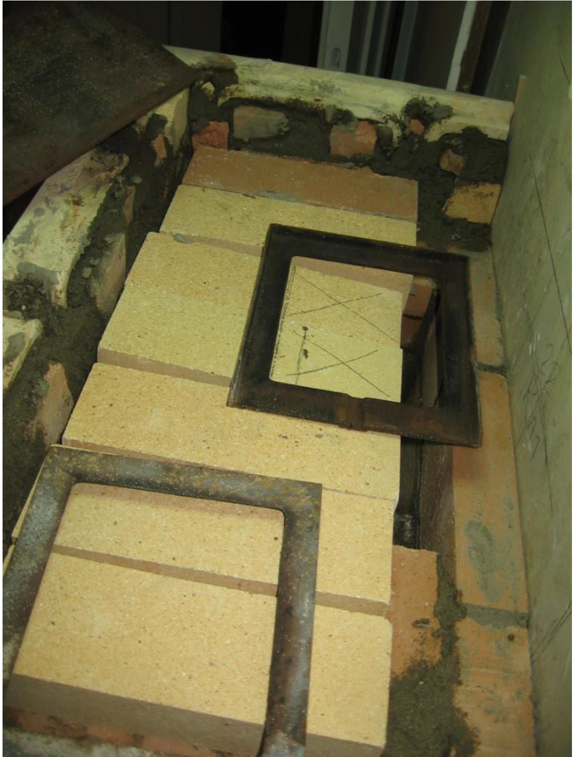
Kuva 71 Muurari valmistautuu etummaisten poskikanavien sekä tuliputken laen muuraamiseen. Samalla aletaan mitoittaa savupeltiä paikoilleen. Savupellin sijaintiin vaikuttaa kaakeleissa olevat alkuperäisiä peltejä varten poratut reiät.
