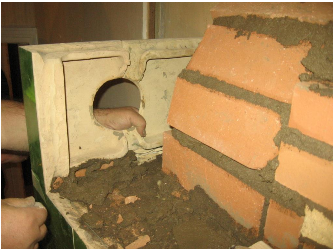
Kuva 88 Seuraavaksi muurari tekee tähti-ilmaventtiilin kanavan.
