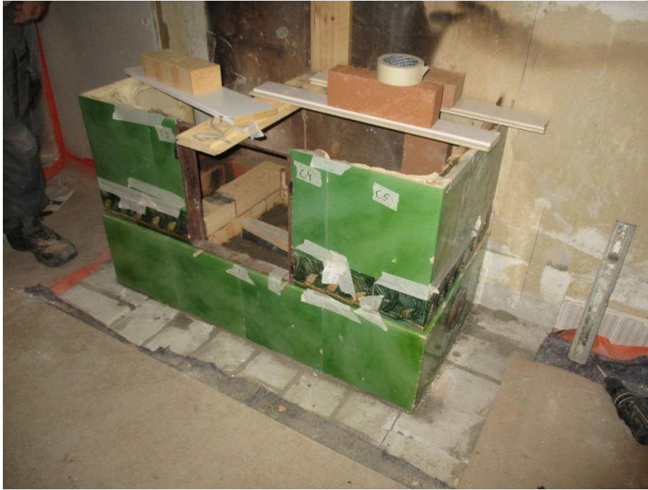
Kuva 36 Varvin loput kaakelit sovitetaan ja tuetaan paikoilleen. Ne tuetaan väliaikaisesti paikoilleen maalarinteipillä sekä erilaisilla tukirakenteilla.
