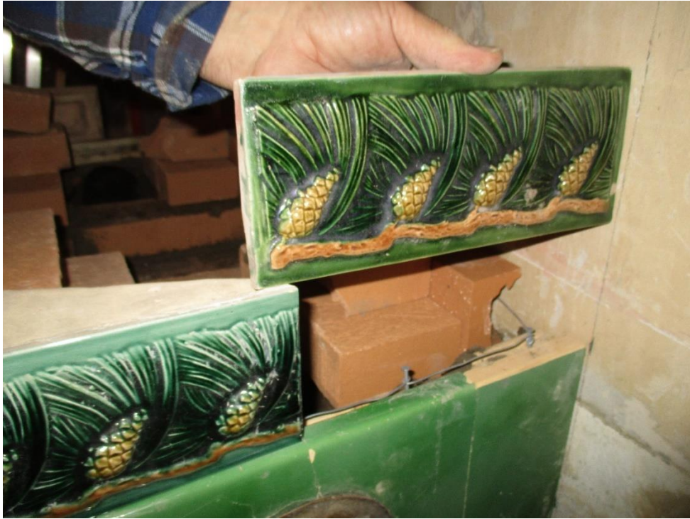
Kuva 17 Myös uunin syvyys muuttui alkuperäisestä, joten reunimmaisista kaakeleista on lyhennettävä.
