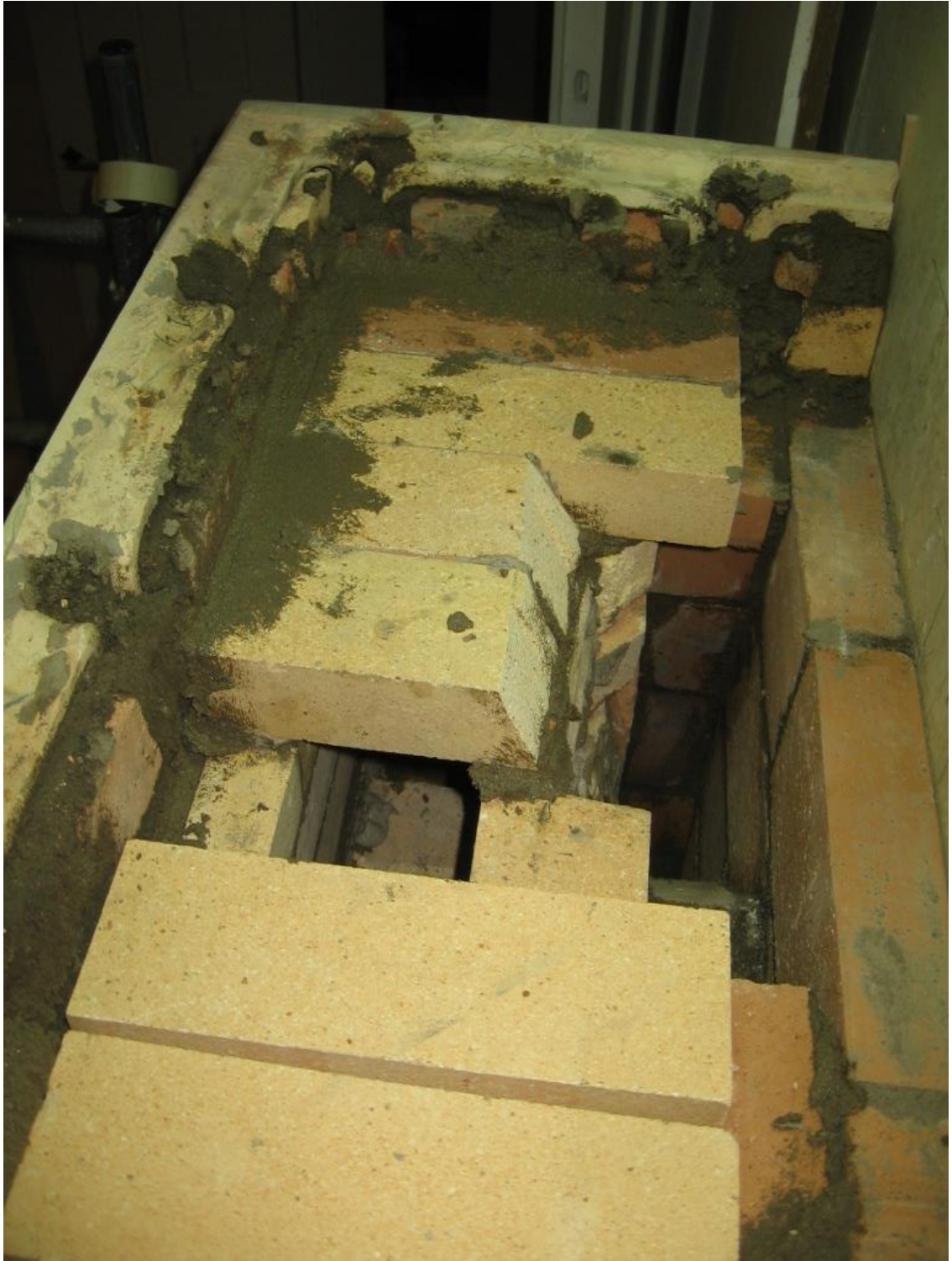
Kuva 72 Laki alkaa umpeutua ja savupellin paikka hahmottua.
