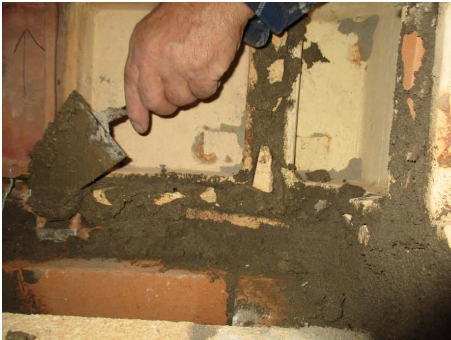
Kuva 37 Alareunat sekä kuppien väliset saumat muurataan umpeen. Tässä vaiheessa muuraustyömaalla alkaa olla pienempiä tiilenpaloja, joita kutsutaan tiilikiiloiksi. Näillä täytetään muurattuja saumoja, jolloin saadaan varmistettua, että laasti täyttää varmasti koko sauman.
