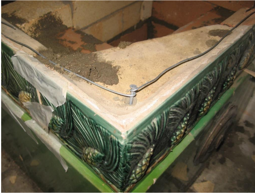
Kuva 33 Rautanaulat sekä –lanka viimeistelevät varvin, jonka jälkeen voi alkaa jälleen uuden varvin mitoitus ja työstäminen.
