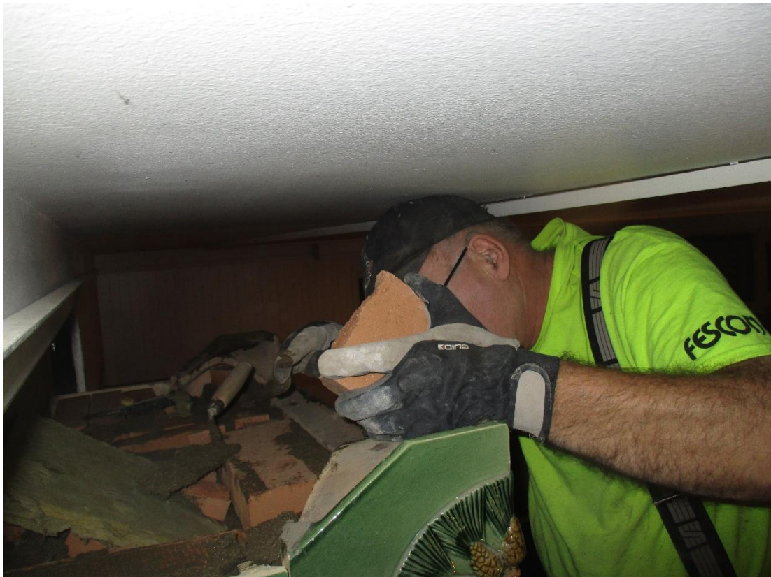
Kuva 96 Katon rajassa on ahdasta. Hormiliitoksen päälle lisätään vielä kerros palovillaa.
