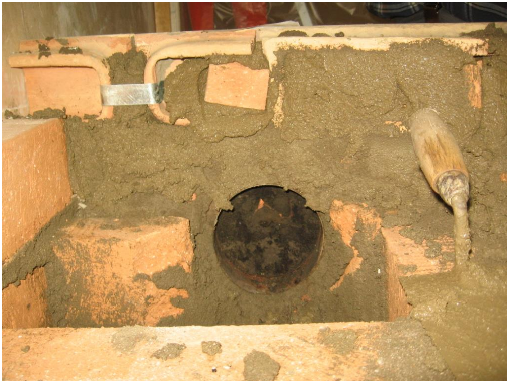
Kuva 28 Kupit täytetään laastilla sekä tiilien kappaleilla ja klemmarit asennetaan kuppien välisiin saumoihin.
