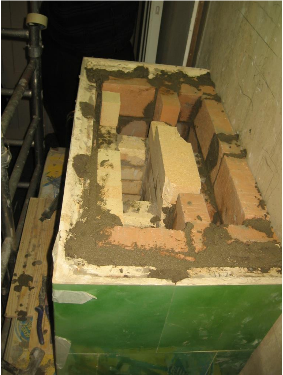
Kuva 65 Tuliputken haarautuminen ja taaempien kanavien yhdistyminen jatkuvat.
