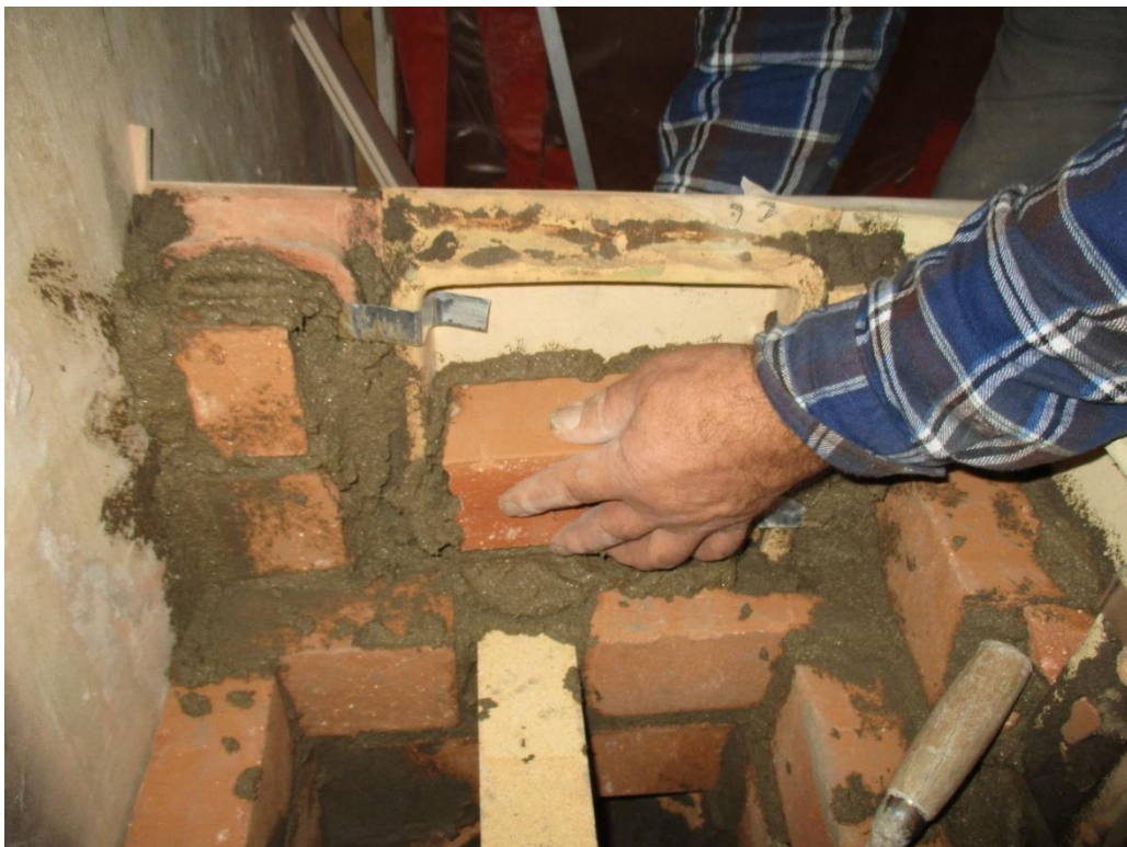
Kuva 46 Ensin täytetään kuppi ja sen jälkeen jatketaan syrjätiilimuurausta.
