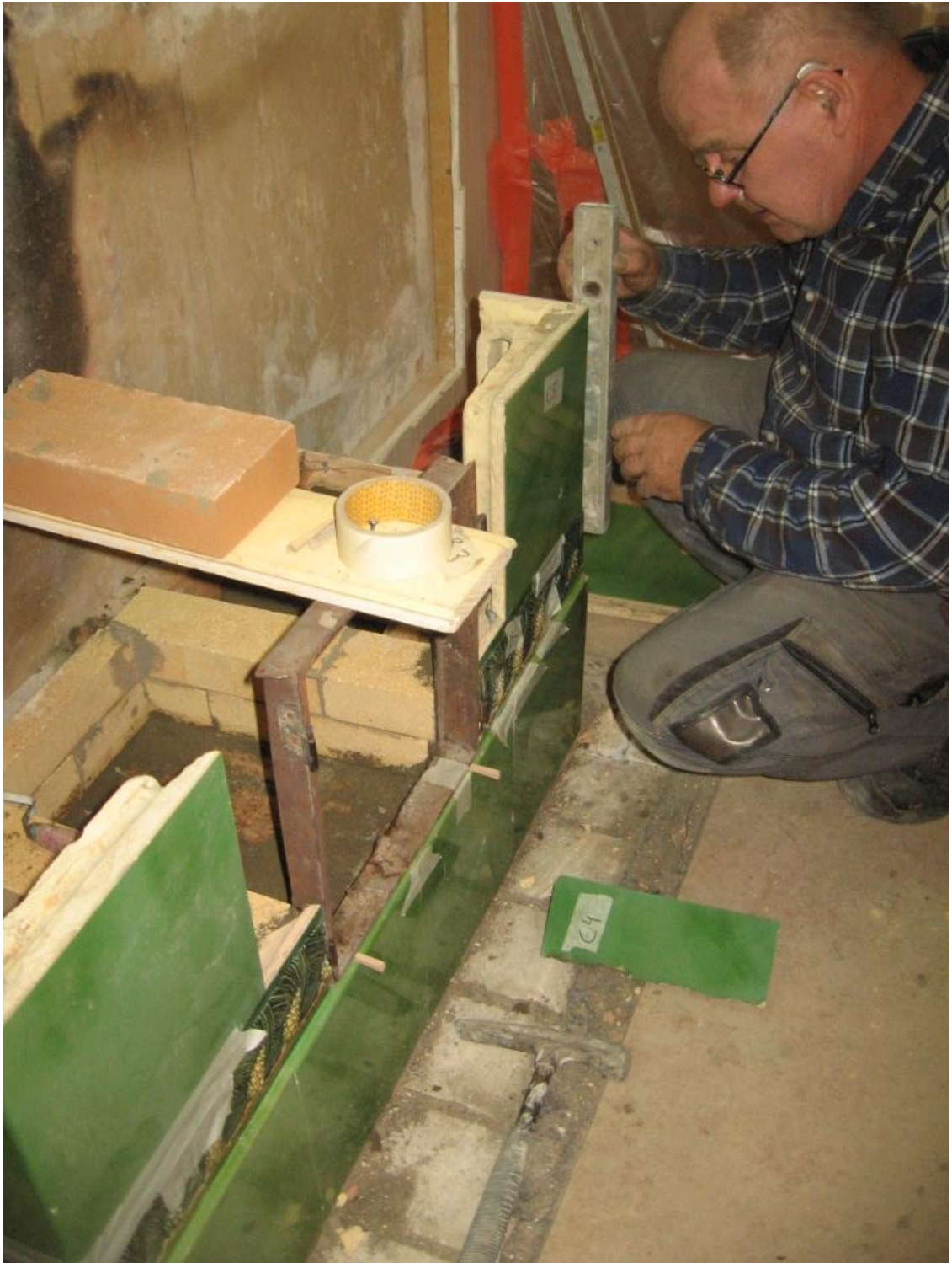
Kuva 35 Varvin muuraaminen aloitetaan kulmakaakeleista. Muuraamisen pystysuoruutta on seurattava jatkuvasti.
