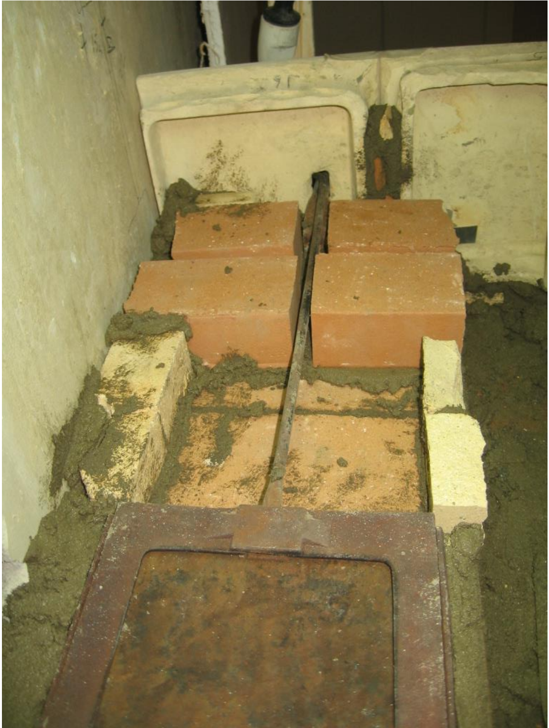
Kuva 84 Nyt pellillä on riittävästi tilaa avautumista varten. Korokkeiden päälle muurataan umpimuuraus.
