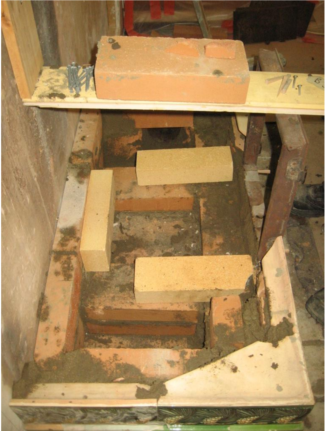
Kuva 29 Kaakeleiden kuivuessa alkaa muurari muotoilla tulipesää. Tulipesässä ja tuliputkessa käytetään tulitiiliä ja tulilaastia.
