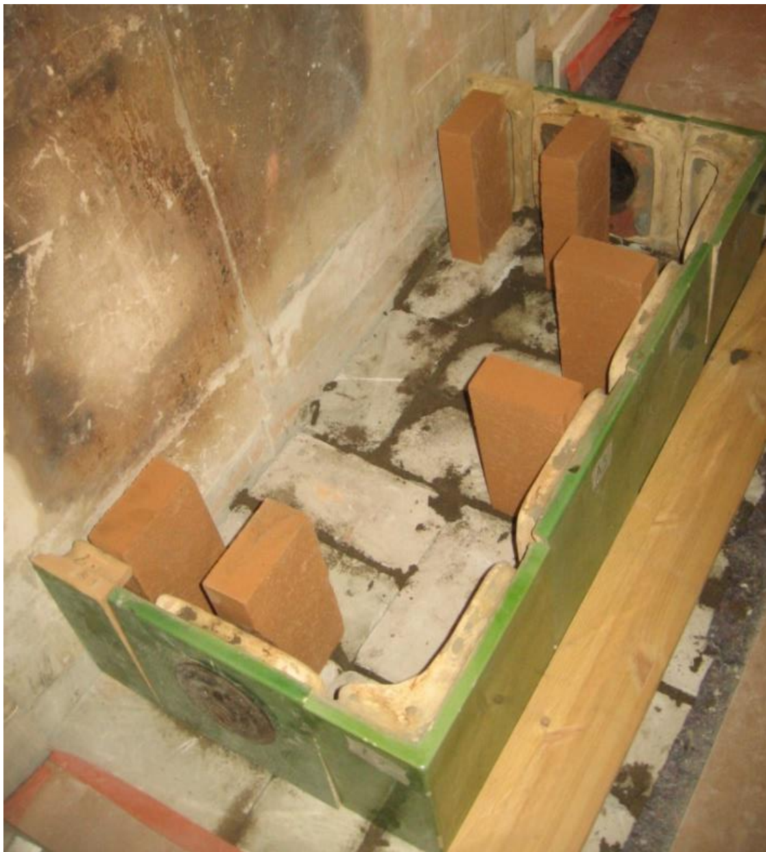
Kuva 2 Alin kaakelivarvi ladotaan kokeeksi paikoilleen ja mitoitus tarkistetaan. Koska kaakelit muurataan puskusaumaan, niin muurari kaventaa uunin leveyttä alkuperäisestä leveydestä noin sentillä, jotta saadaan peli- eli työstövaraa. Kaakeleita on mahdollista kaventaa, mutta leventämään niitä ei pysty. Tästä johtuen uunin pystysuoruutta on vahdittava jatkuvasti. Uunin eteen lattiaan on kiinnitetty väliaikaisesti suora lauta, joka toimii ohjurina.
