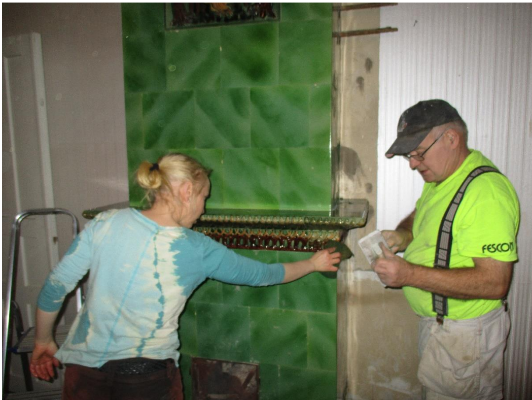
Kuva 103 Uuni pestään pehmeällä sienellä ja vedellä. Sen jälkeen muurari levittää sauma-aineen kaakeliuunin pintaan.
