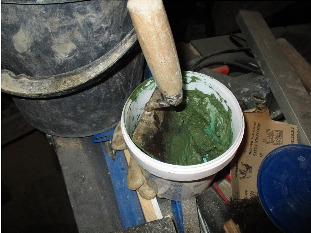
Kuva 102 Sauma-aineen on oltava mahdollisimman lähellä kaakeleiden väriä.
