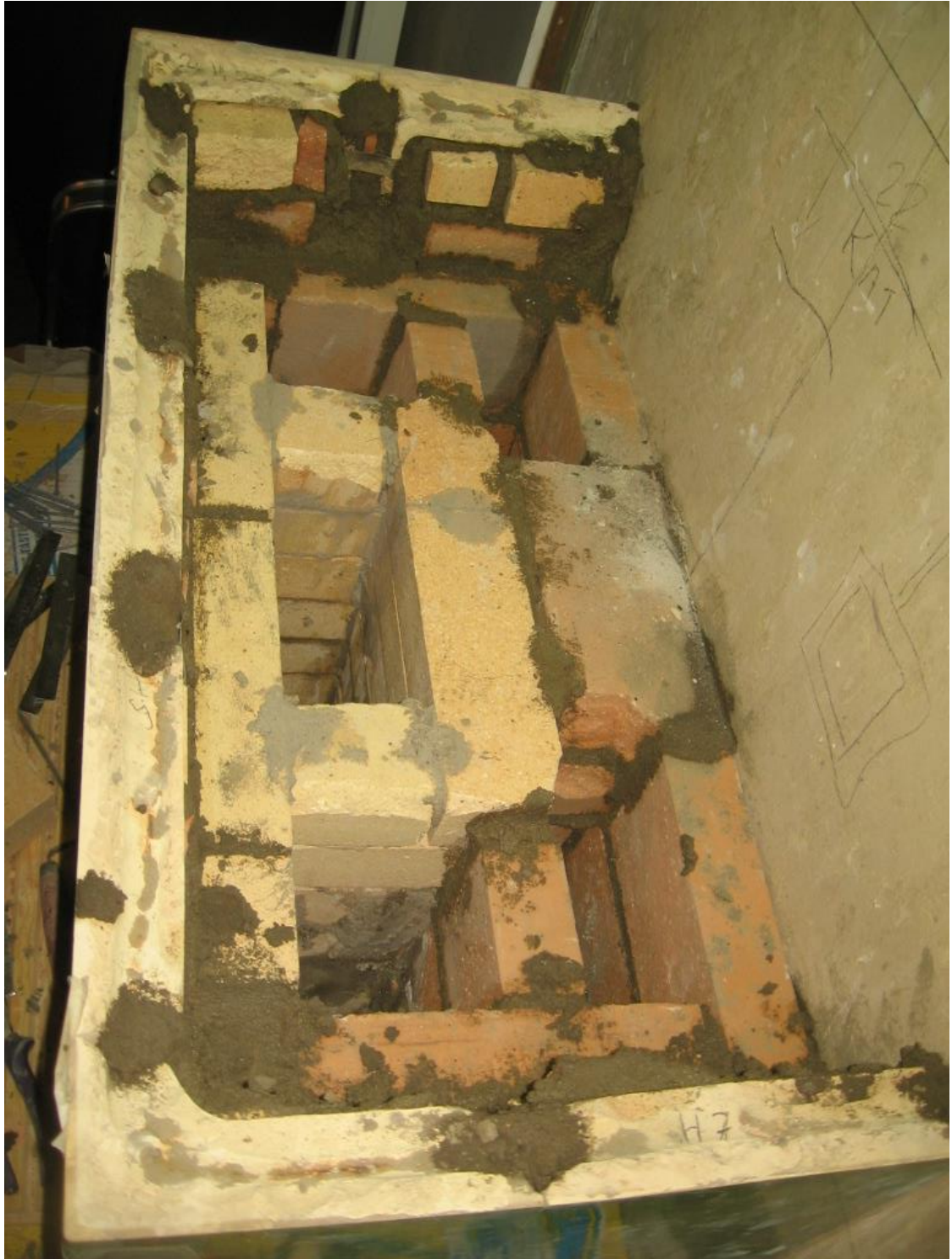
Kuva 64 Tuliputken ja etummaisten poskikanavien välisiä välitunkkia ei enää nosteta korkeammiksi. Yhden kiven kokoinen tuliputki haarautuu kahteen puolen kiven kokoiseen poskikanavaan. Saman aikaisesti taaemmat puolen kiven kokoiset poskikanavat laajenevat uunin keskiosan suuntaan kanavien yhdistymistä varten.
