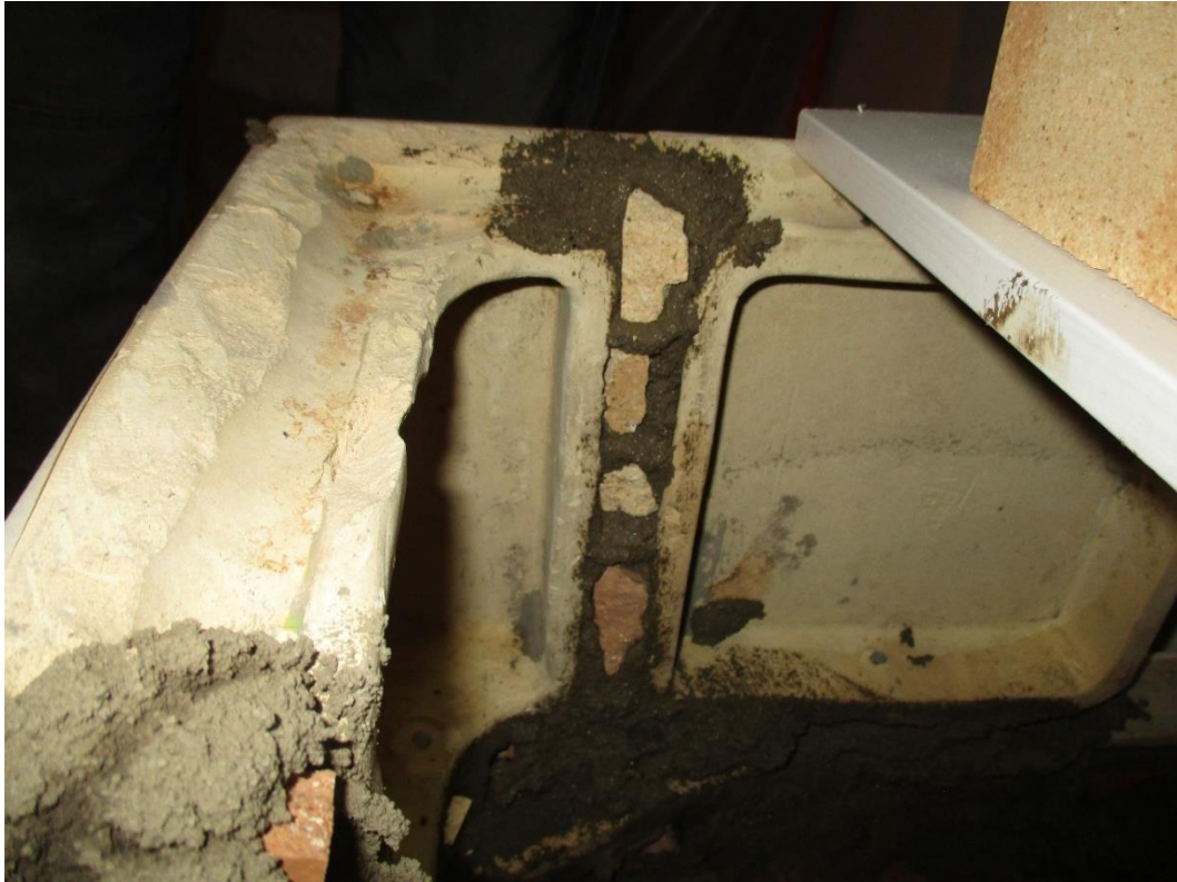
Kuva 38 Saumoihin tulee myös klemmarit. Kuppien alareunoissa oleviin reikiin työnnetään rautanaulat, jotka lukitsevat kaakelien alareunat paikoilleen.
