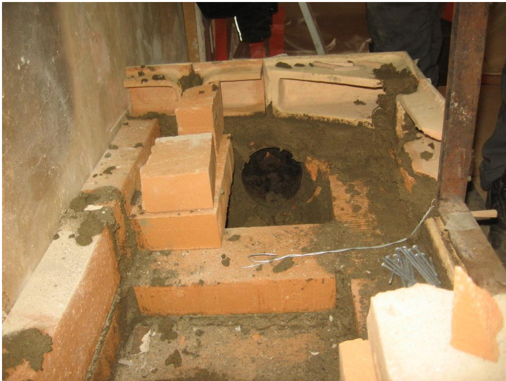
Kuva 26 Kun kaakelivarvi on kokonaisuudessaan paikoillaan, muurataan kaakelit kiinni aloittaen jälleen kuppien alapuolelta, jonka jälkeen muurataan kuppien väliset pystysaumamat.
