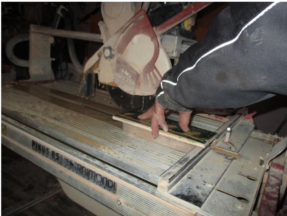
Kuva 18 Kaakeleita muurari työstää erilaisin työvälinein. Pitkää ja suoraa reunaa vaativat työstöt tehdään timanttilaattaleikkurilla.
