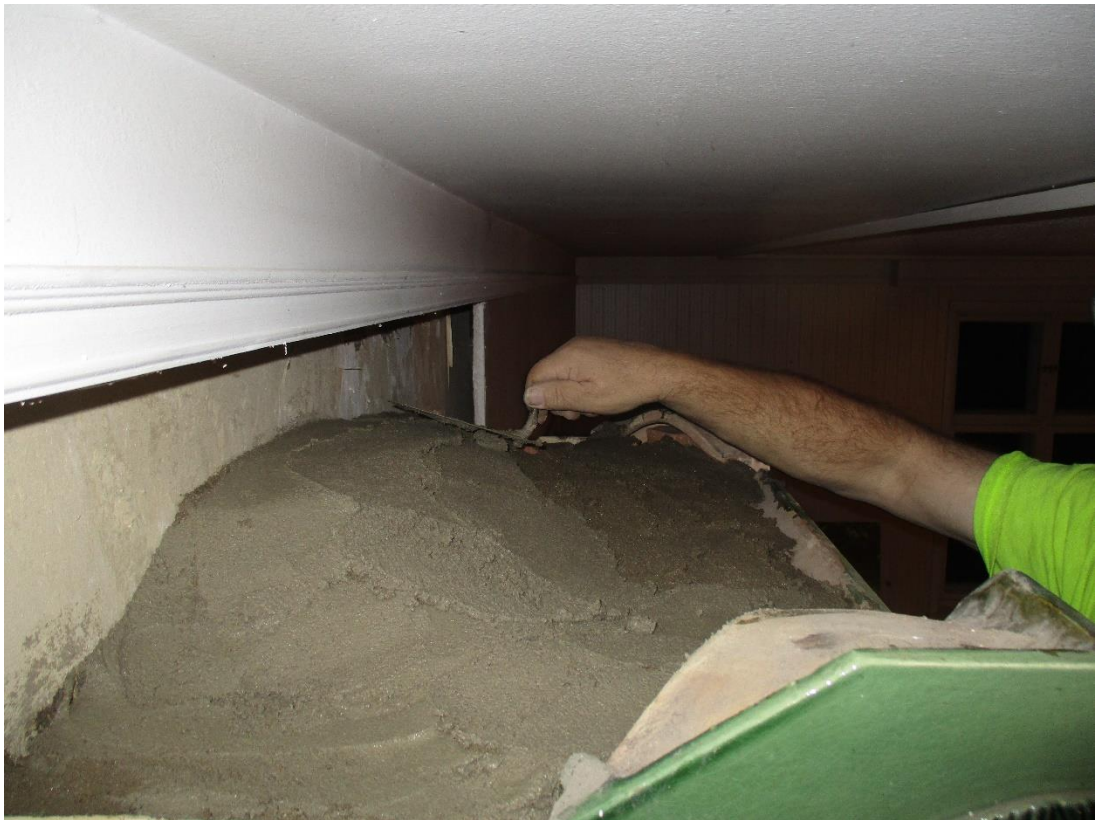
Kuva 98 Lopuksi muurari peittää uunin laen muurauslaastilla.
