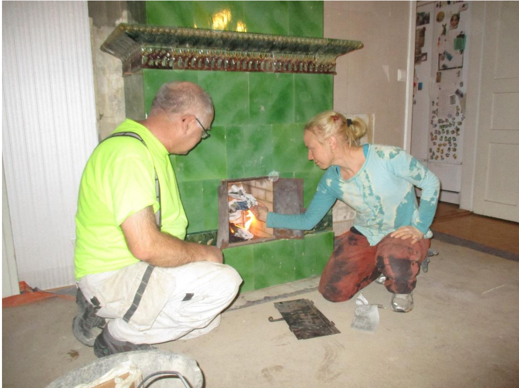
Kuva 100 Uunin veto testataan polttamalla muutama sivu sanomalehteä.
