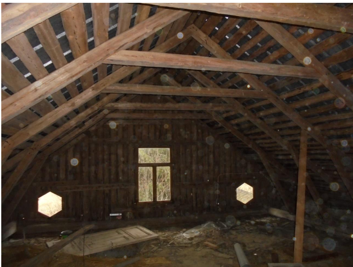
Kuva 34 Vesikaton ja yläpohjan rakenteet olivat kokonaan tarkastettavissa rakennuksen vintiltä käsin. Ne ovat hyvässä kunnossa ja vintti on rakenteineen kuiva.
