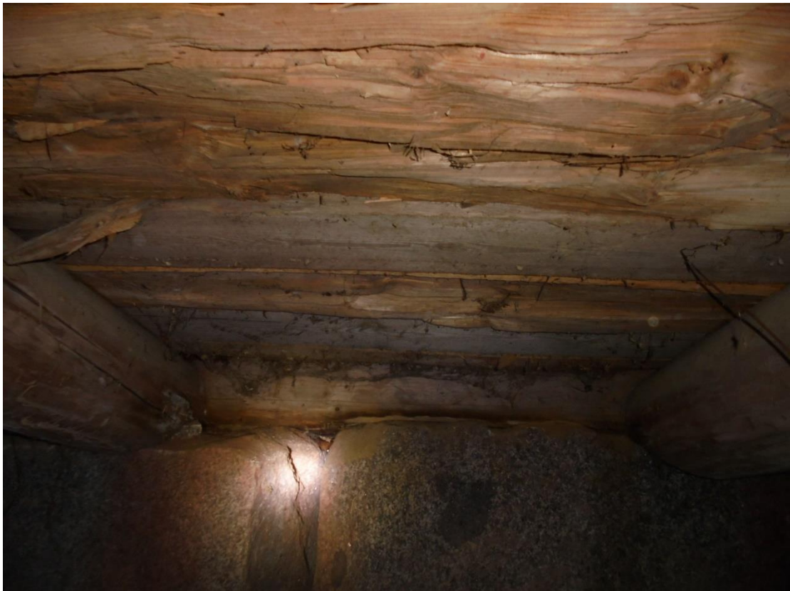
Kuva 20 Alin hirsikerta oli nähtävissä ryömintätilasta käsin ja siinä ei havaittu vaurioita.
