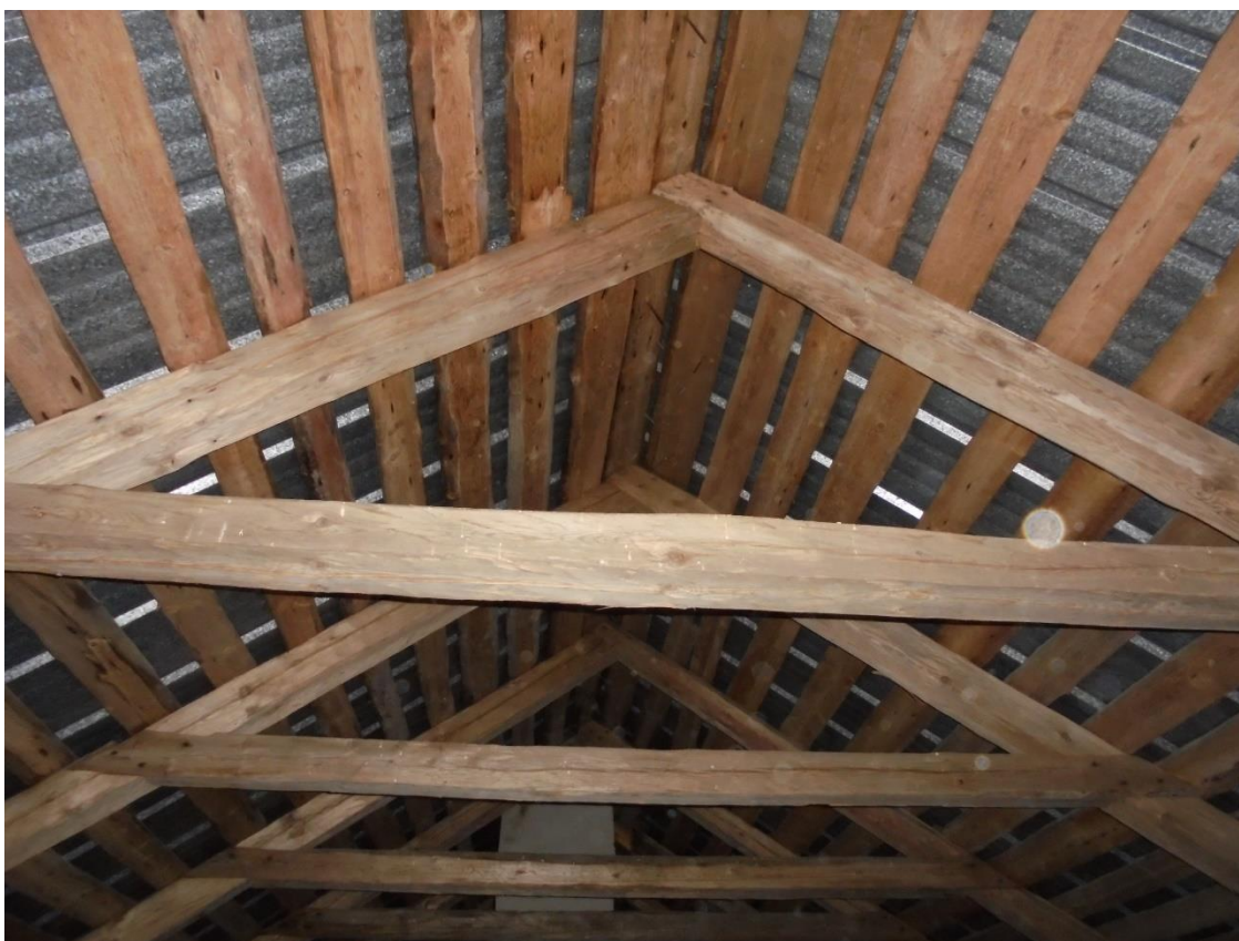
Kuva 36 Aluslaudoitus on alkuperäinen pärekaton aluslaudoitus. Se on asennettu tiheällä jaolla, joka vähentää hieman peltikaton ominaista kosteuden kondensoitumista.
