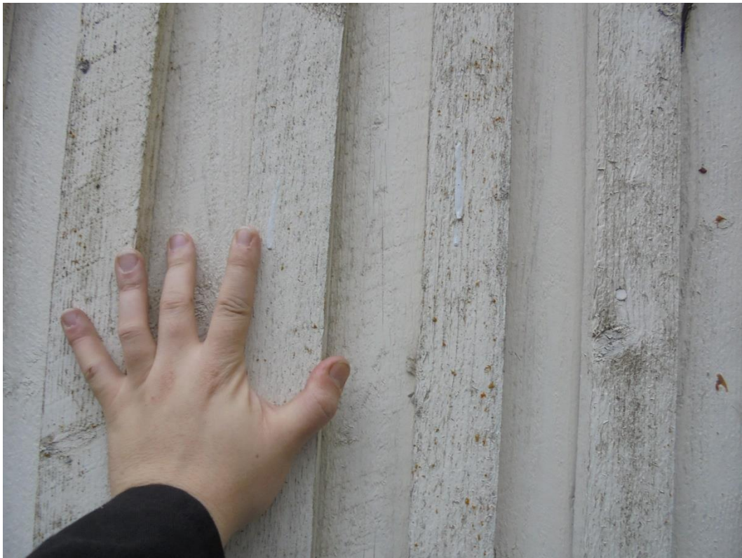
Kuva 24 Aurinko ei ole juurikaan vaurioittanut ulkovuoren pintaa.
