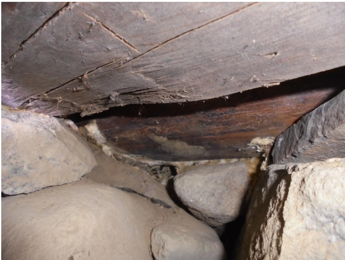
Kuva 13 Pönttöuunin perustuksissa on valkoista sienikasvustoa, joka ei ole kuivunut.
