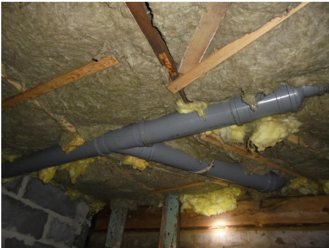
Kuva 32 Mineraalivilla ilman tuulensuojalevyä ei toimi lämmöneristeinä.
