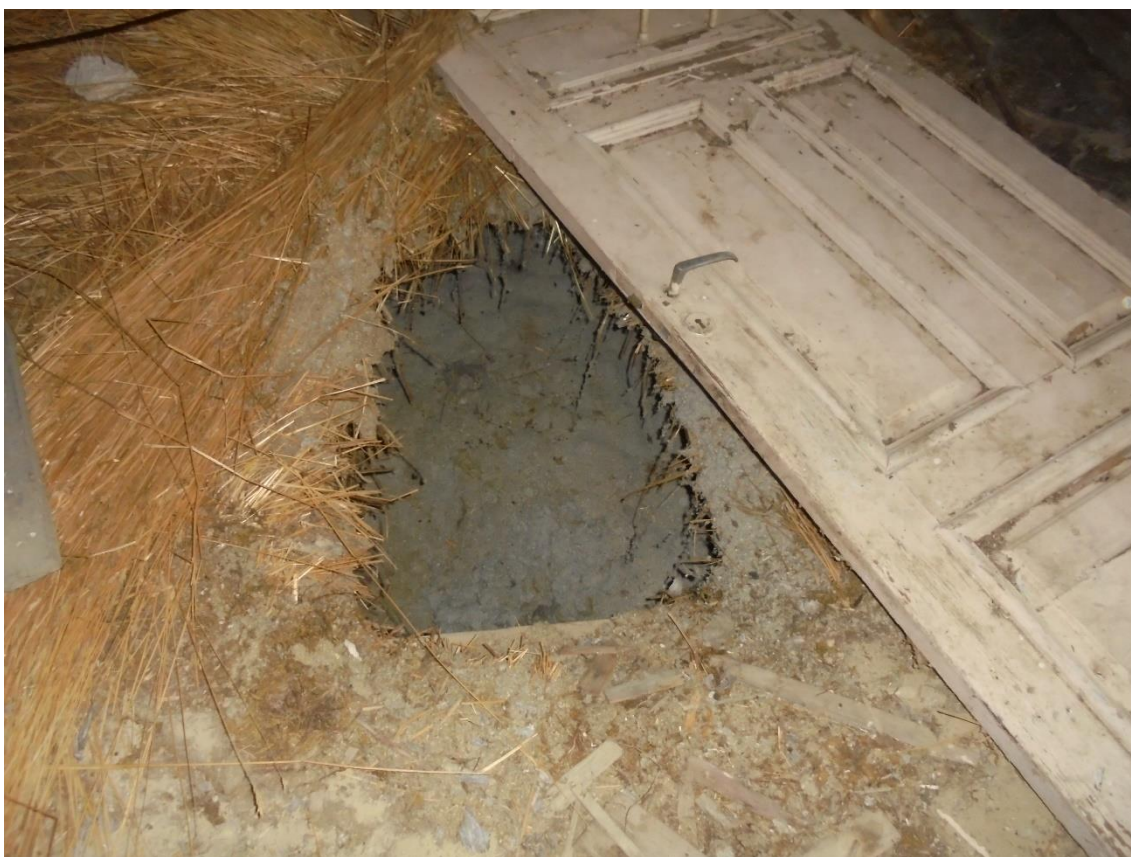
Kuva 39 Yläpohjassa on lämmöneristettä kahdessa eri kerroksessa alaslaskuista johtuen.
