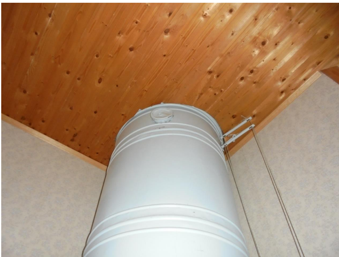
Kuva 44 Kattorakenteiden sisässä oleva tulisija muodostaa paloturvallisuusriskin, mutta nuohooja ei ole pönttöuunin käyttämistä kieltänyt, joten sitä voi käyttää.
