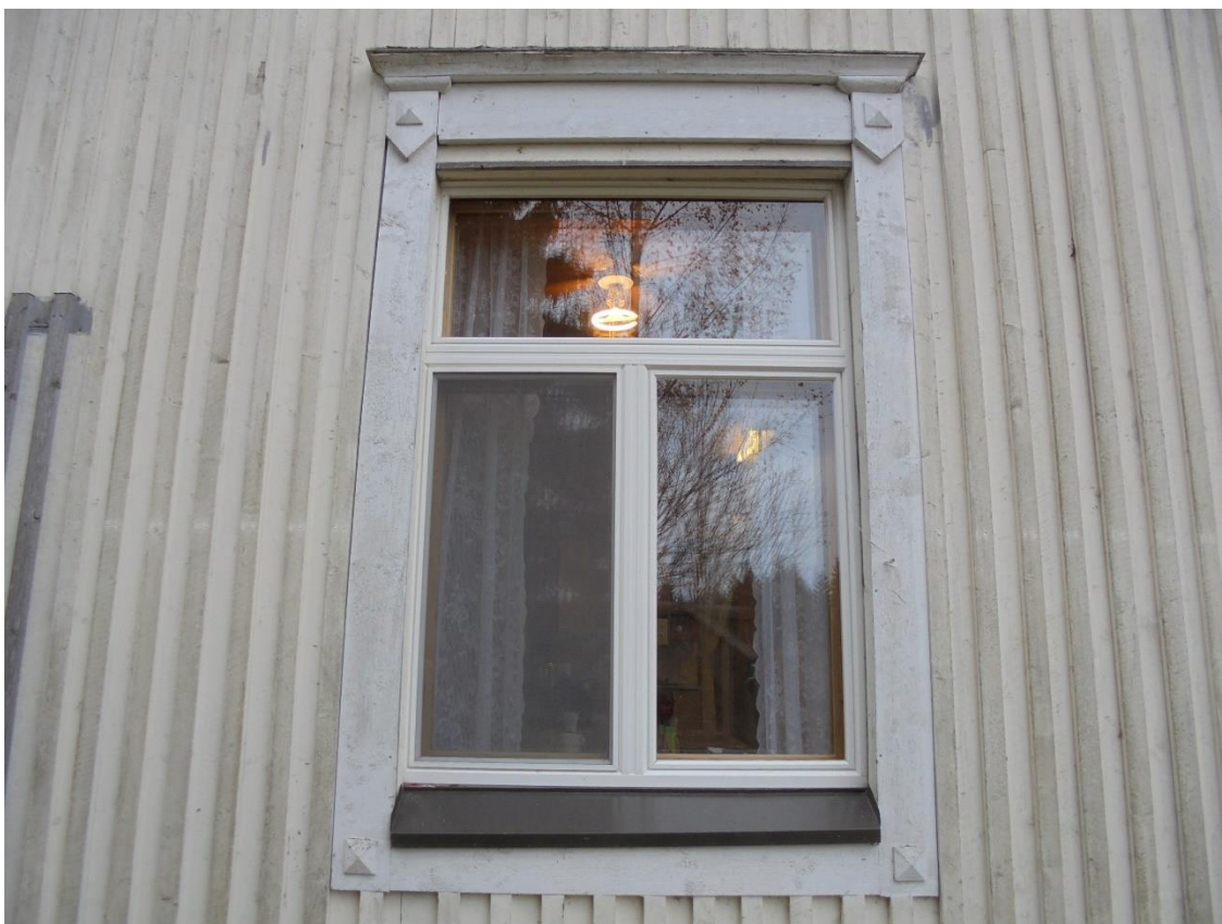
Kuva 40 Uudemmat ikkunat ovat puu-alumiini-ikkunoita.
