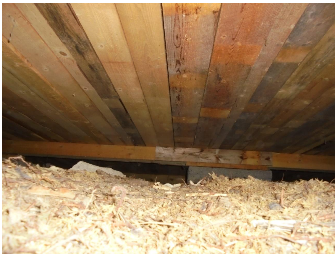
Kuva 25 Pohjoispäädyn ryömintätila on matala, mutta siellä ei havaittu vaurioita.
