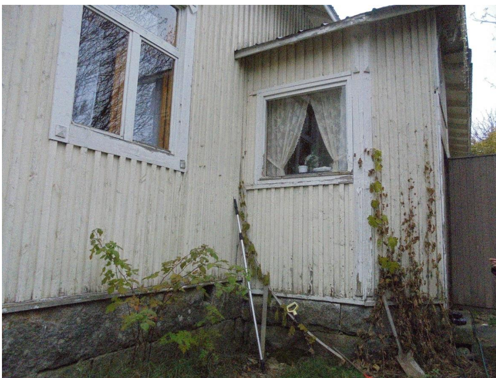
Kuva 9 Vesikourujen asentaminen kuistin katolle lopettaa sadeveden kulkeutumisen varsinaisen rakennuksen seinää päin.
