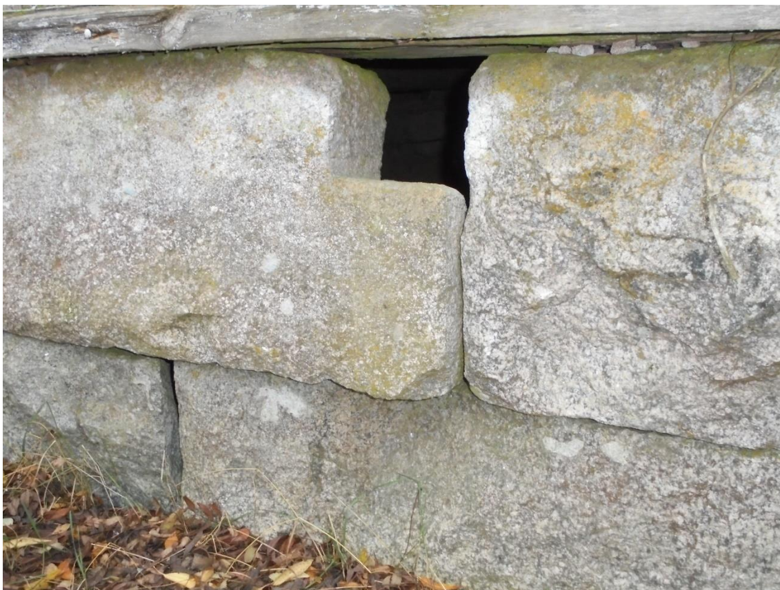
Kuva 12 Kivien väliin muodostuneet raot tai osittain ulospäin pullahtaneet kivet eivät tarvitse kunnostustoimenpiteitä.
