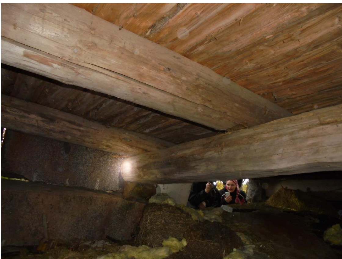
Kuva 29 Haltijapalkit kulkevat rakennuksen harjan suuntaisesti ryömintätilassa.
