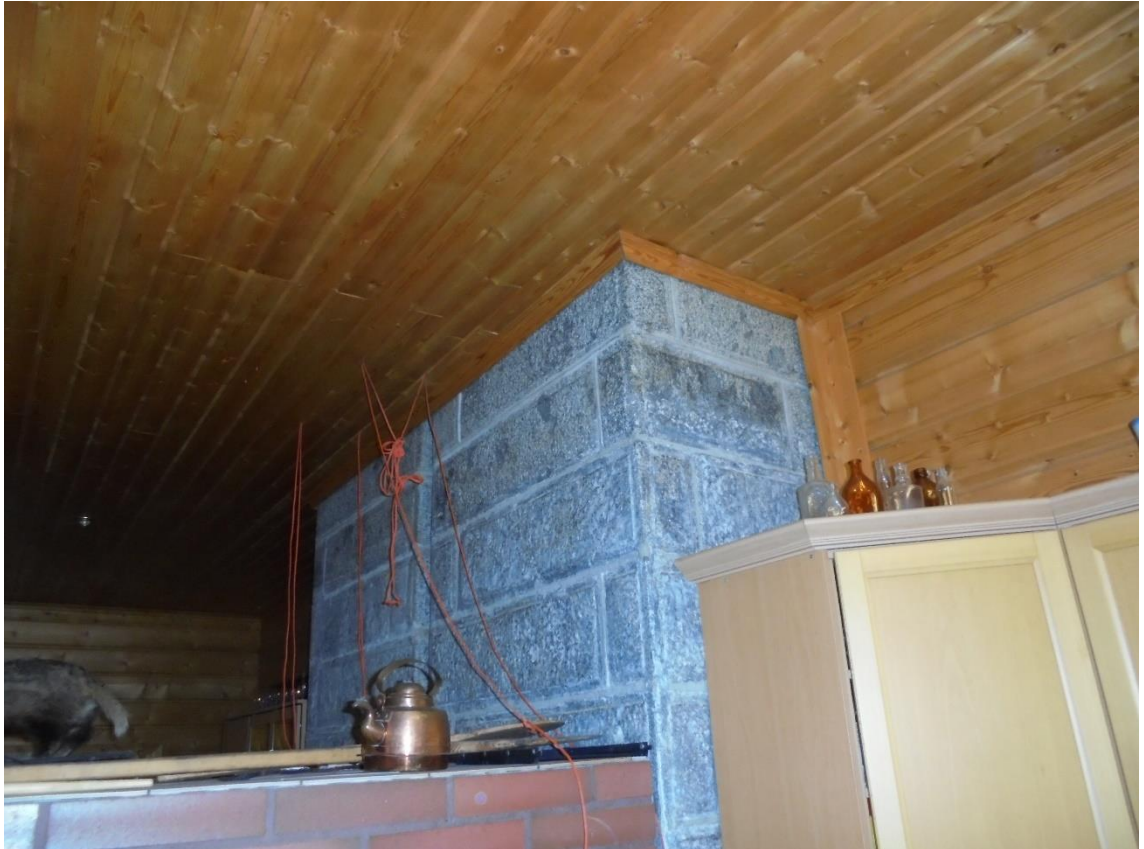
Kuva 49 Tupakeittiön alkuperäisten tulisijojen sulkupellit ovat alaslaskettujen sisäkattojen yläpuolella.
