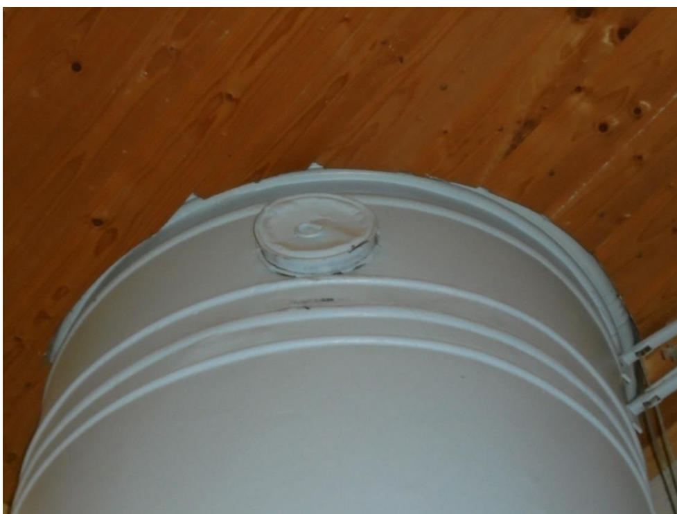
Kuva 48 Tähti-ilmaventtiili on perinteinen poistoilmalaite. Varsinainen venttiili on myöhemmin korvattu tavallisella nuohousluukulla.
