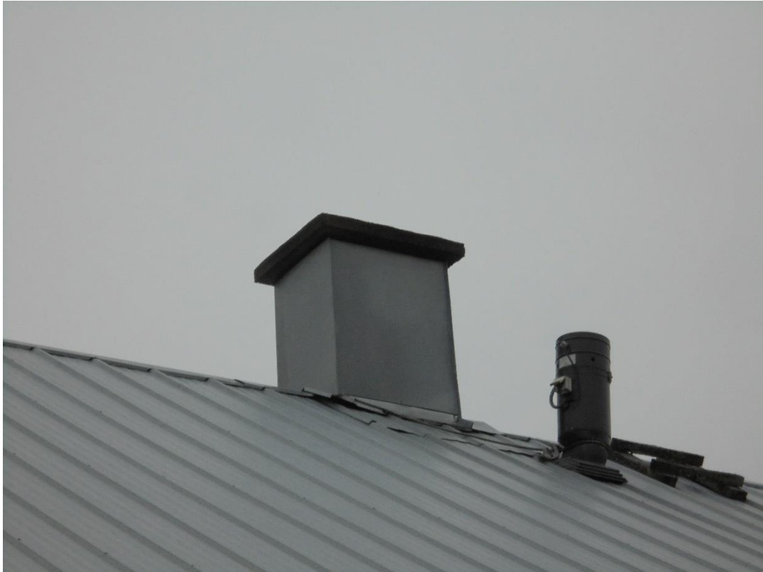
Kuva 45 Molemmat savupiiput on pellitetty, mutta niiden päällä ei ole sadehattuja.
