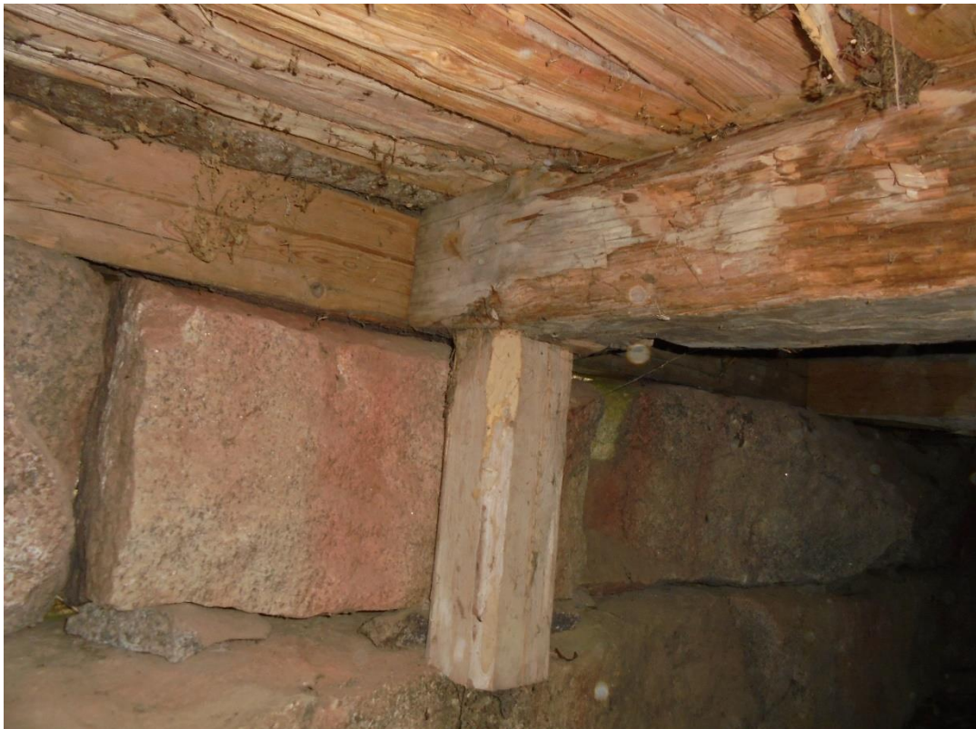
Kuva 30 Osa niskojen päistä tukeutuu puisilla pystytuilla perustuskiviin.
