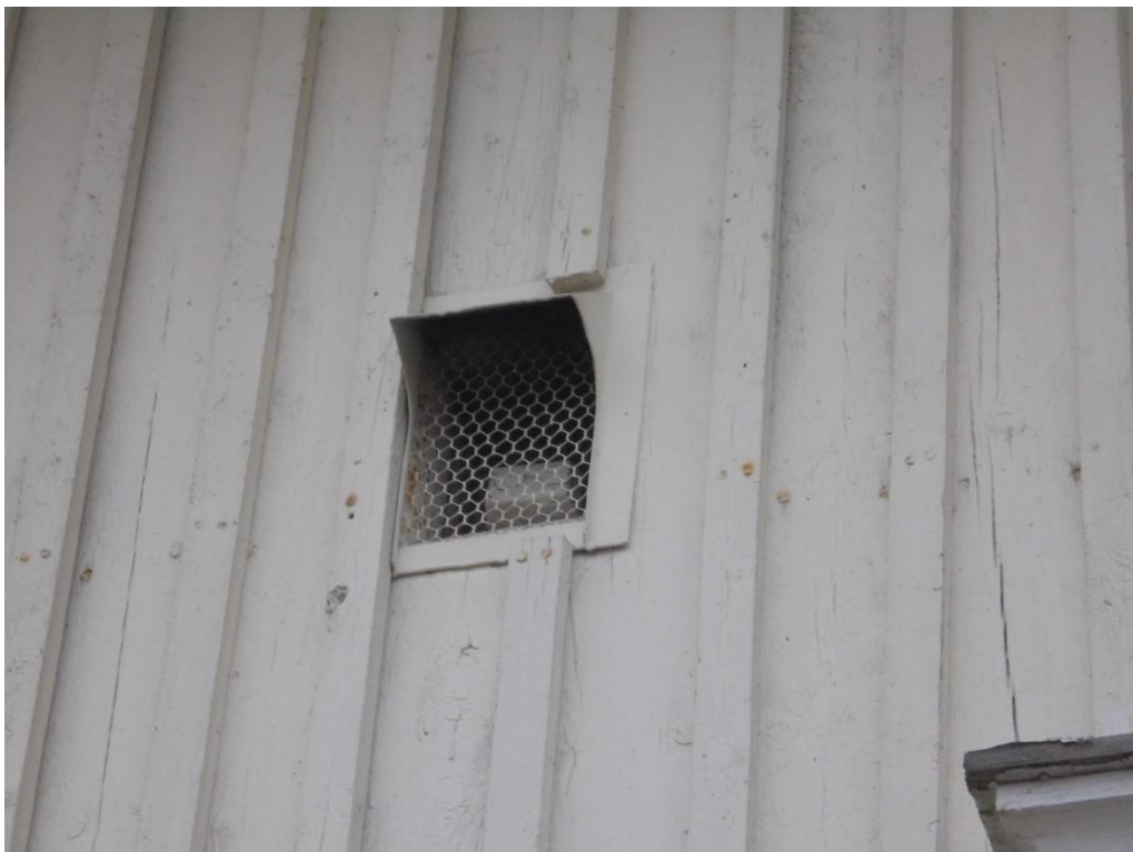
Kuva 55 Perinteisesti koulurakennuksissa on ollut paljon raitisilmaräppänöitä.
