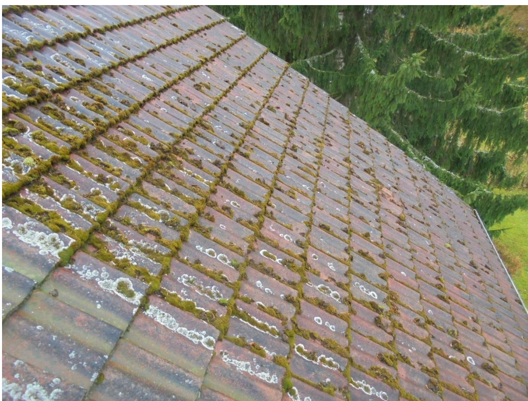
Kuva 33 Vesikatolla kasvaa sammalta. Jos sammalta poistetaan katolta, niin se on tehtävä lapetikkaiden päältä, sillä hauraat tiilet eivät kestä katolla kulkemista.
