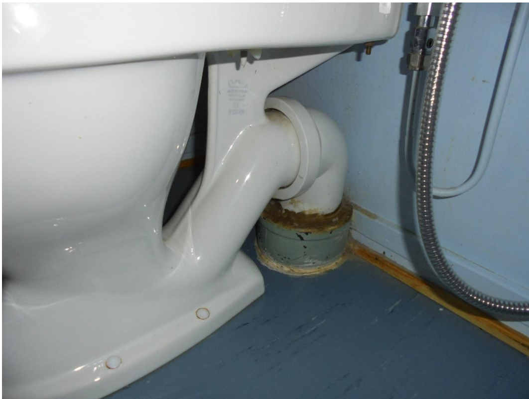
Kuva 49 Vanhetessaan valurautaputket tukkeutuvat, haurastuvat tai kuluvat puhki.
