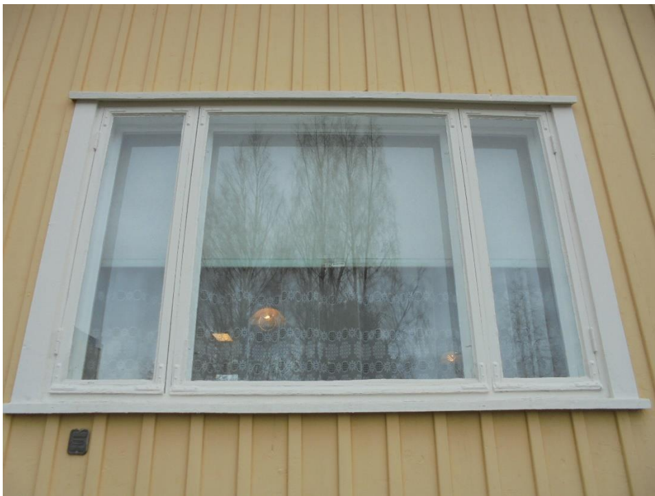
Kuva 35 Ikkunat ovat alkuperäisiä sisään-ulosaukeavia puuikkunoita.
