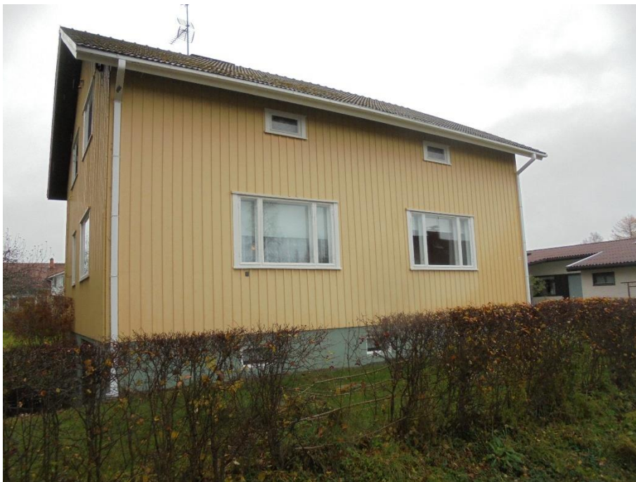
Kuva 1 Kohteena oli vuosien 1958 ja 1963 välillä rakennettu RM-talo Tampereella. Rakenteiltaan ja materiaaleiltaan rakennus on 1950-luvulle tyypillinen rakennus.
