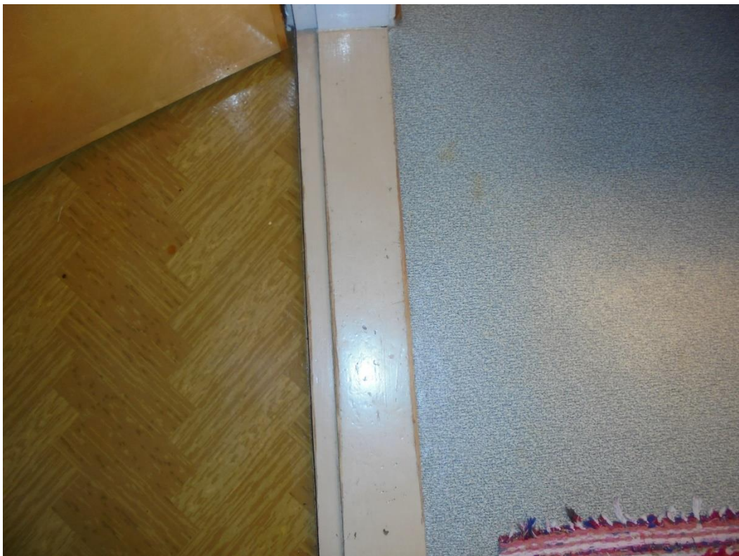
Kuva 24 Lattioiden pintamateriaali on pääsääntöisesti linoleum- tai strakulamattoa, jonka alapuolella on joko alkuperäinen ponttilautalattia tai ns. raakalaudoitus.
