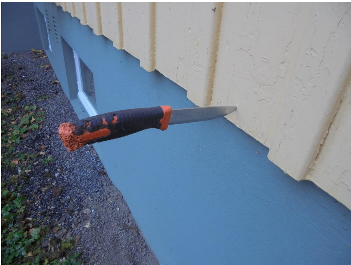
Kuva 22 Edes peiterimalaudoituksen alahelmassa ei ollut lahovaurioita.
