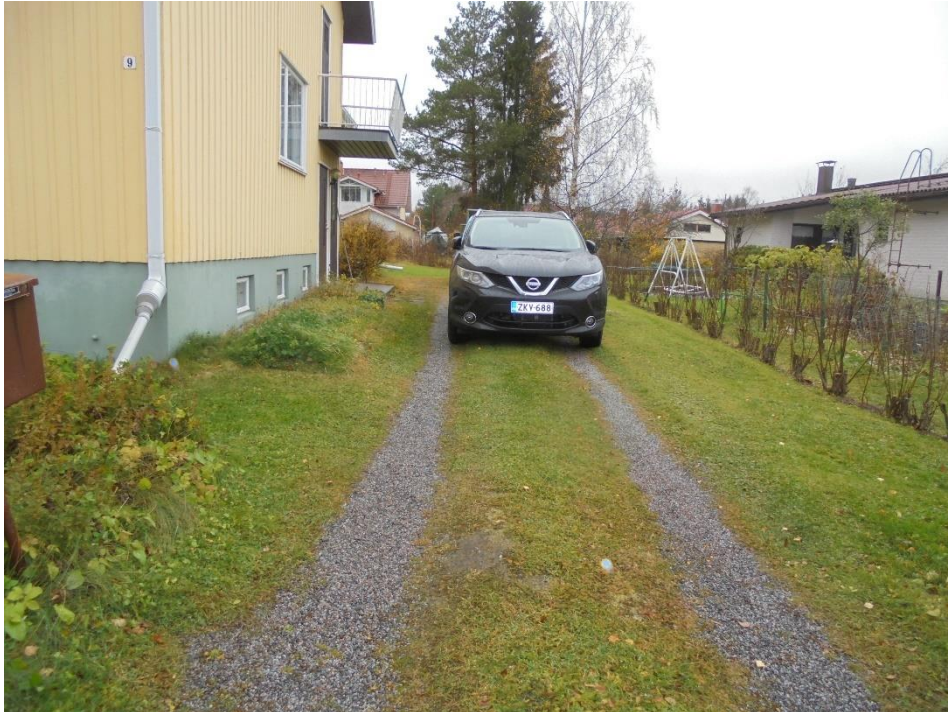
Kuva 4 Koillisen puoleisessa päädyssä on oikeansuuntaiset kallistukset.
