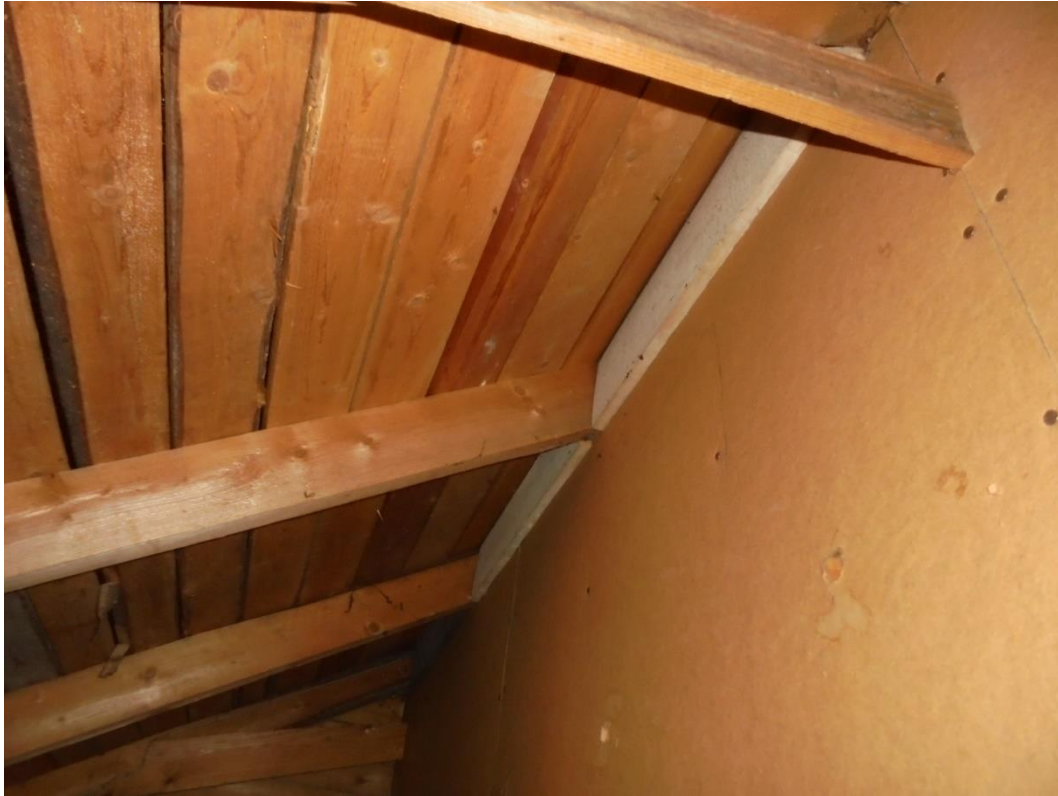
Kuva 30 Tuuletusrakojen tulisi olla alapäistään auki kylmälle sivuvintille...
