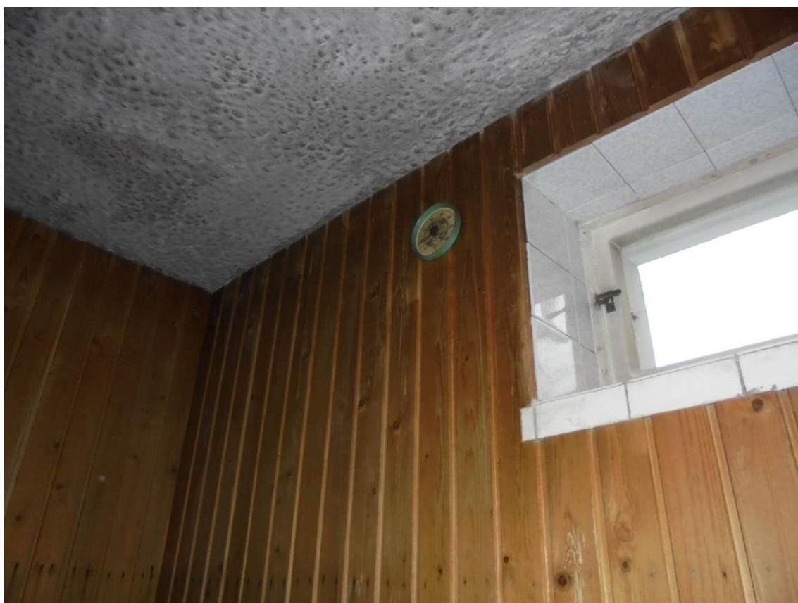
Kuva 12 Vain löylyhuoneen seinissä on puisia koolausrakenteita, mutta ne pääsevät seinäpaneelien tapaan kuivumaan sisätilojen suuntaan. Löylyhuoneessa on perusmuuria vasten alumiinipintainen rakennuspaperi, jonka päällä on koolaus ja paneeli. Lämmöneristettä seinärakenteessa ei havaintojen perusteella ole.
