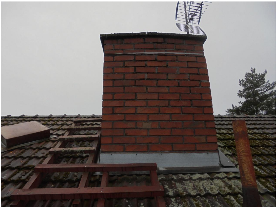
Kuva 38 Piippua ei ole pellitetty tai hatutettu. Hattu on hyödyllisempi, kuin pellitys.
