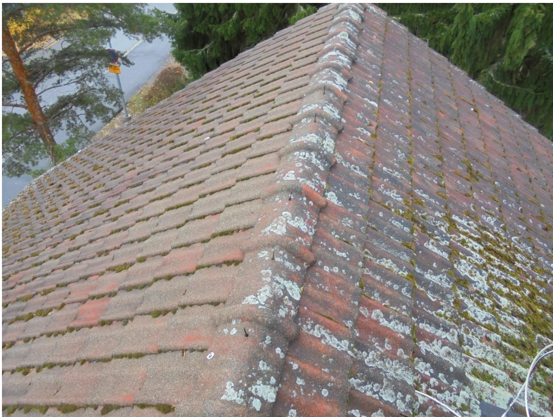
Kuva 34 Etupihan puoleinen kattolape on hieman sammaloituneempi kuin kadunvarsijulkisivun lape.
