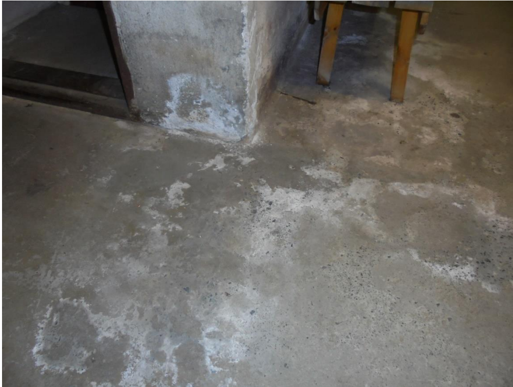
Kuva 15 Kalkkihärmä on tavallinen näky RM-talojen kellareissa.
