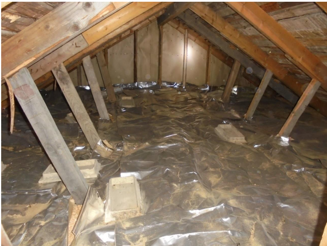
Kuva 29 Alumiinipaperi eli kinkkupahvi on poistettava yläpohjasta.
