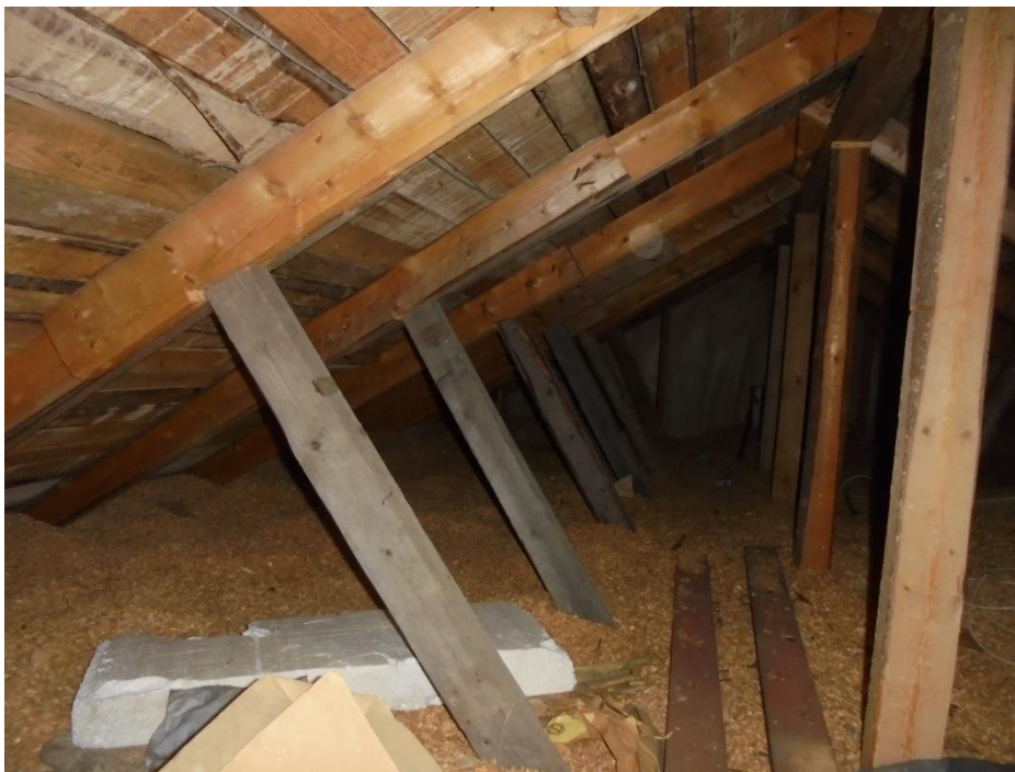
Kuva 27 Vesikaton rakenteet olivat havaituilta osin kuivat ja terveet.
