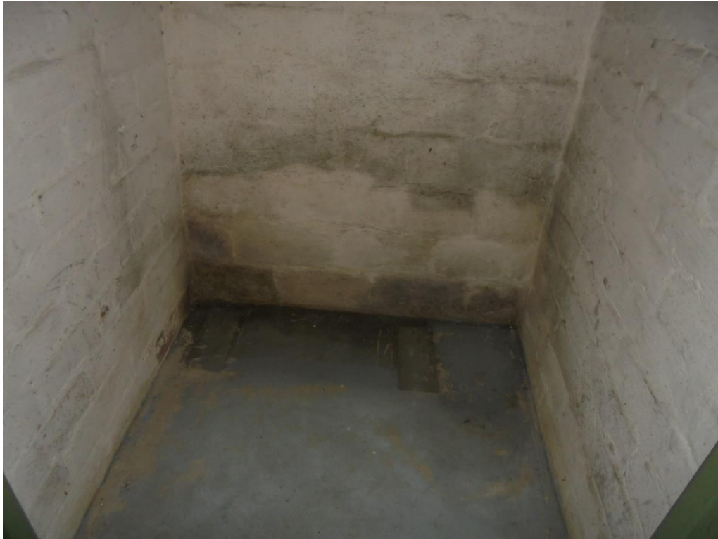
Kuva 16 Värimuutokset ovat tyypillisiä merkkejä kosteudesta kellarissa.
