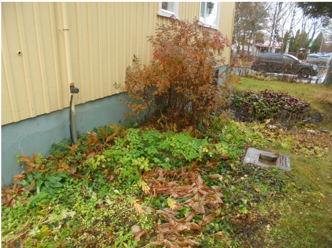
Kuva 9 Korkean ja tuuhean kasvillisuuden tulisi olla niin kaukana perusmuureista, että istutusten ja rakennuksen välistä pystyy kulkemaan. Pensas on poistettava ja kasvillisuus on pidettävä matalana niittämällä.
