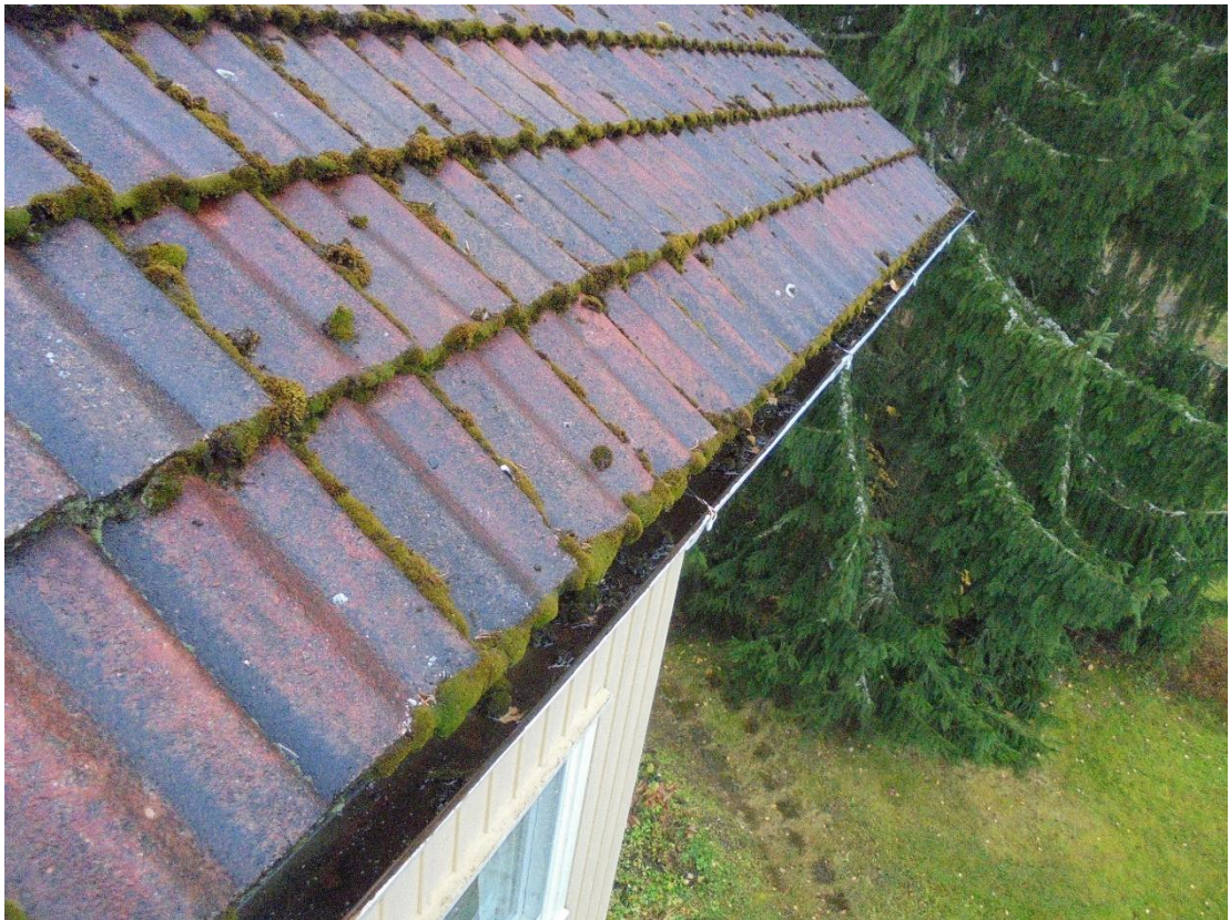
Kuva 7 Sadevesikourut ovat täynnä sammalta, maatuvia lehtiä sekä havunneulasia. Kourut on tyhjennettävä roskista vähintään kahdesti vuodessa.
