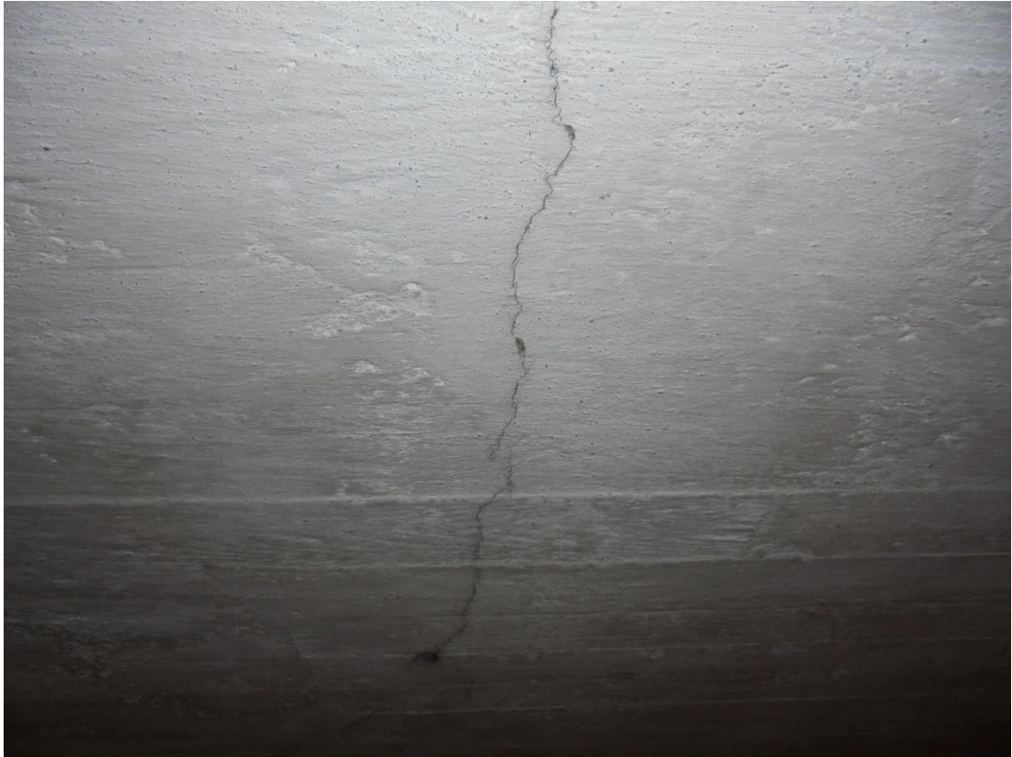
Kuva 26 Lähes kaikissa huoneissa kellarissa oli nähtävissä betoniholvin halkeilua.
