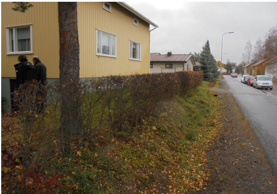
Kuva 3 Avo-oja kuivattaa rakennuksen välitöntä ympäristöä tehokkaasti kaakon puoleisella julkisivulla.
