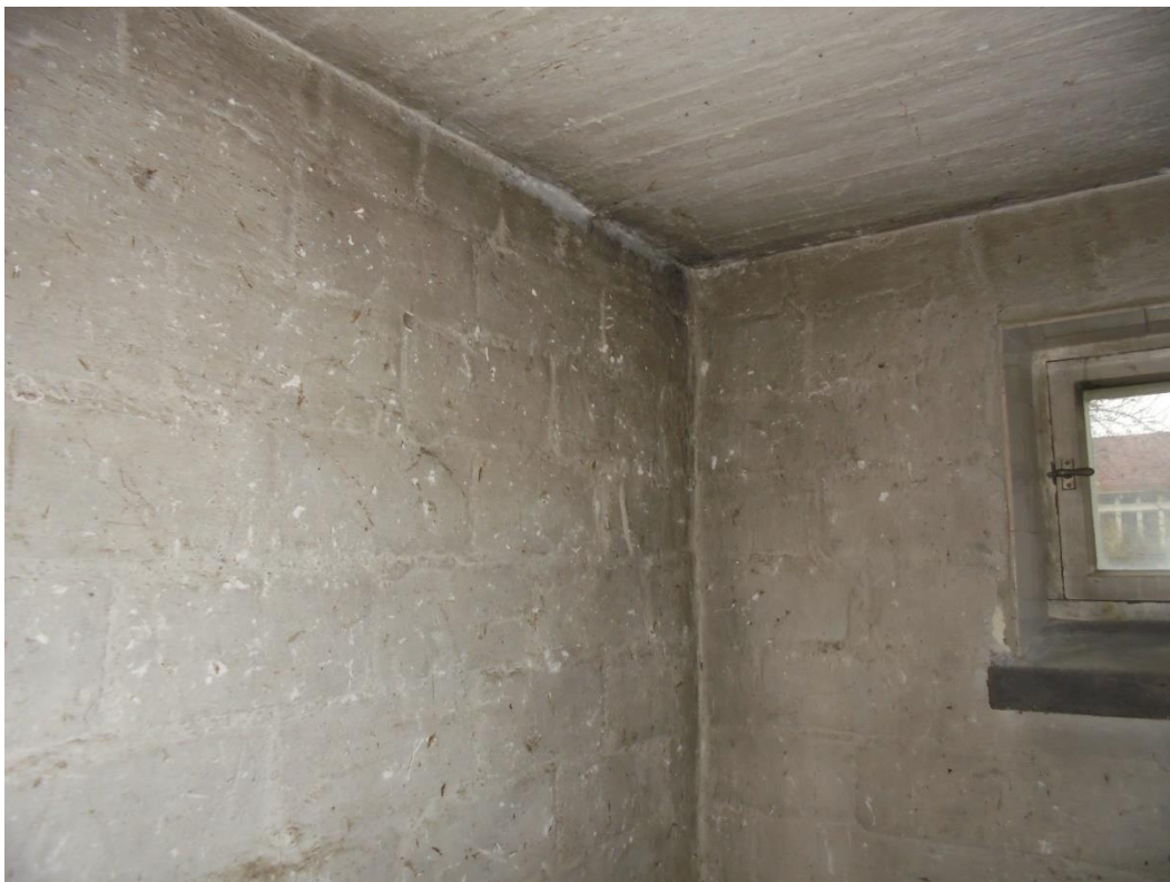
Kuva 11 Tämän rakennuksen rivinteerauksen ja perusmuurin välissä ei ole juurikaan ilmarakoa.
