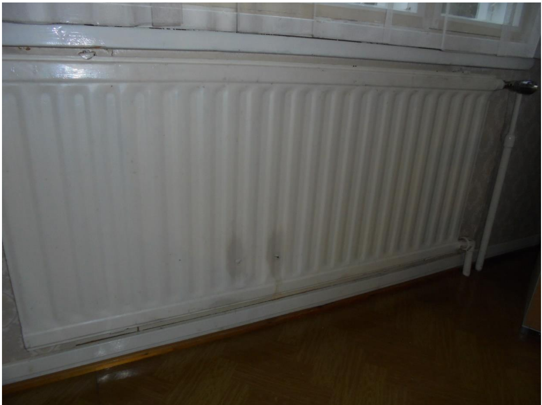
Kuva 47 Pattereista ja niiden putkistoista ei havaittu puutteita.
