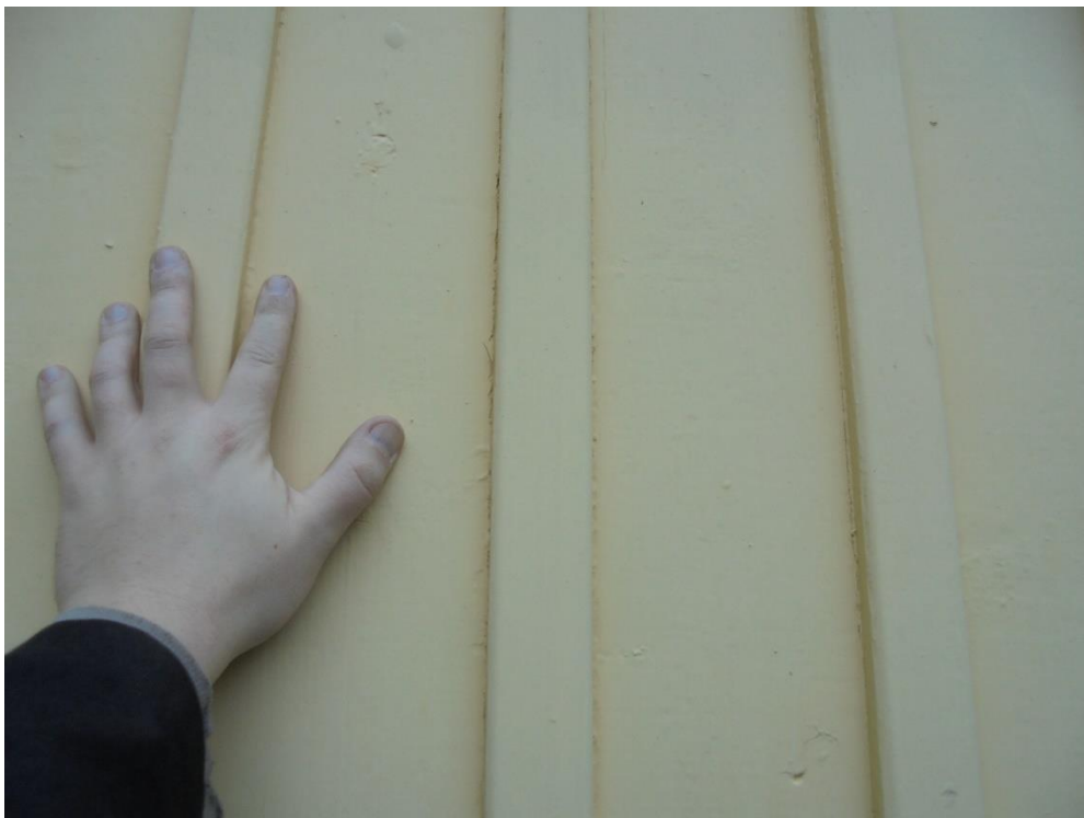
Kuva 21 Ulkovuori on hyvässä kunnossa ja edelleen pitkäikäinen.
