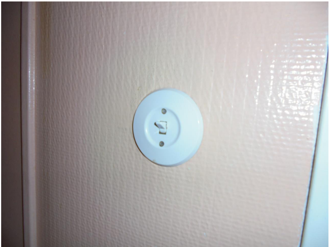
Kuva 48 Sähkötä on uusittava kunnostustöiden yhteydessä. Työ voidaan tehdä huone kerrallaan.
