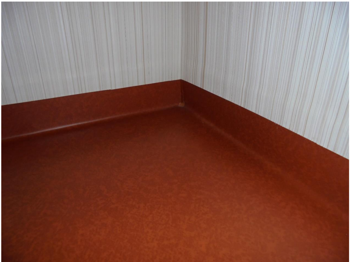
Kuva 45 Muovimatolla on muodostettu vesieristetty kaukalo.
