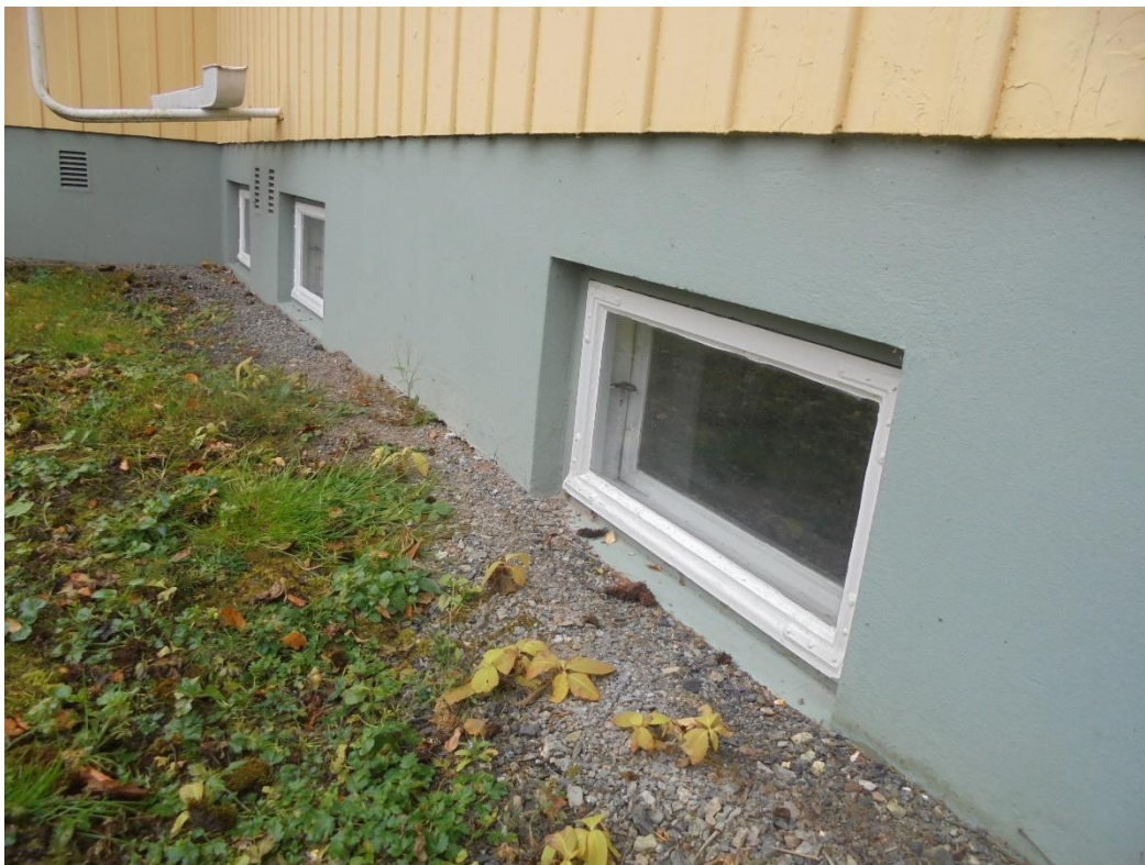
Kuva 6 Maanpinta on korkeimmillaankin riittävän alhaalla puihin rakennusosiin nähden, mutta ikkunat ovat liian lähellä maanpintaa.
