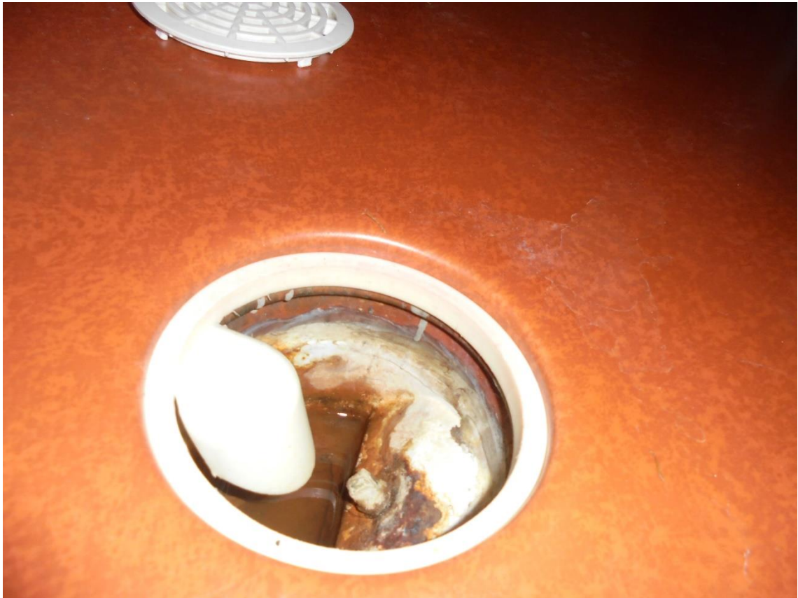
Kuva 44 Korokerengas muodostaa aina epätiivin kohdan. Muovimatto liittyy oikealla tavalla viemärikaivoon ja kirstysrengasta on käytetty.
