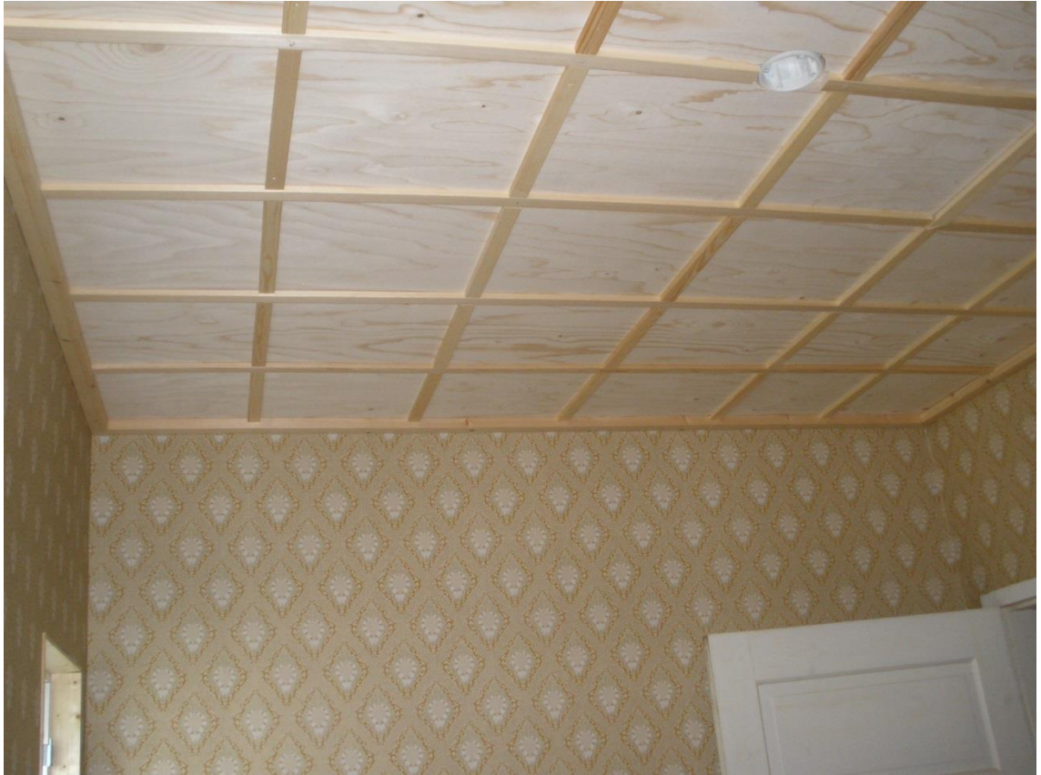
Kuva 30 Viimeisenä lisätään listoitukset ikkunoihin, oviin, lattioihin sekä kattoon.
