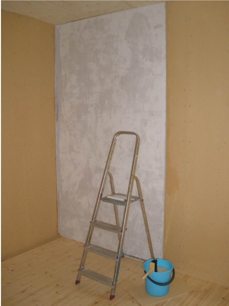
Kuva 21 Vettynyt pinkopahvivuota asennetaan paikoilleen tapettiliipalla liipaten. Pinkopahvi on liisteristä niin vettynyt, että kosteus tulee sen lävitse. Märkä vuota on painava, joten sen käsitteleminen apumiehen tai -naisen kanssa on helpompaa. Seuraava vuota asennetaan noin 10cm edellisen päälle eli limisaumaan.
