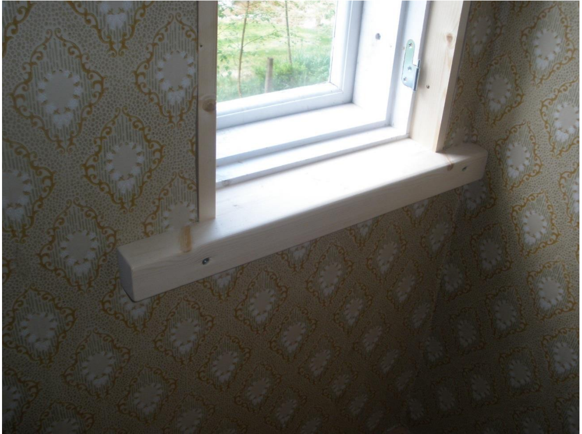
Kuva 29 Tapetoinnin valmistuttua asennetaan ikkunoihin smygilistat sekä ikkunapenkit.
