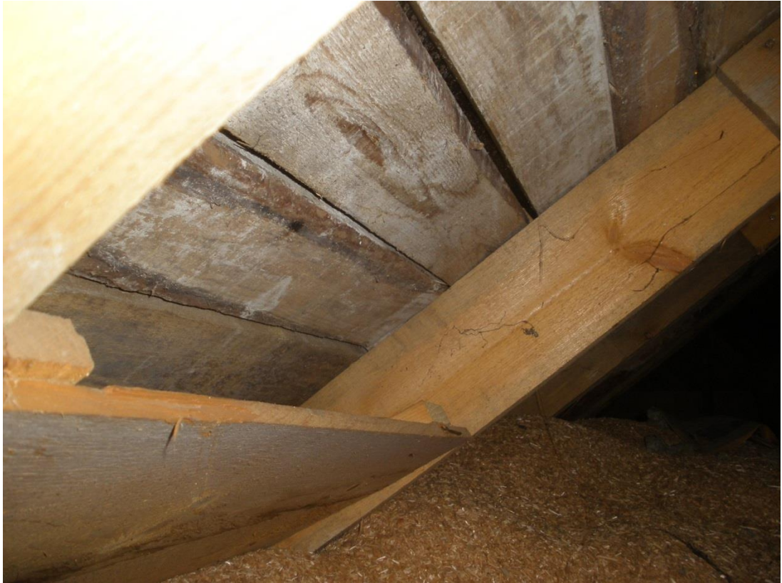
Kuva 27 Tuuletusraon muodostavat laudat toimivat tuulenohjureina.
