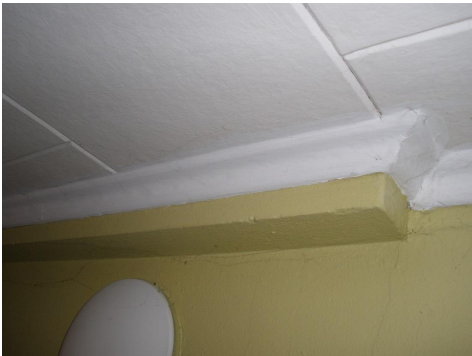
Kuva 36 Ja sen läpivienteihin on muurattu paksunnokset.
