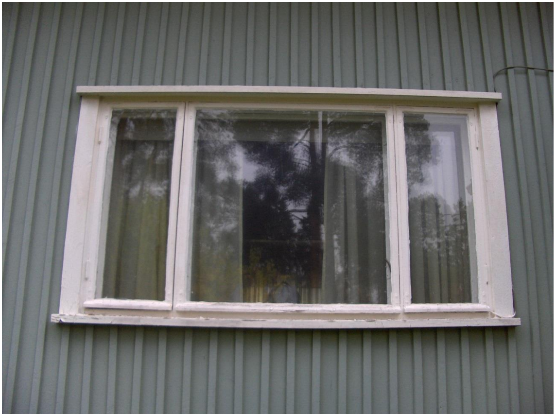
Kuva 30 Ikkunat ovat alkuperäiset ja kunnostamiskelpoiset.
