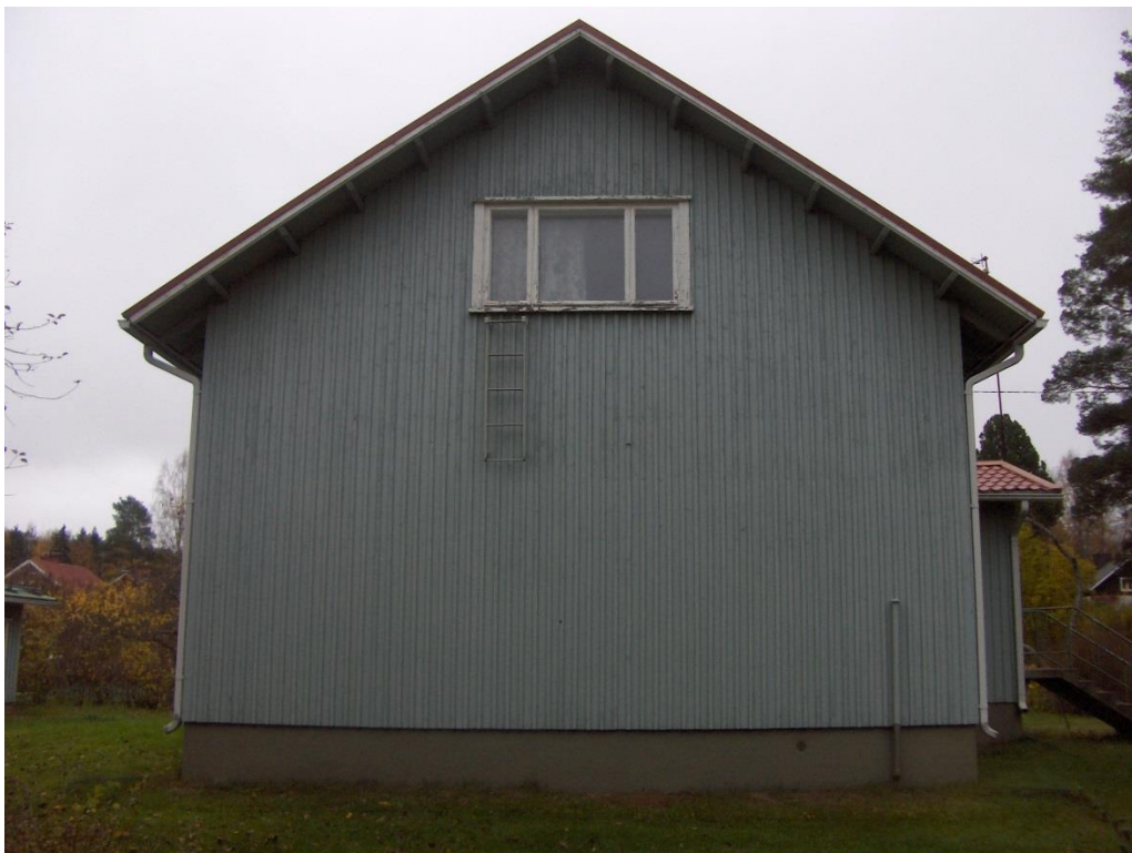
Kuva 4 Eteläpäädystä kallistukset ovat oikeansuuntaiset.
