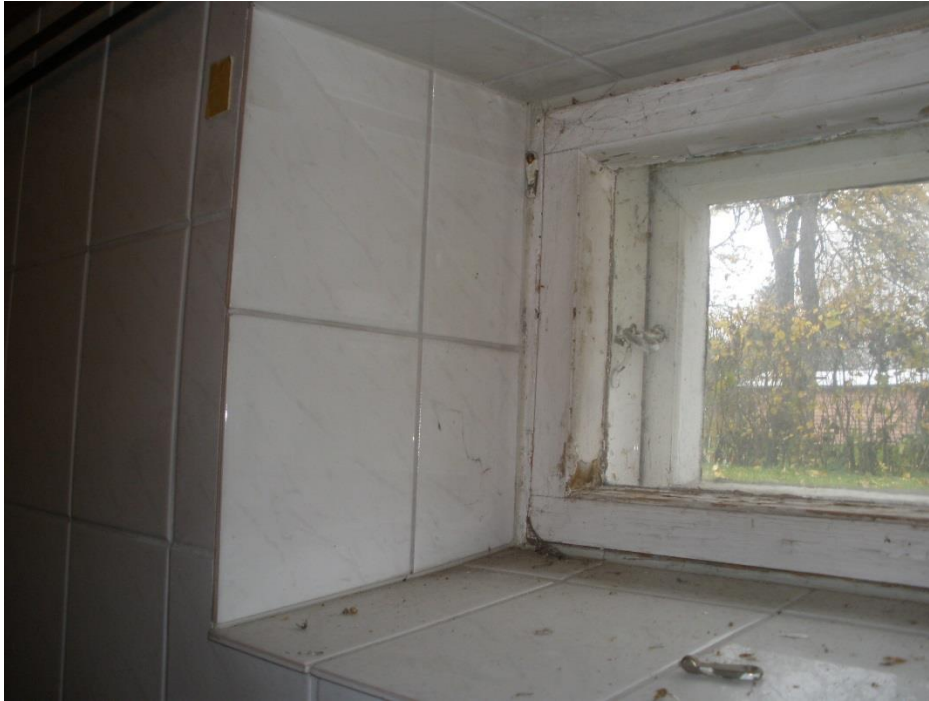
Kuva 12 Pohjoispäädyn kellaritiloissa on sisäpuolinen lisälämmöneriste.
