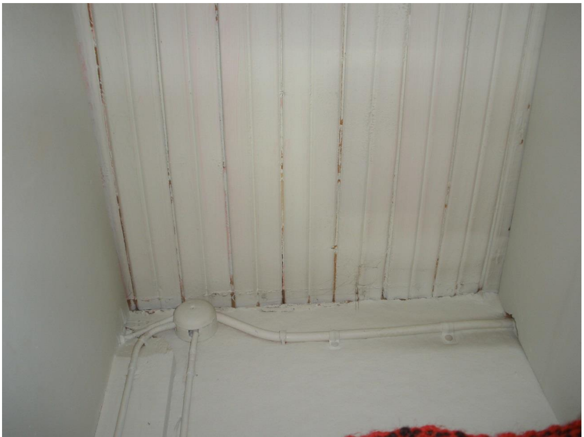
Kuva 39 Kiintokomeroitten katoista näkee, että onko uudempien kerrostumien alla alkuperäiset jäljellä. Kuvassa alakerran makuuhuoneen karossi- eli siskonpaneeli.
