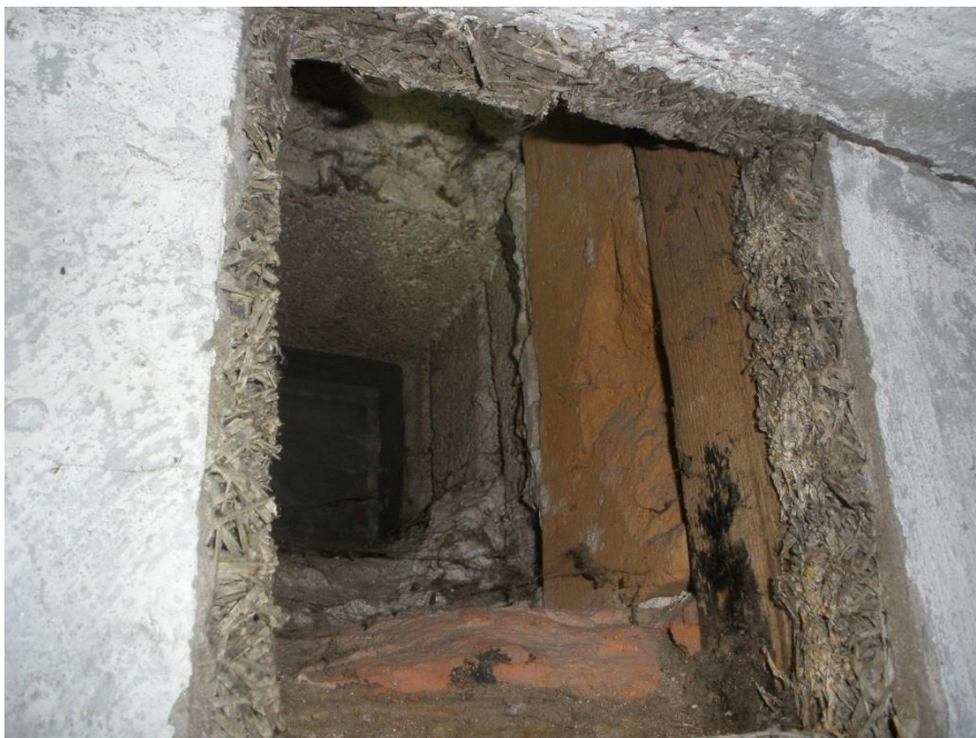
Kuva 14 Kuistin alla olevassa kylmäkellarissa on eristeenä 50mm kivivillaa sekä toja-levyä. Lisäksi perusmuurin ja lisälämmöneristeen välissä on alkuperäinen rivinteeraus.
