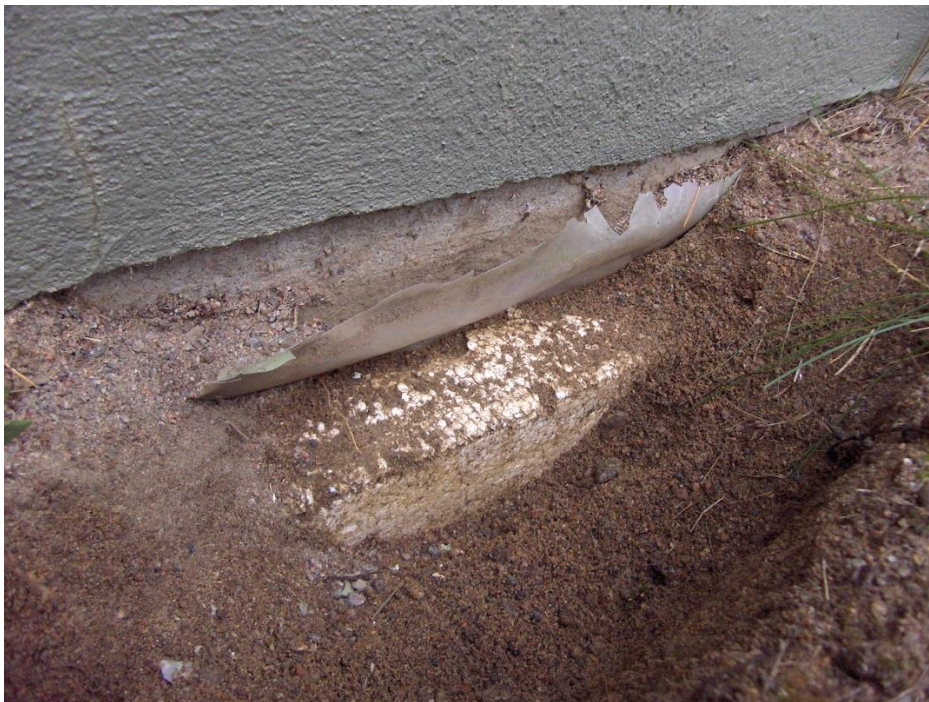
Kuva 13 Perusmuuria vasten on asennettu 50mm styroksi sekä muovi poistetaan.
