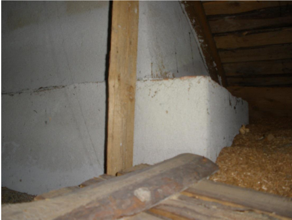
Kuva 35 Savupiippu on rapattu asianmukaisesti.
