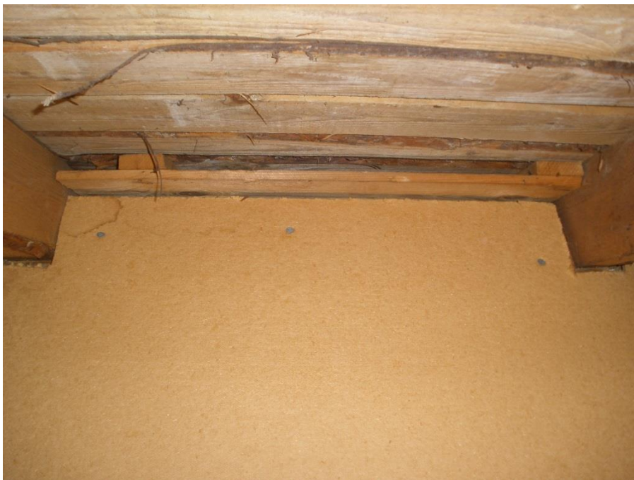
Kuva 24 Tuuletusrako löytyy eli riskirakennetta ei ole.
