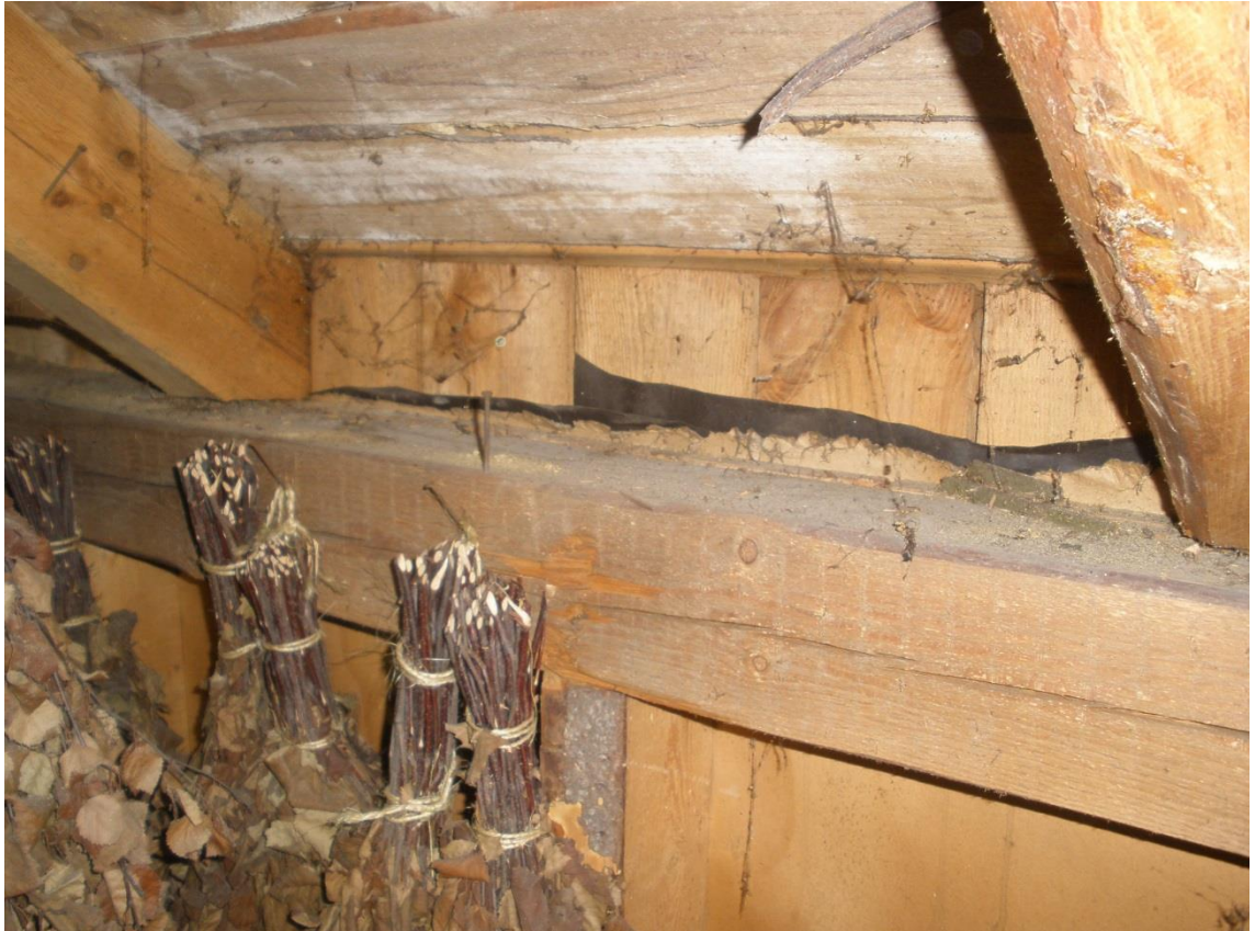
Kuva 17 Kylmällä sivuvintillä näkee ulkoseinärakenteen. Ulkovuoren alla on tervapahvi tuulensuojana ja sen alla oksamassapahvi.
