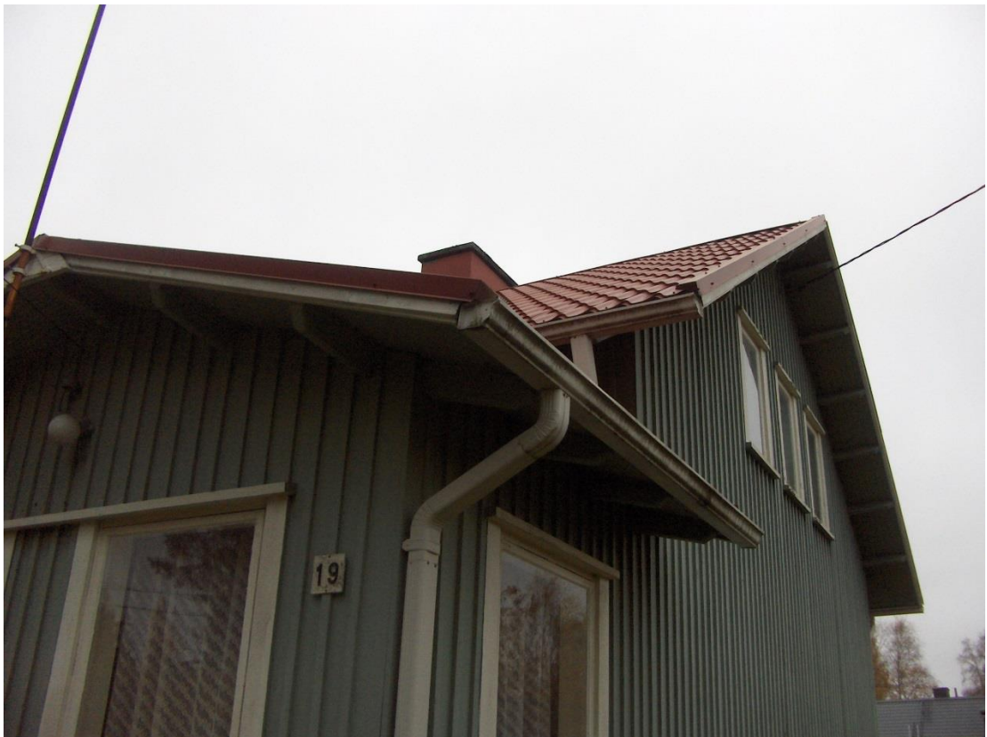
Kuva 8 Vesikourut on puhdistettava lehdistä sekä havunneulasista.
