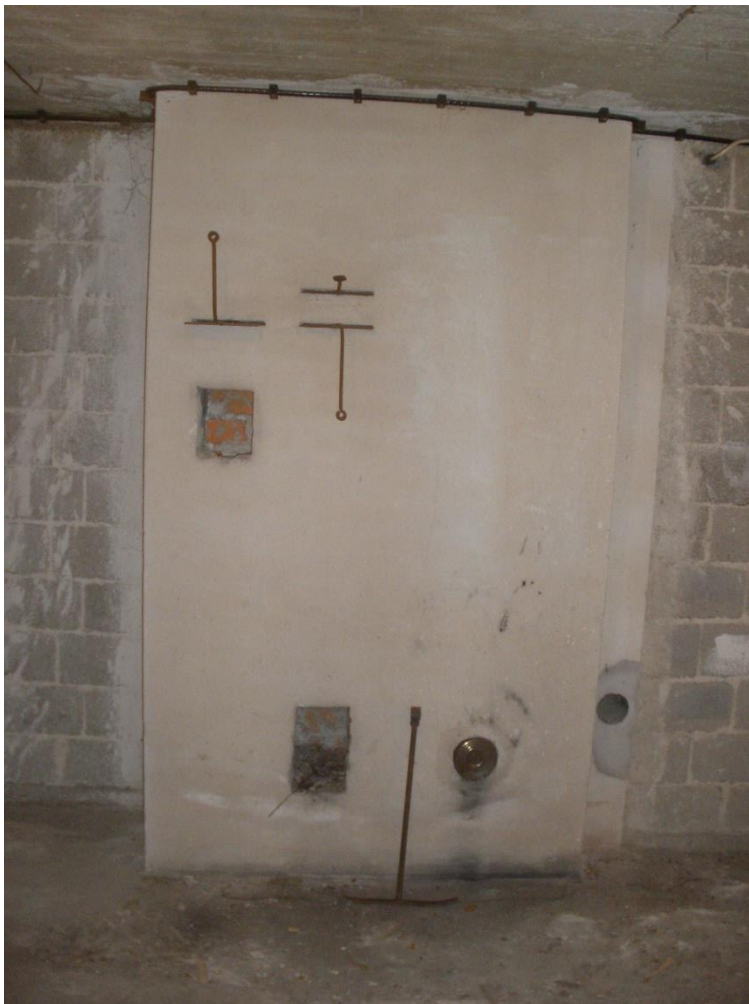
Kuva 37 Savupiippu alkaa kellarikerroksen pohjalta ja siinä on vapaita hormoneja.
