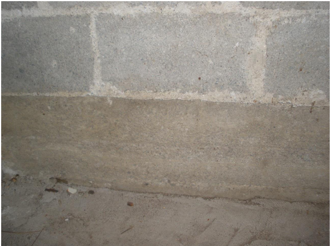
Kuva 9 Tell-tiili sekä sen alla oleva betonista valettu antura.
