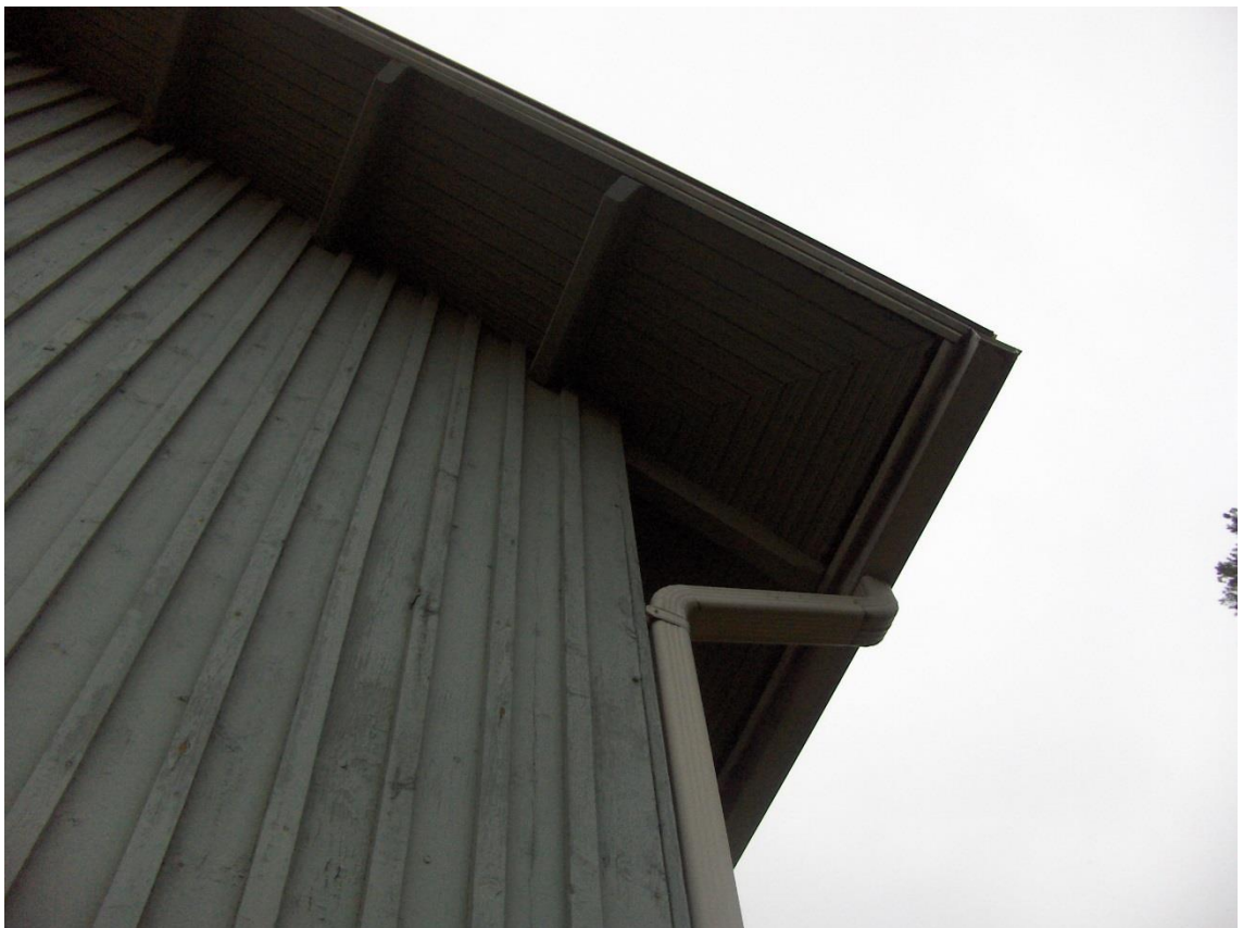
Kuva 33 Räystäään alusrakenteessa on kaunista 1950-luvun arkkitehtuuria.
