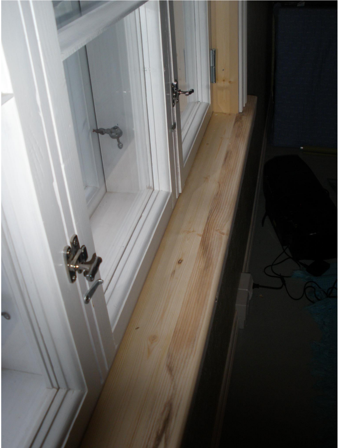
Kuva 27 Ikkunapenkin kokonaissyvyys on tässä noin 11cm.
