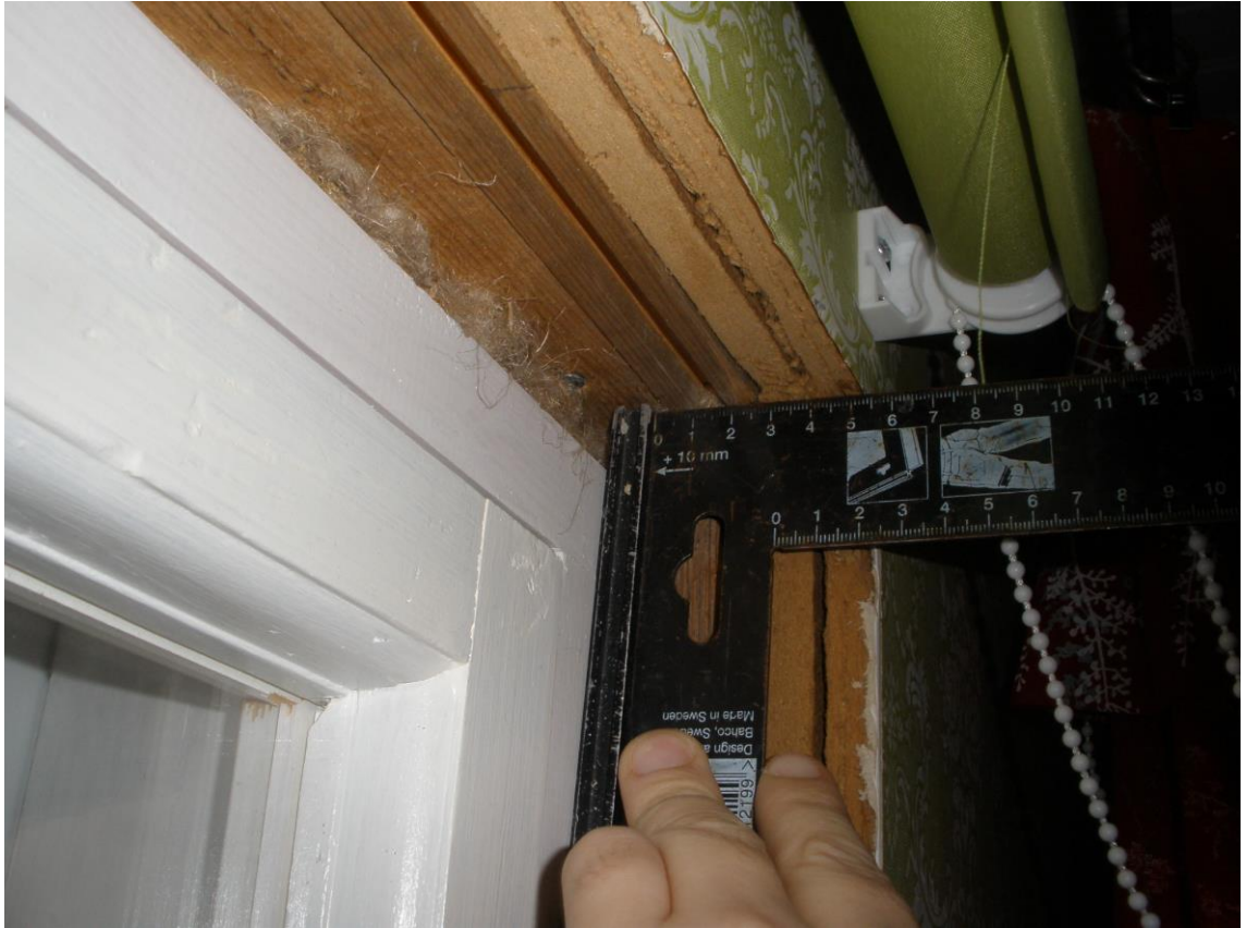
Kuva 11 ...ja molemmat ylänurkat mitataan.
