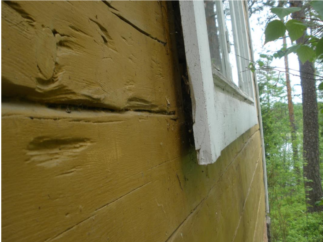
Kuva 1 Huvilan ikkunat on asennettu alkuperäisratkaisuna tuuman verran seinästä ulos, jotta ikkunat eivät jäisi syvennykseen ulkovuorauksen lisäämisen jälkeen. Ulkuvuoraus on jäänyt tästä huolimatta asentamatta.
