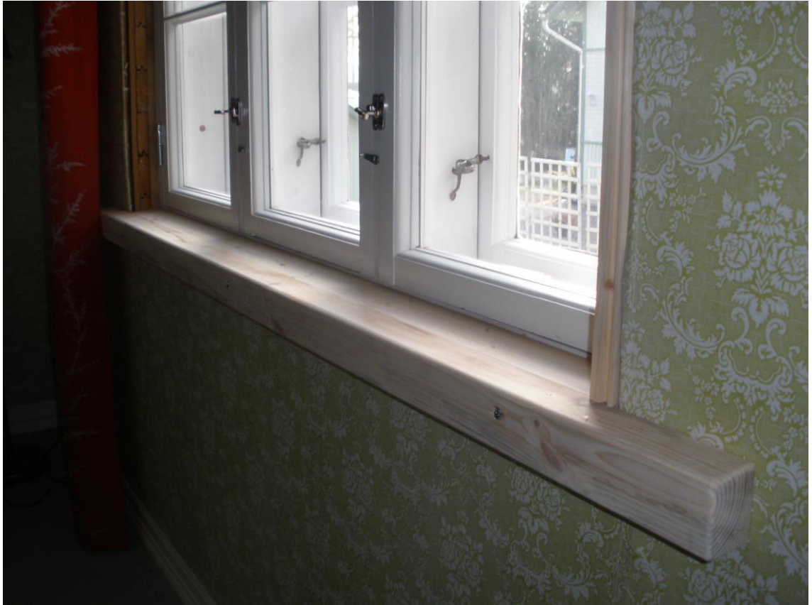
Kuva 20 Ikkunapenkkiä kokeillaan paikalleen ja tehdään vaadittavat hienosäädöt.
