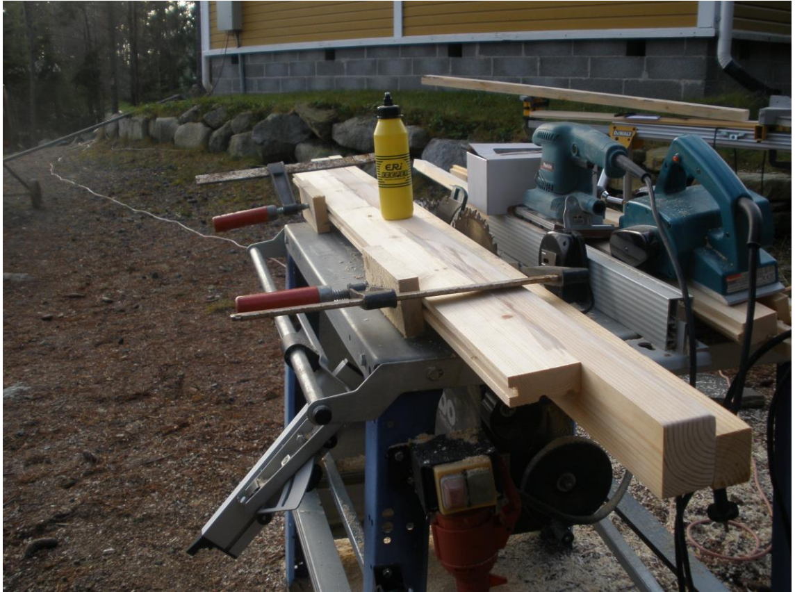
Kuva 19 Hiottu ikkunapenkki ja kavennettu lattialauta liimataan kiinni toisiinsa. Liiman kuivuttua liitossauma hiotaan tasaiseksi.
