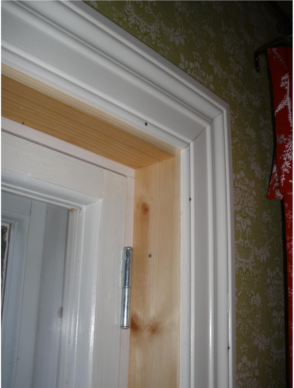
Kuva 24 Listan kiinnitys tehdään pienillä nauloilla smyygiin ja isommilla nauloilla seinään.
