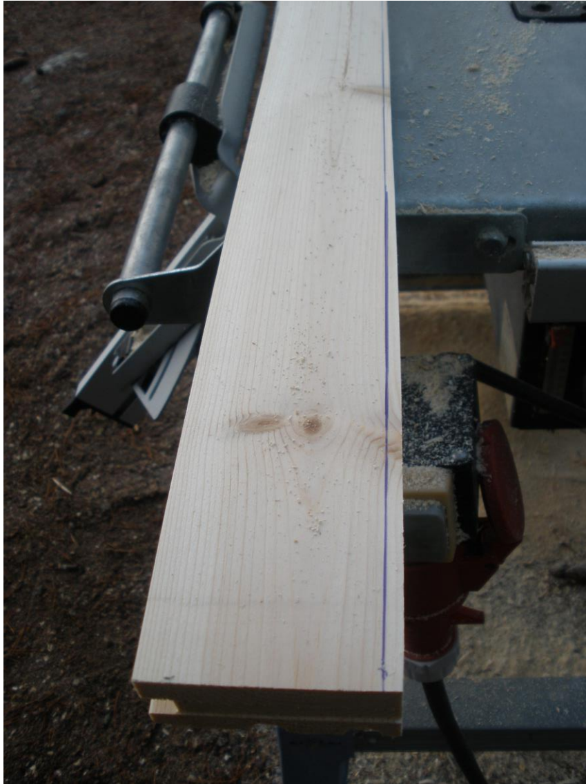
Kuva 18 Lattialauta kavennetaan sopivaan syvyyteen. Raakatyöstö kannattaa tehdä sirkkelillä ja viimeiset pari millää höylällä.
