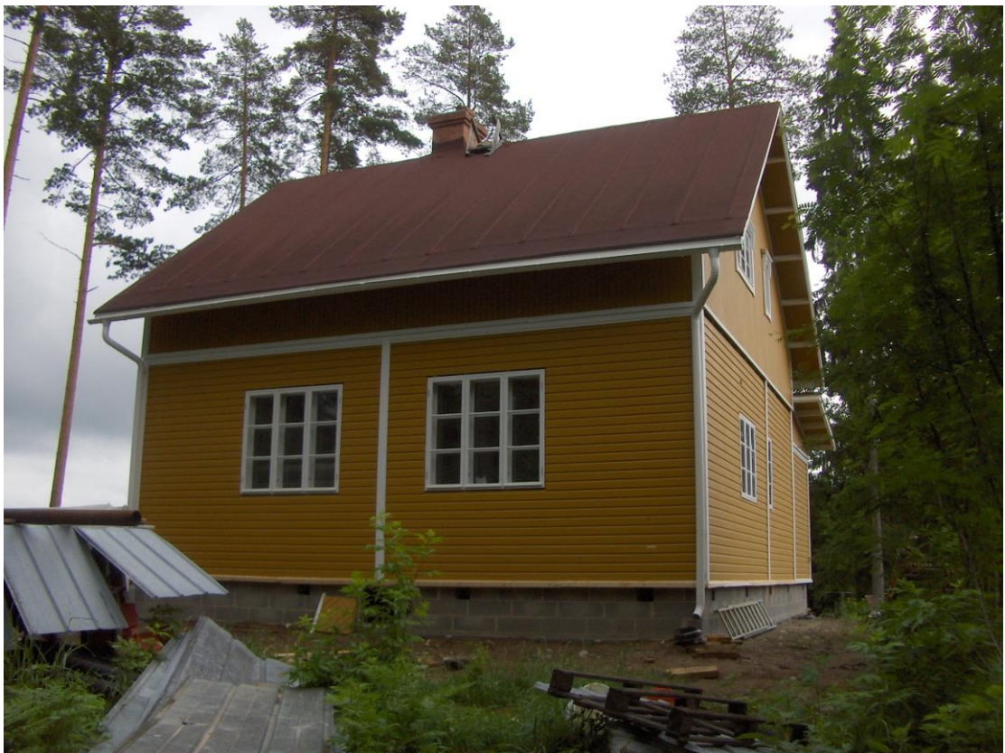
Kuva 6 ...ikkunoita siirretään ulospäin seinälinjan kanssa samaan tasoon.
