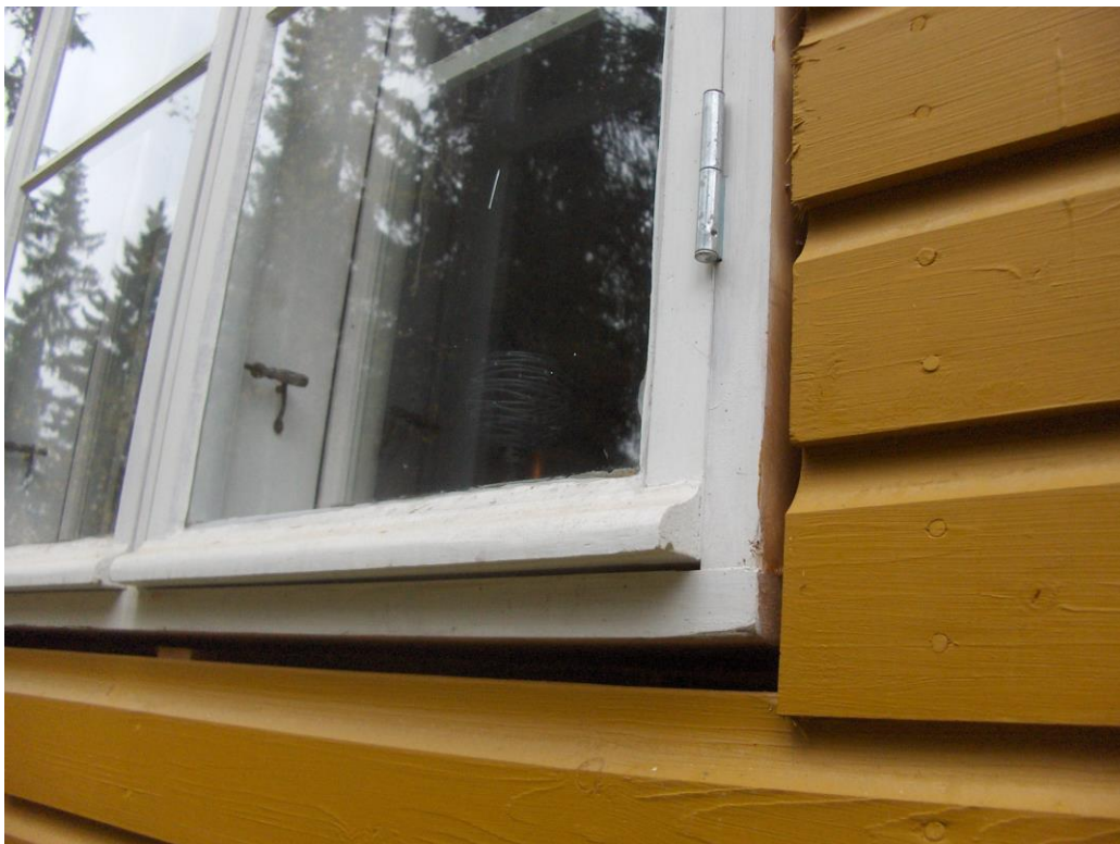
Kuva 1 Huvilan ikkunat on asennettu alkuperäisratkaisuna tuuman verran seinästä ulos, jotta ikkunat eivät jäisi syvennykseen ulkovuorauksen lisäämisen jälkeen. Ulkuvuoraus on jäänyt tästä huolimatta asentamatta.
