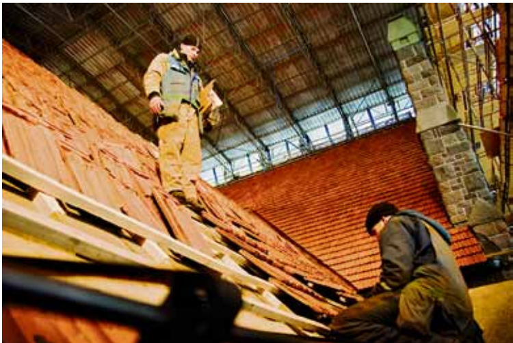
Tampereen tuomiokirkon korjaustöitä tehtiin vuonna 2006.
