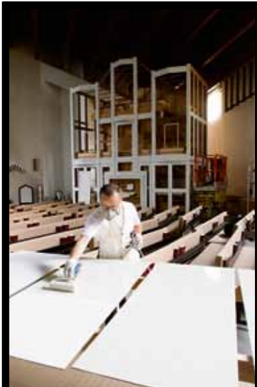
Aarre Salminen maalaa pohjamaalilla uusien urkujen julkisivulevyjä elokuussa.
