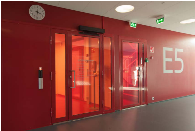
Tipotien sosiaali- ja Terveysasema Tampereella on varustettu Teknowaren turvavalaistusjärjestelmällä
