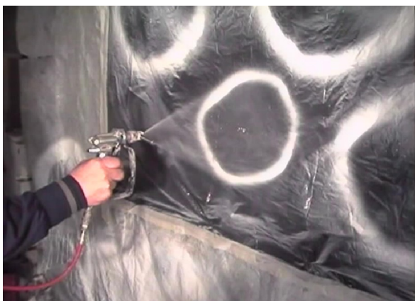
TC:n kehittämä kartiosuutin mahdollistaa putkien ja piippujen keraamisen eristämisen myös sisäpinnoille
