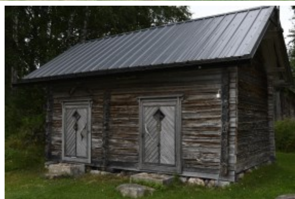
Pentti Karjalaisen isä Teuvo on rakentanut v. 1947 aittarakennuksen, jonka Pentti on täydellisesti kunnostanut.
