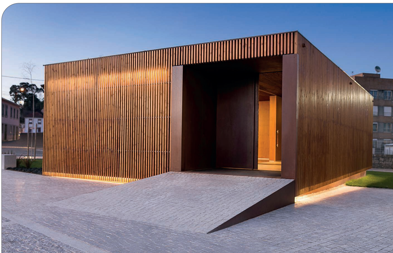
Kuva 67. ThermoWood®-ulkoverhous kirkon seinässä (Portugal).
