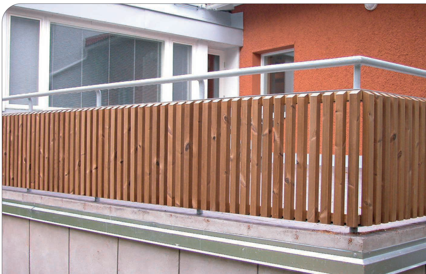
Kuva 66. ThermoWood®-rimoitus parvekkeen kaitteessa.
