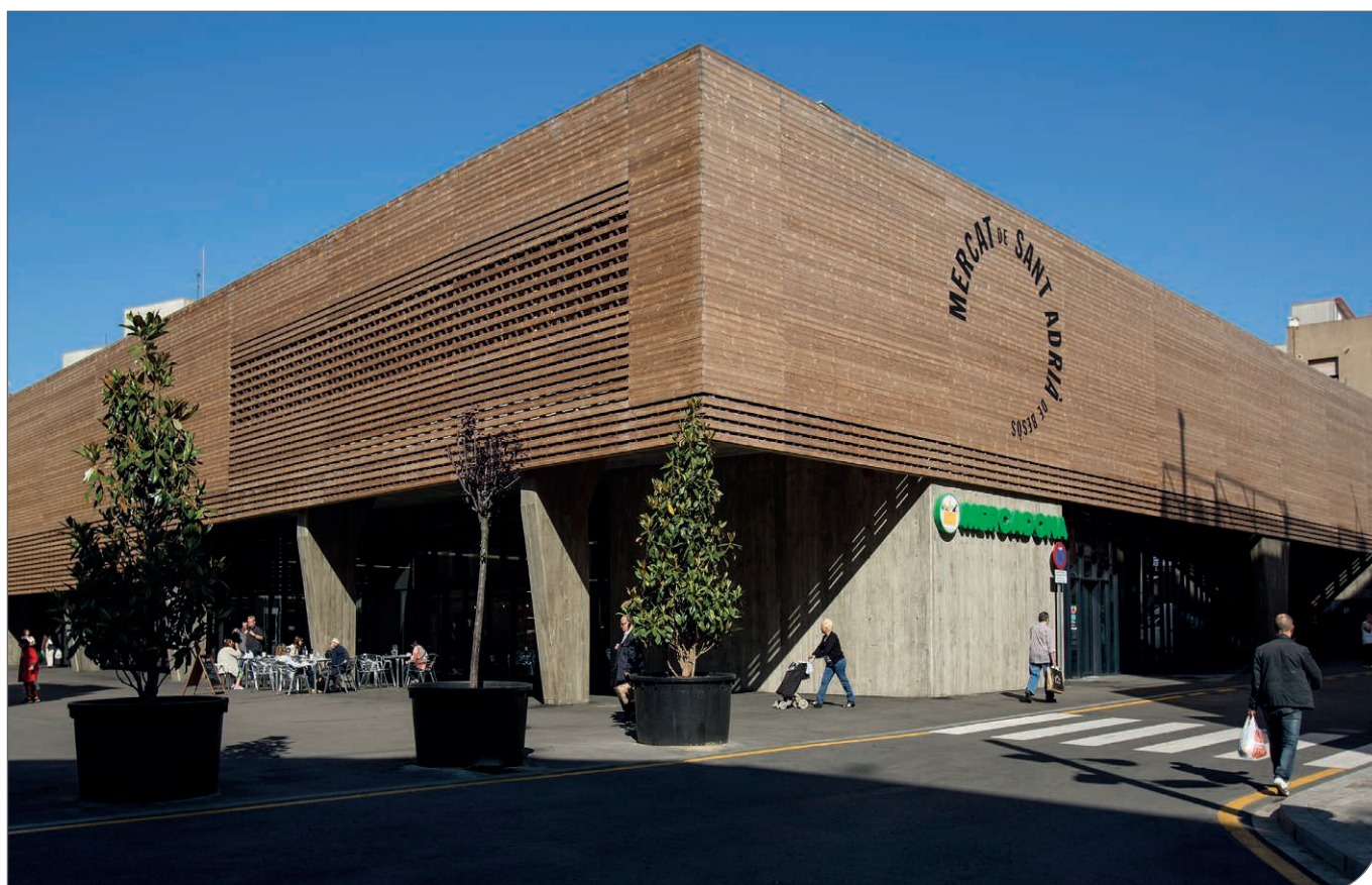
Kuva 63. ThermoWood®-ulkoverhous kauppakeskuksen seinässä (Espanja).
