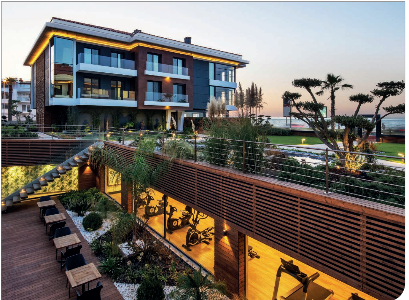
Kuva 21. ThermoWood® -tuotteita ulkoverhouksessa ja koristerimoituksissa.
