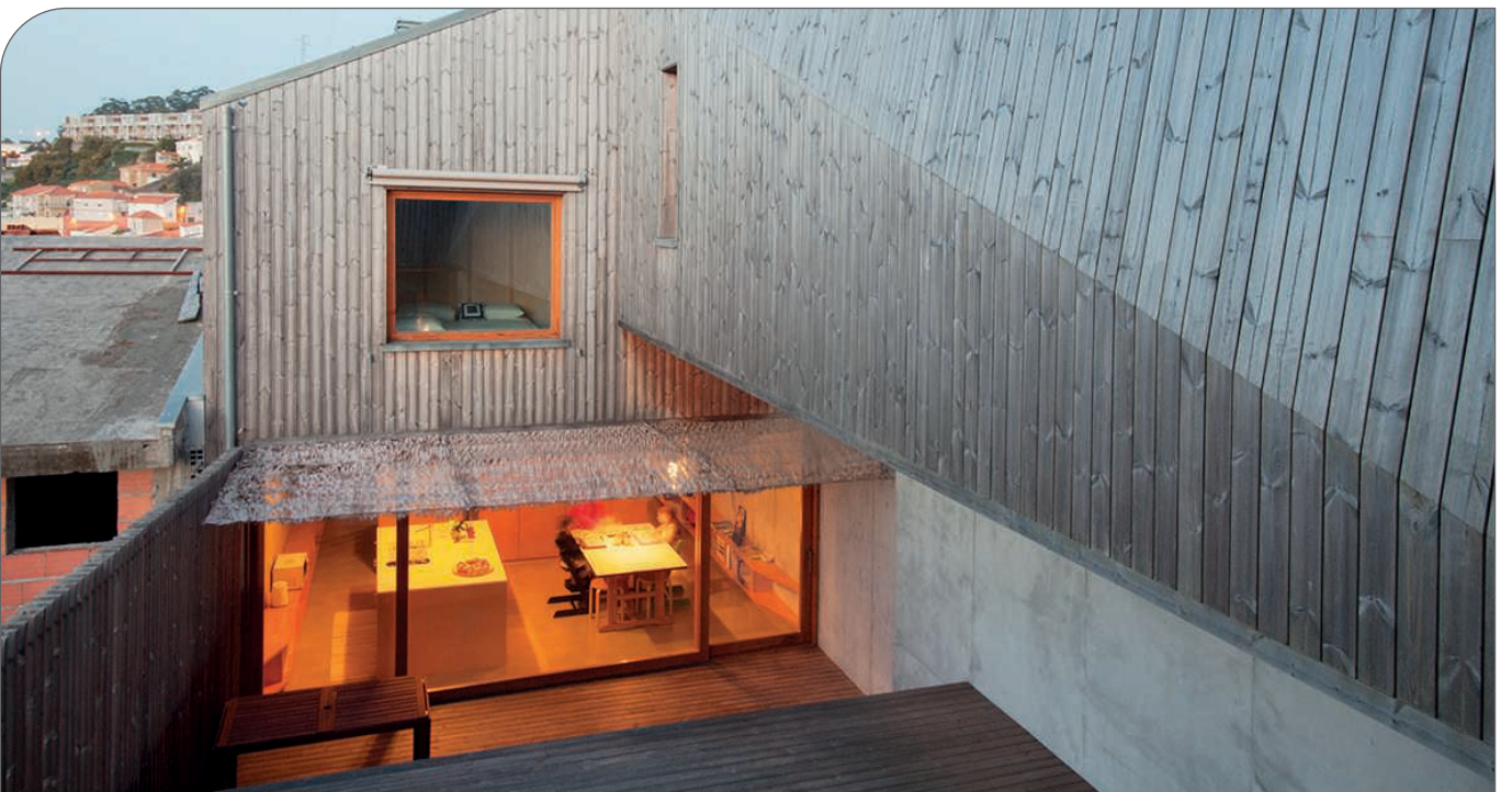
Kuva 61. Luontaisesti harmaantunut ThermoWood®-ulkoverhous (Portugal).
