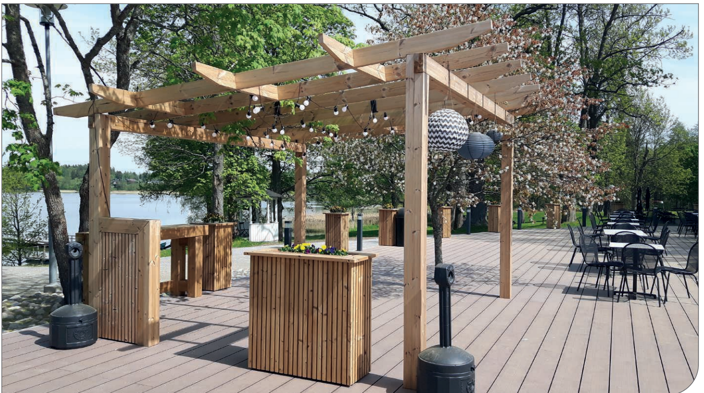
Kuva 33. ThermoWood®-tuotteita pergolan rakenteissa.
