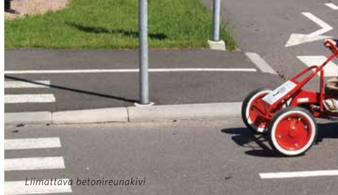
Liimattava betonireunakivi h=80, madalluskivi ja betonireunakivi h=60
