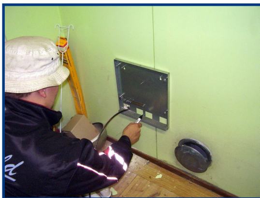
Kuitu tuotu sisään jakokaapin pohjan läpi
