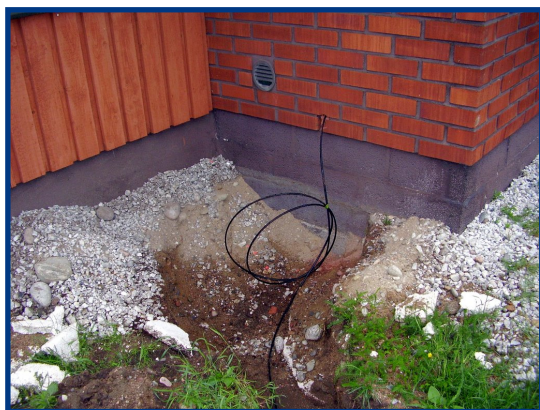
Kuidun muutosvarakieppi ja läpivientireikä
