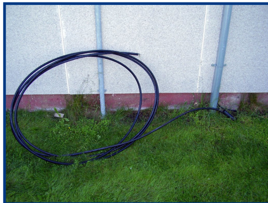
Kuitu tuotu putken läpi
