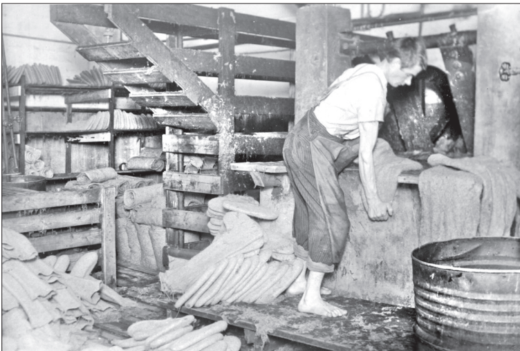
Vilttauksessa huopan kutistettiin höyryn ja paineen avulla. Työ oli hikistä ja fyysistä hommaa.
