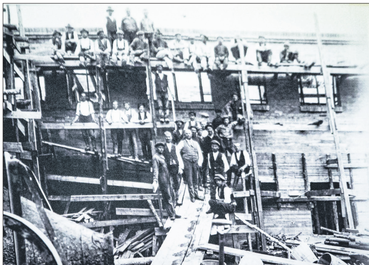
Kustaa Vuolle-Apiala (edessä keskellä) rakennutti uuden tehtaan työntekijöidensä avustuksella.
