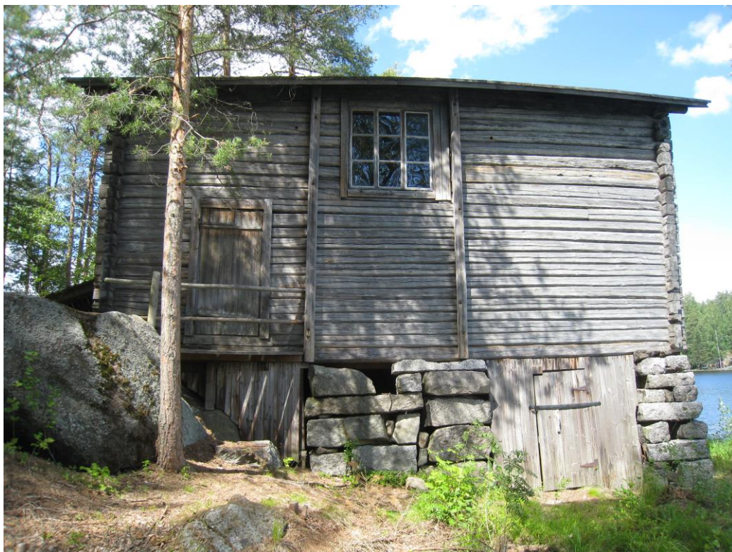
Koskelan mylly Jämsänkosken Aarresaarella 2016. Oikealla alhaalla laudoitettu osa on suuren vesirattaan kohta, vasemmalla olevasta ylemmästä ovesta päästään koneistotasolle.
