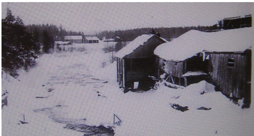
Kuva myllystä ja saharakennuksesta vuodelta 1952 ennen purkamista. Vesirakenteet ja silta oli purettu uuden padon rakentamisen vuoksi.
