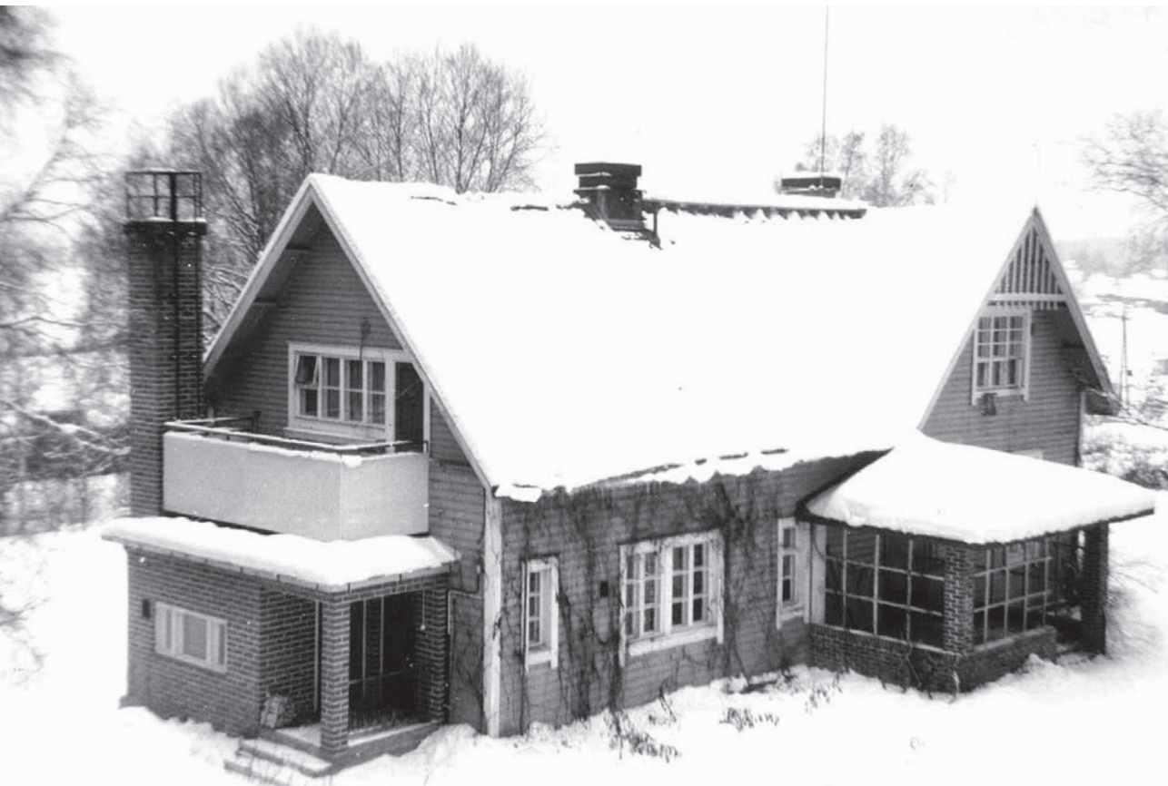
Niilo Vuolle-Apialan perheen talo Raivio Keuruulla. Talo on purettu 1980-luvulla.
