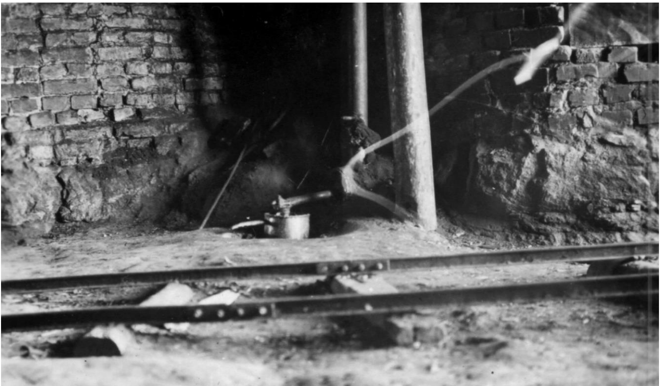
Koskenpään tervatehtaan ensimmäisten pystyretorttien alaosat ja halkovaunujen kiskot. Retorttien perustukset olivat tämän kuvan mukaan luonnonkivistä ja suojamuuraukset epämääräistä ja heikkoa muuraustekniikkaa. Keskellä näkyy putkistoja ja säiliö johon koottiin lähinnä tervavettä polton alkuvaiheessa. Kuva V-A sukuarkisto.
