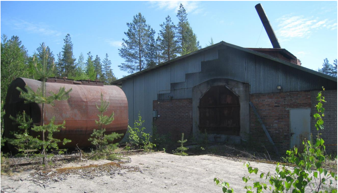
Kuva Uuraisten Kangashäkin tervatehtaasta. Se lopetti toimintansa vuoden 2010 tienoilla. Tehdas toimi yhdellä vaunuretortilla, joka työnnettiin kiskoja myöten rakennuksen päädyssä olevan luukun kautta polttouuniin. Kuva RVA 2018
