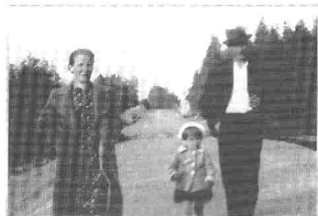
Agda, Irja ja Niilo Jäälinnä kävelyllä 1936 uudella rakenteilla olevalla Turuntielle.
