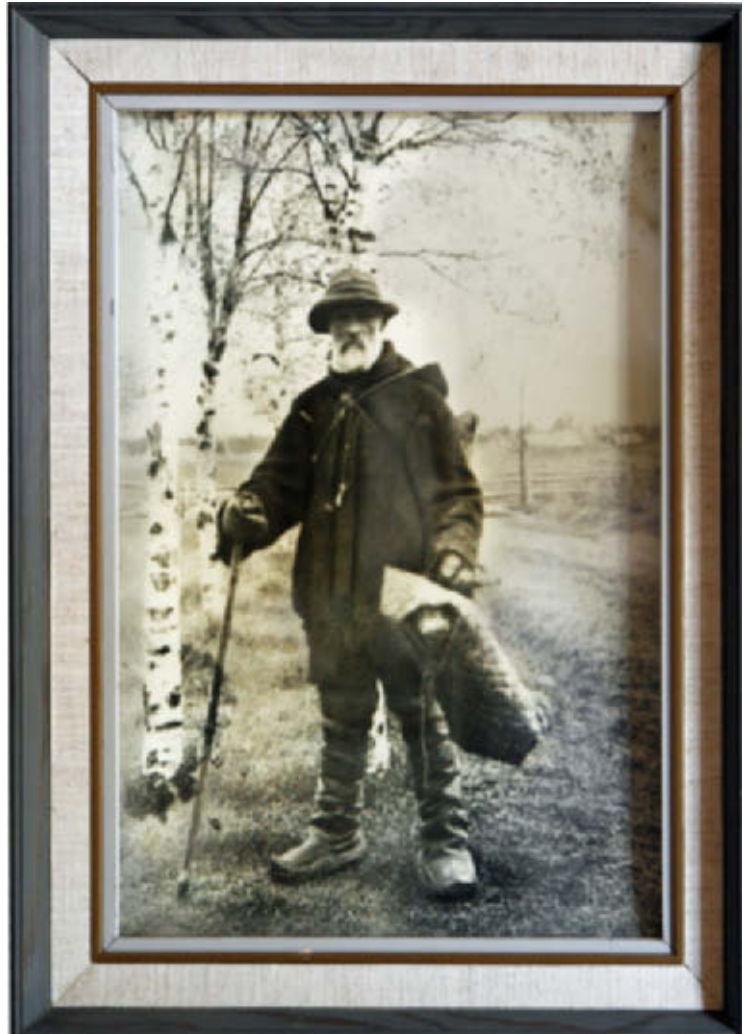
Mestari-Heikiltä ojankaivuu sujui. Oman ilmoituksensa mukaan hän kaivoi 140 km ojia.
