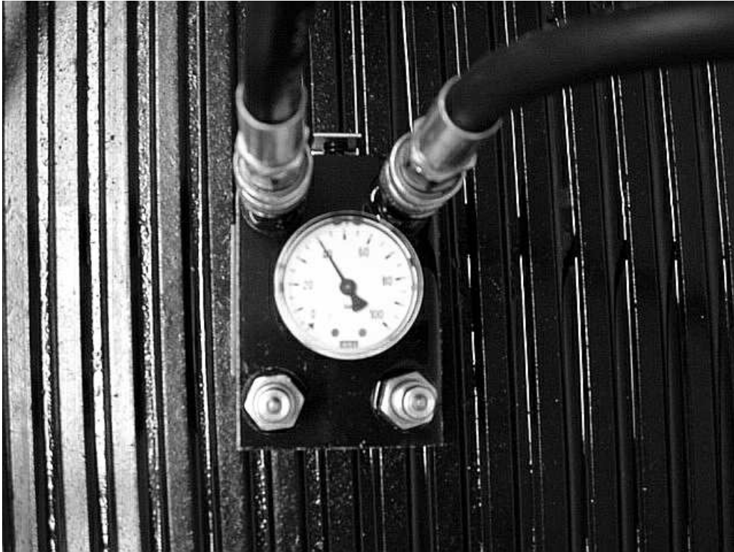
Kuvio 13 Järjestelmään ”kuristettu” 40 bar:n paine tilavuusvirran säätöyksiköstä
